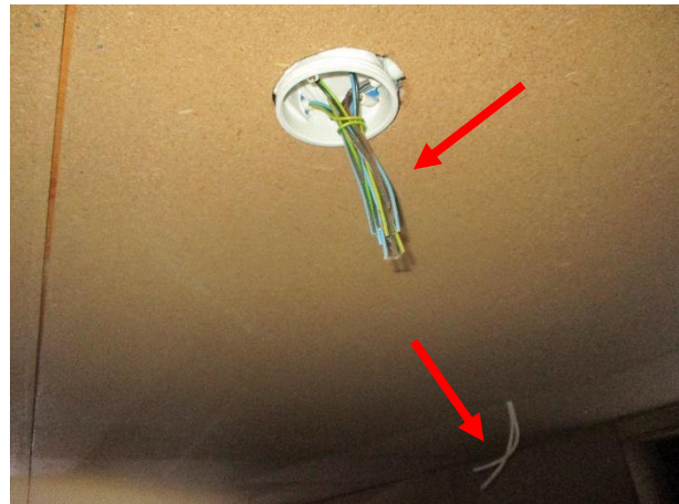
Varastotilan sähköjen asennus on kesken.
