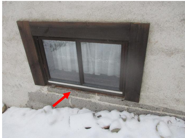
Ikkunoissa ei ole vesipeltejä, mutta pitkät räystäät suojaavat osaltaan ikkunarakenteita.
