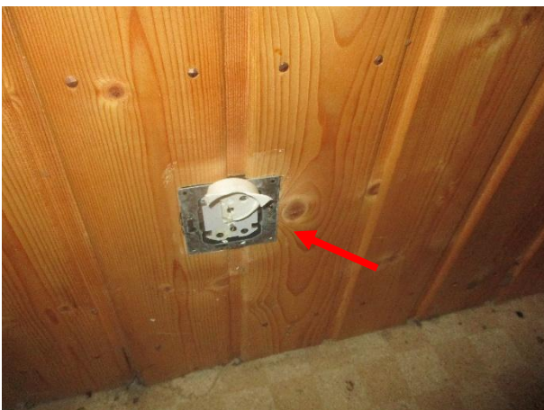
Asuintiloissa oli havaittavissa avonaisia / rikkonaisia sähkörasioita ja avonaisia sähköjohtoja.
