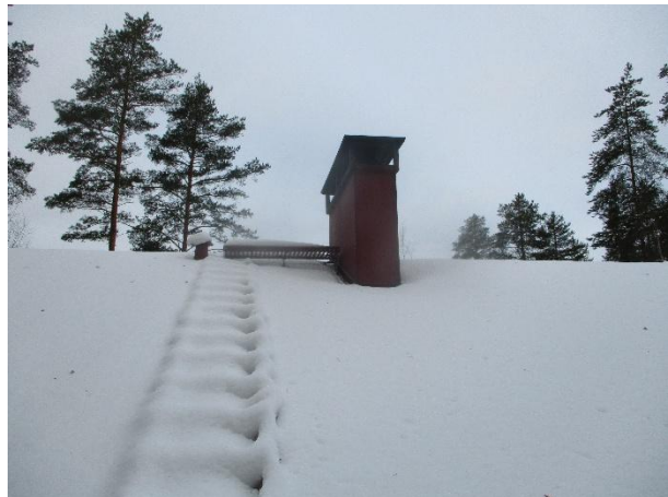
Savupiippu on pellitetty ja sen päällä on suojahattu.
