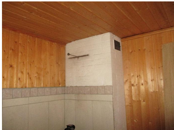
Alakerrassa on kamiina. Tulisijan ja hormin / palomuurien pinnoilla ei havaittu merkittäviä vaurioita ja edustalla on laatoitus.
