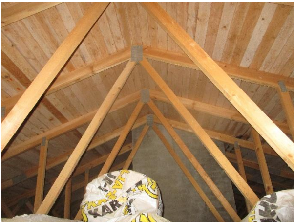
Rakennuksen yläpohja on puurakenteinen.
