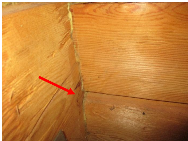
Asuintilojen hirsiseinissä havaittiin yksittäisiä vanhoja kosteuden aiheuttamia jälkiä, jotka ovat todennäköisesti rakennusvaiheessa aiheutuneita.
