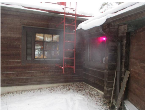
Vesikatolle on kiinteät talotikkaat.
