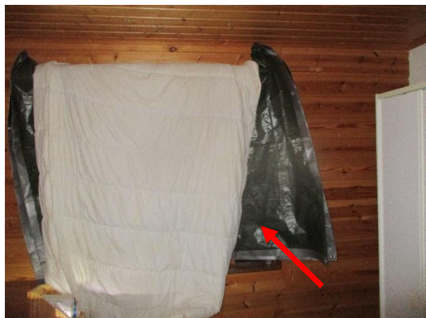
Ikkunoiden välissä oli havaittavissa kosteuden aiheuttamia jälkiä ja osa ikkunoista oli huurussa (kosteutta tiivistynyt ikkunoiden väliin). Osa ikkunoista oli peitetty peitoilla, lakanoilla tms.
