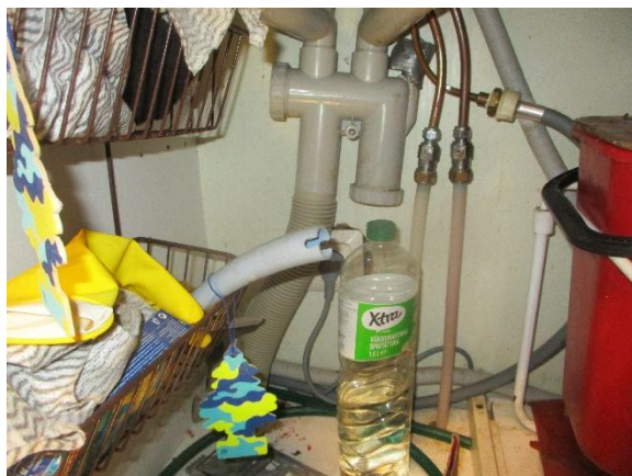
Tarkastushetkellä allaskaapissa ei ollut havaittavissa merkittäviä vaurioita tai vuotoja.
