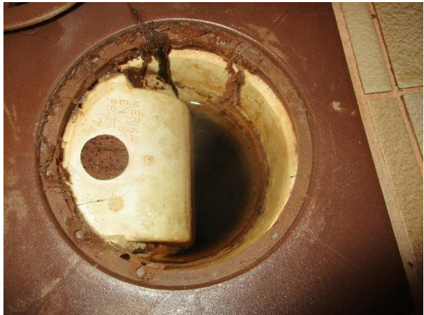
Päällisin puolin pesuhuoneen lattiakaivossa ei havaittu poikkeavaa / vaurioita.
