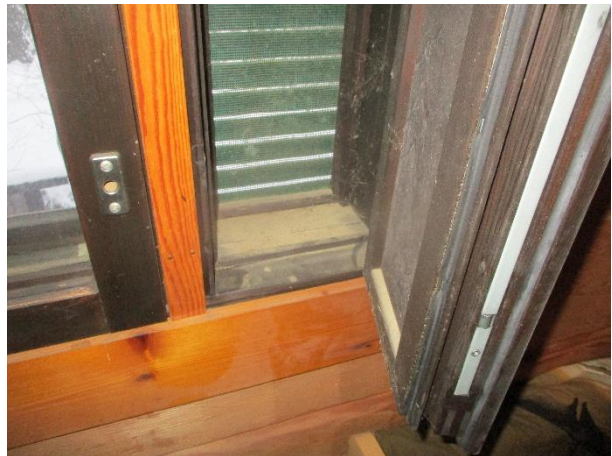
Ikkunat ovat alkuperäisiä 3-lasisia ja puupuitteisia ikkunoita. Osassa ikkunoissa on tuuletusluukut.
