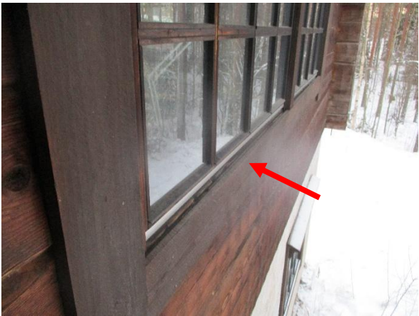
Ikkunoissa ei ole vesipeltejä, mutta pitkät räystäät suojaavat osaltaan ikkunarakenteita.
