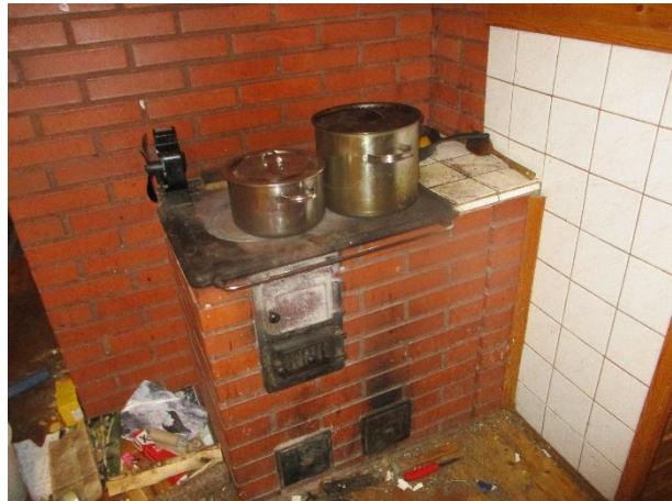
Yläkerrassa on leivinuuni ja puuhella. Tulisijojen ja hormin / palomuurien pinnoilla ei havaittu merkittäviä vaurioita ja edustoilla on kipinäpellit.
