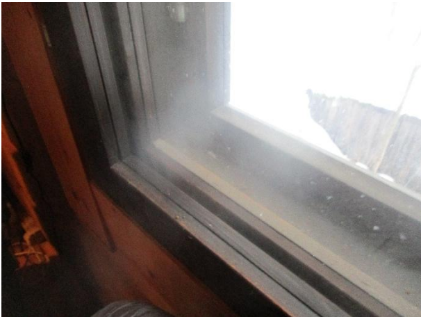
Ikkunat ovat alkuperäisiä 3-lasisia ja puupuitteisia ikkunoita. Osassa ikkunoissa on tuuletusluukut.
