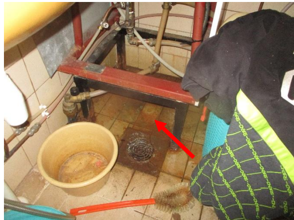
Tulovesiputki ja lämminvesivaraaja sijaitsee wc:ssä. Lämminvesivaraaja vuosi useasta kohtaa ja se on korjattava / uusittava välittömästi.
