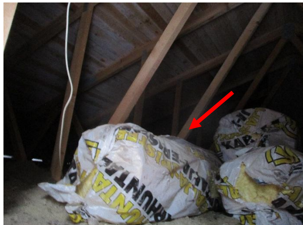
Huoltoluukun edustalla oli säilöttynä villaeristepaketteja.
