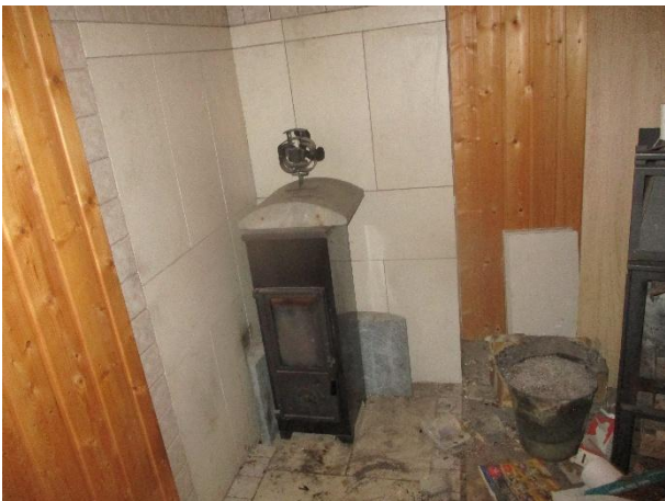
Alakerrassa on kamiina. Tulisijan ja hormin / palomuurien pinnoilla ei havaittu merkittäviä vaurioita ja edustalla on laatoitus.
