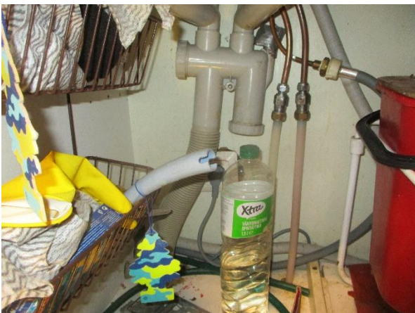
Käyttövesiputket ovat muovia / kuparia ja viemäriputket näkyviltä osin muovia.
