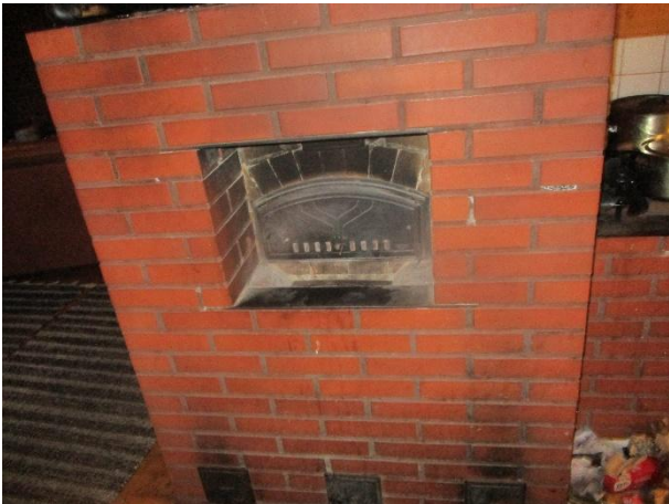
Yläkerrassa on leivinuuni ja puuhella. Tulisijojen ja hormin / palomuurien pinnoilla ei havaittu merkittäviä vaurioita ja edustoilla on kipinäpellit.
