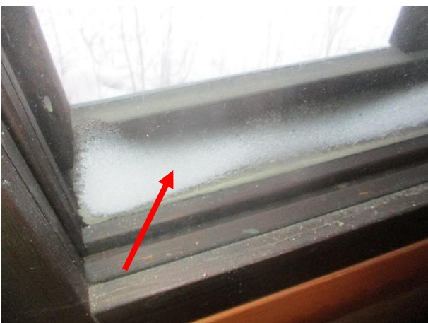
Ikkunoiden välissä oli havaittavissa kosteuden aiheuttamia jälkiä ja osa ikkunoista oli huurussa (kosteutta tiivistynyt ikkunoiden väliin). Osa ikkunoista oli peitetty peitoilla, lakanoilla tms.
