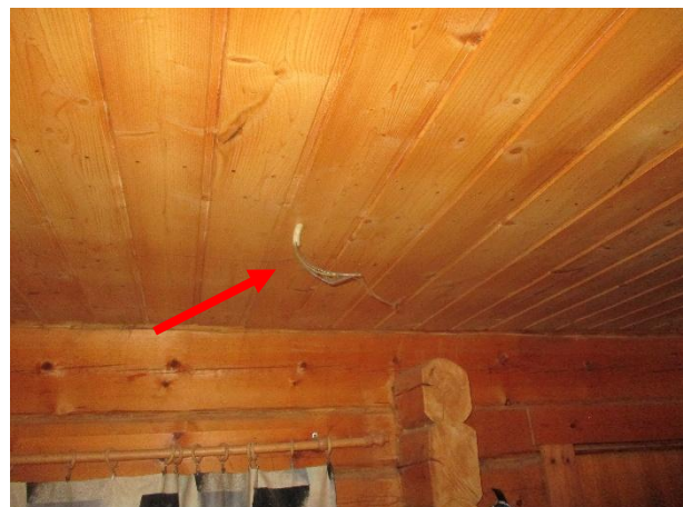
Asuintiloissa oli havaittavissa avonaisia / rikkonaisia sähkörasioita ja avonaisia sähköjohtoja.
