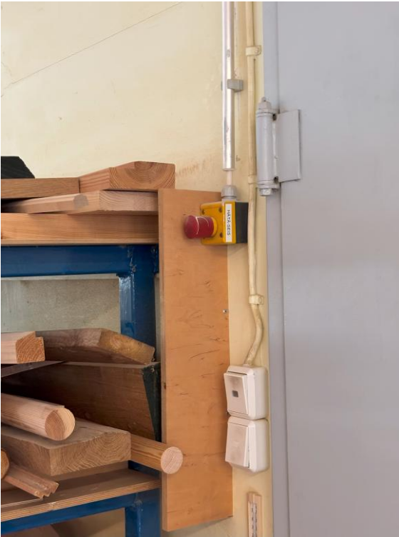
Kuva 1: Hätä seis -painike käyntioven vieressä. Painike on merkitty teippitulostimella, mutta merkinnän tueksi painikkeelle ei ole opastekylttiä. Painikkeen sijainti hyllyn vieressä voi vaikeuttaa sen havaitsemista.
