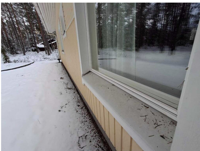
Kuva 5 Ikkunat on kolmikerroksiset, ulkopuoleltaan alumiinipintaiset. Ikkunoihin on liitetty vesipellitykset reunanostoin.
