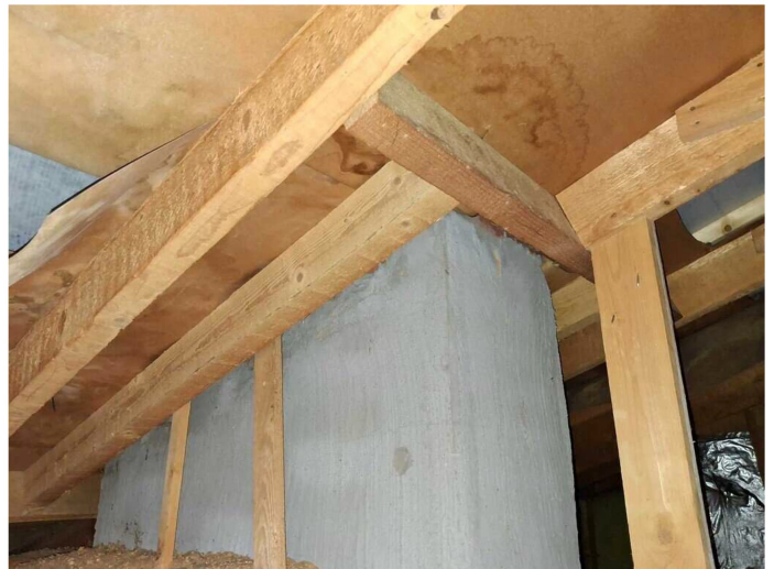
Kuva 9 Piipun kyljessä ei havaittu vuotojälkiä.
