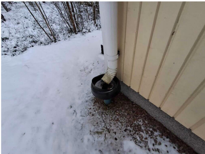
Kuva 3 Kattovedet on ohjattu syöksytorstista rännikaivoihin.
