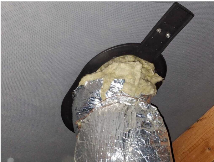
Kuva 8 Aluskatteen läpiviennit on tehty Vilpe-läpivientikappaleilla.
