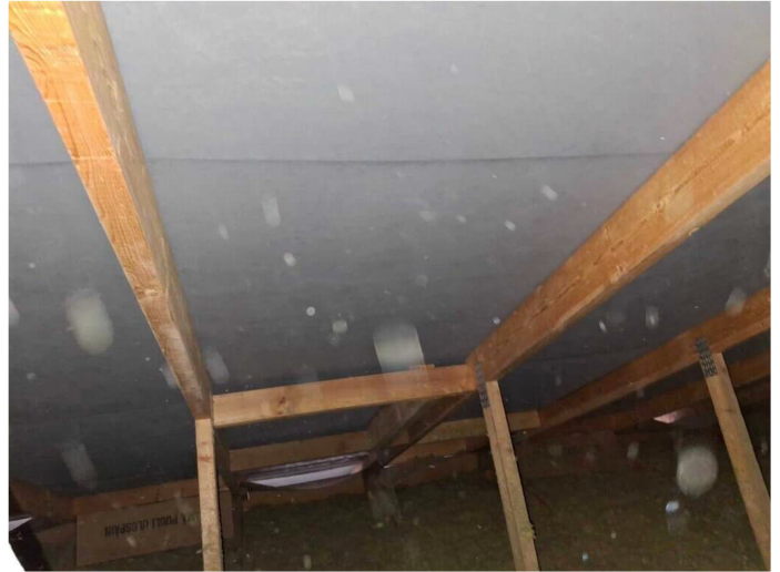
Kuva 7 Kattotuolit ovat tehdastekoiset ja reunoiltaan itsekantavat. Aluskatteen yläpuolella on korokerimoitus.
