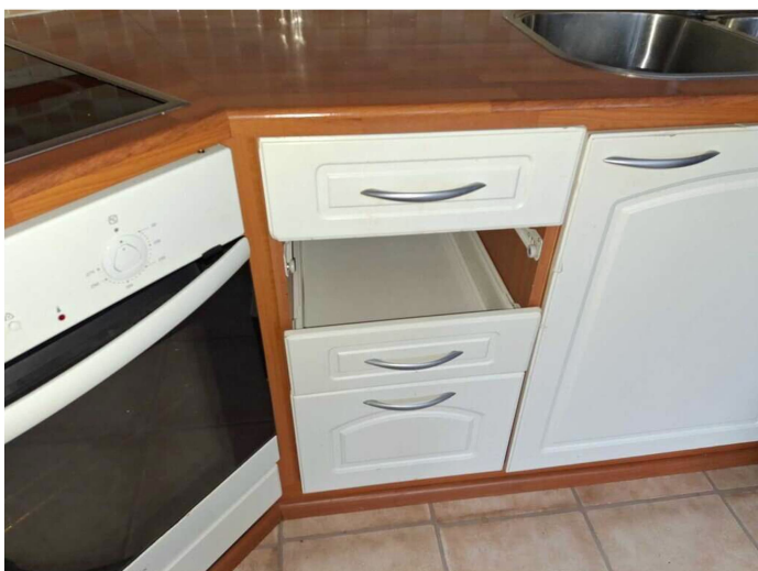
Kuva 24 Keittiön kalusteissa vaurioita.
