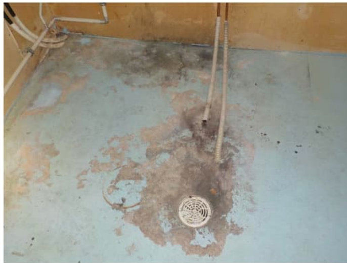
Teknisen tilan lattiaa.
