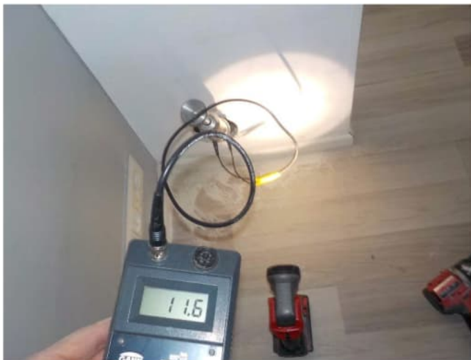
Väliseinän alasidepuun kosteuden mittaus.
