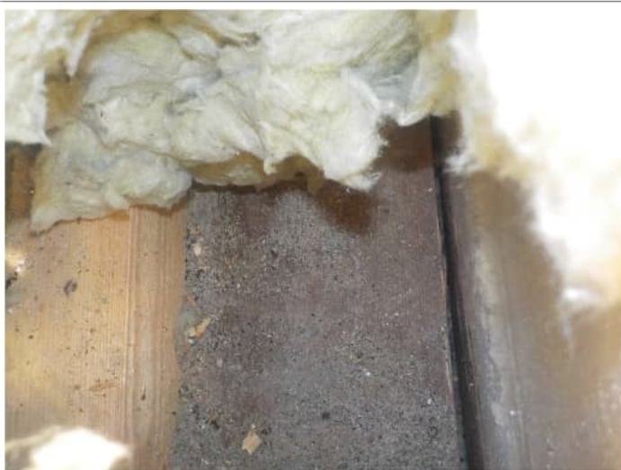
Ulkoseinän alaosan rasiapora-avaus.
