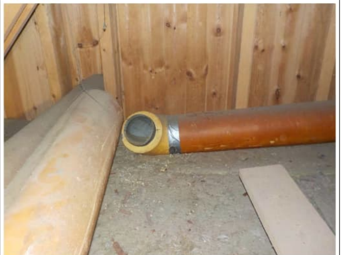
Kiinnityksestään irrotettu keittiön liesituulettimen vanha poistoilmakanava.
