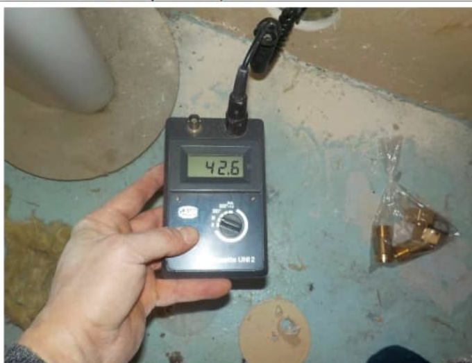
Ulkoseinän alimmaisten villaeristeiden suhteellisen kosteuden mittausta.
