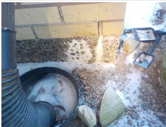
Nurkan sokkelin paikkau jälkiä.
