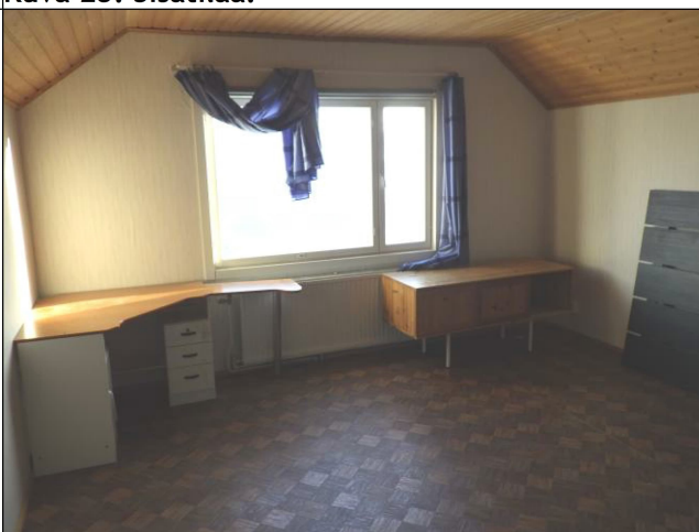
Kuva 25. Kosteuden aiheuttama jälki yläkerran katossa.
