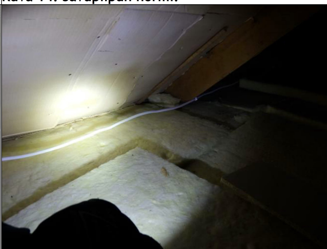
Kuva 16. Tuuletusrako puuttuu.
