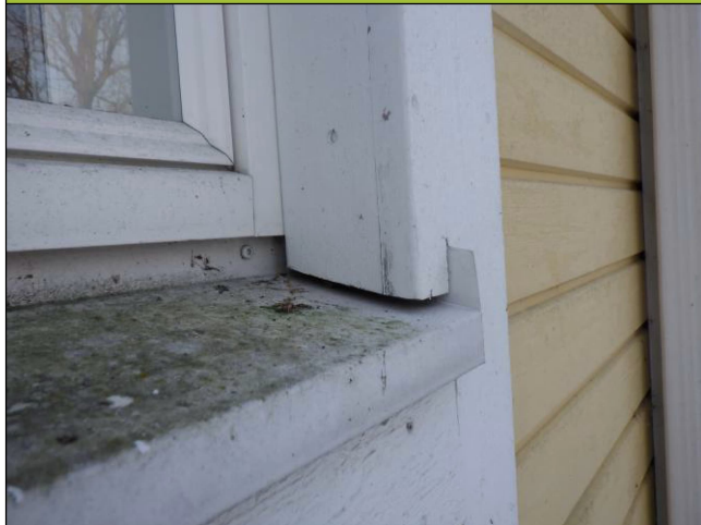
Kuva 9. Ikkunapellityksen toteutus asianmukais- ta.
