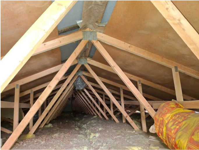
Kuva 10 Yläpohjan eristeenä on lasivillaa 250-300 mm.
