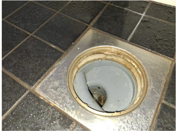
Kuva 31 Lattiakaivossa nähtävissä vedeneristeen vahvikekangas.
