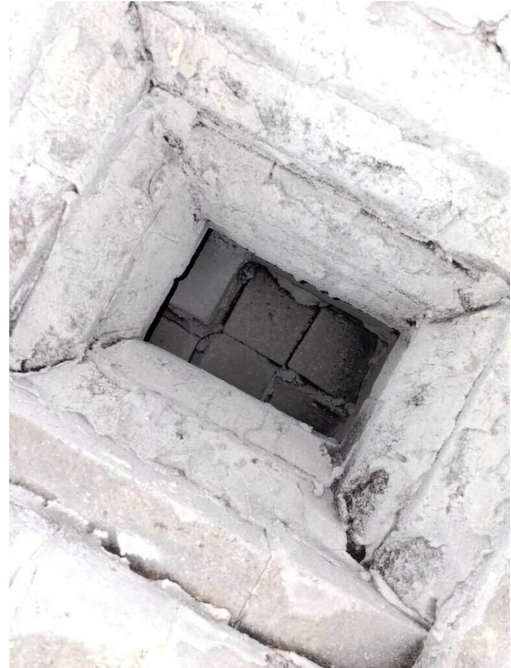
Kuva 27 Takan tulihormin rakenteissa ei havaittu vaurioita.
