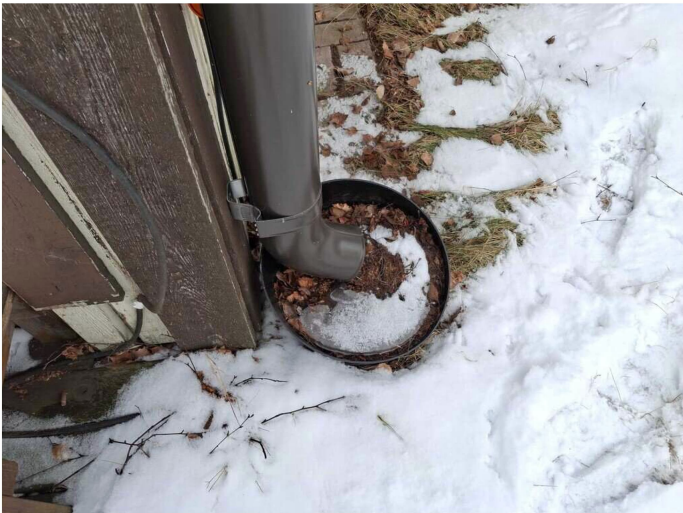
Kuva 4 Yhden syöksytorven alla on rännikaivo.
