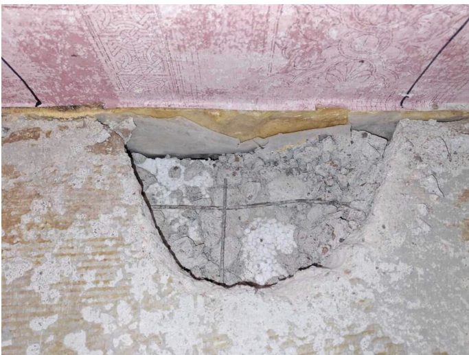
Kuva 12 Rakenneavauskohta makuuhuoneen ulkoseinän kohdalta. Teräsbetonilaatta ja 4 mm:n rauditusverkko, betonilaatan korkeus noin 80 mm.
