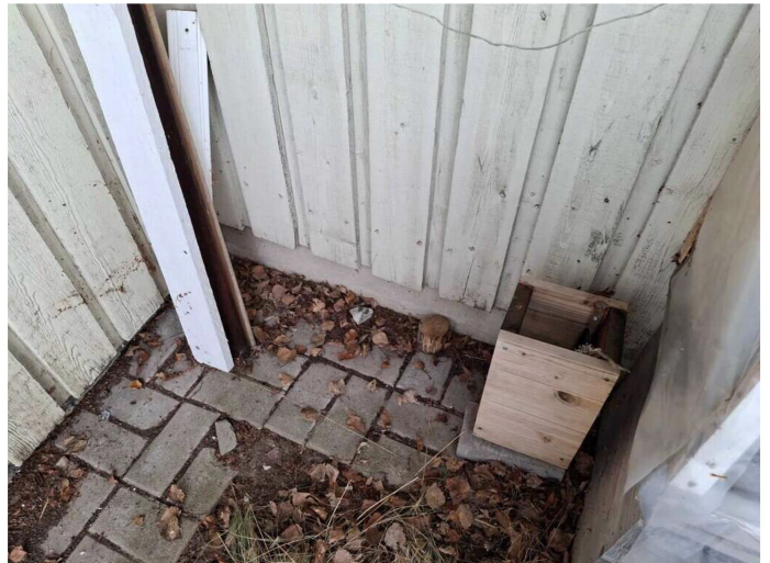
Kuva 5 Perustuksia vasten Raaminkadun puoleisella sivulla betonilaattoja.
