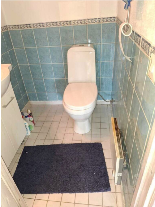
Kuva 34 Wc:n lattiapinnan kosteus normaali.
