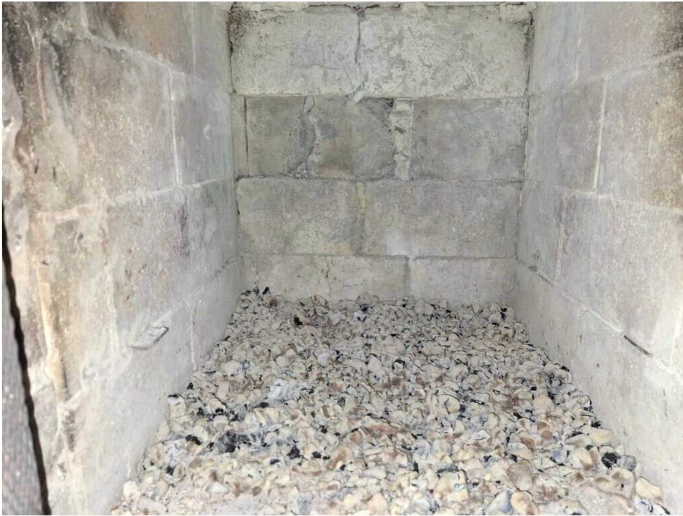
Kuva 26 Takan tulipesän rakenteissa ei havaittu vaurioita.
