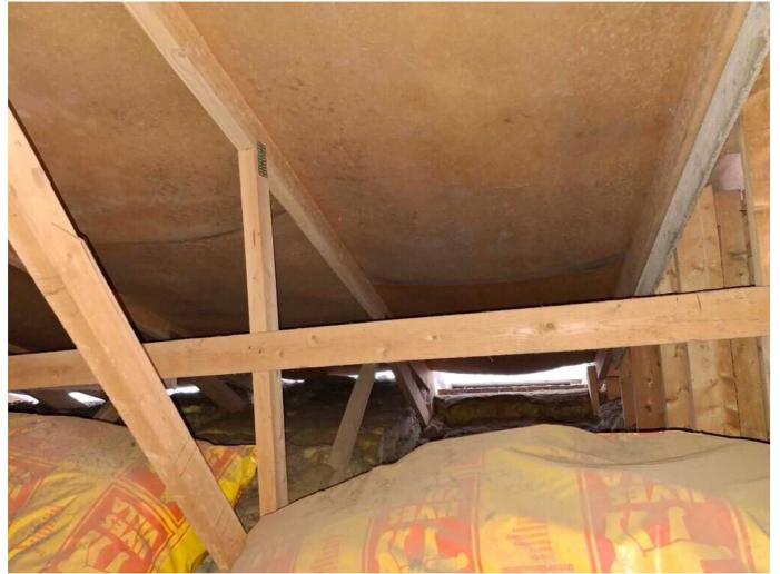
Kuva 11 Yläpohja tuulettuu räystäiden kautta.
