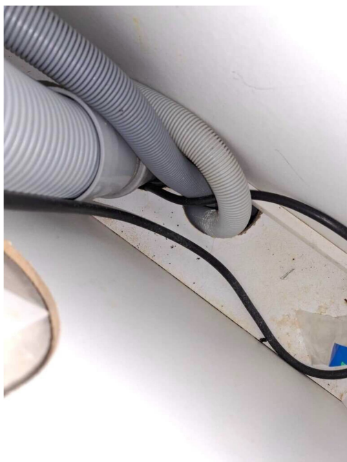
Kuva 24 Keittiön allaskaapin rakenteissa ei havaittu vaurioita.
