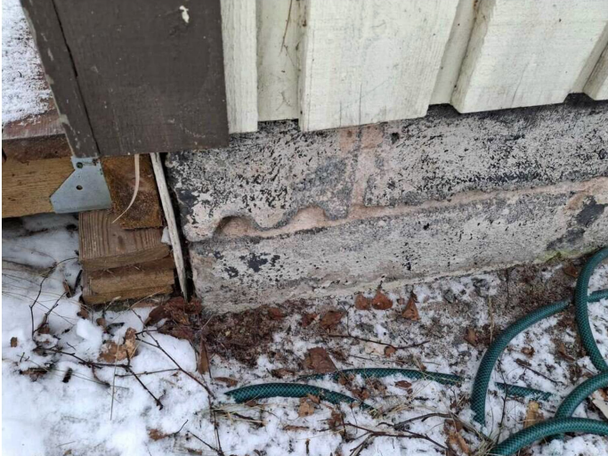
Kuva 2 Rakennus on perustettu teräsbetonianturoille , joiden päälle on muurattu Leca-harkkoista perusmuurit.
