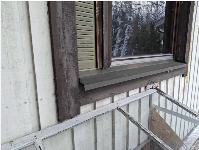
Kuva 8 Ikkunat ovat alkuperäiset kolmikerroksiset, puuosilla. Ikkunoihin on liitetty vesipellitykset reunanostoin.
