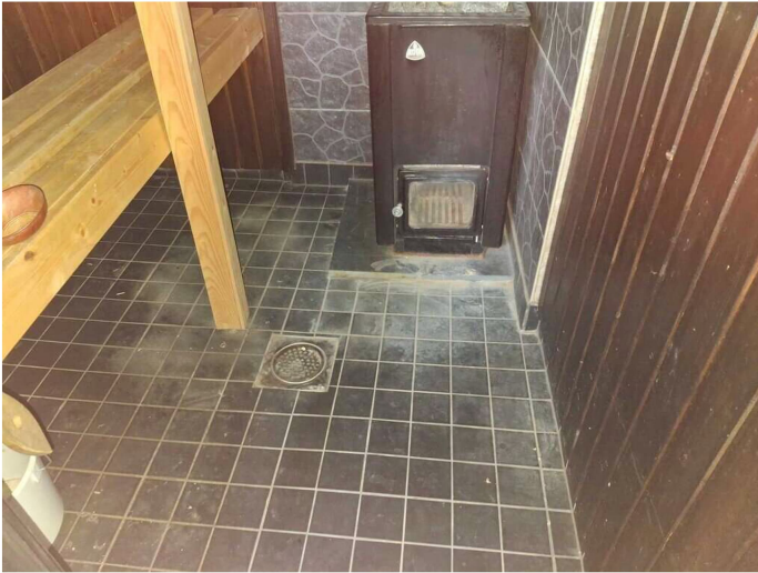
Kuva 30 Saunan lattiapinnan kosteus normaali.
