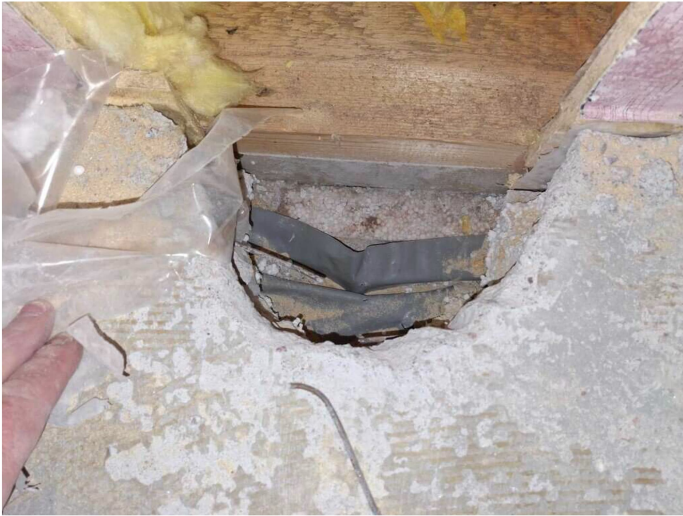
Kuva 14 Rakenteista ei tullut kosteusvaurioon viittaavaa hajua.
