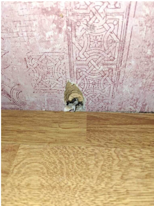
Kuva 16 Samasta huonetilasta tarkastettiin väliseinän alajuoksun sijainti. Alajuoksu on lattiapinnan tasalla.
