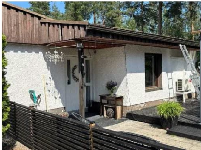
Julkisivuissa ei havaittu korjausta vaativia puutteita tai vaurioita.
