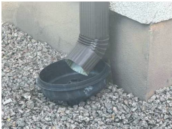
Sadevesien johtamisessa ei havaittu puutteita.
