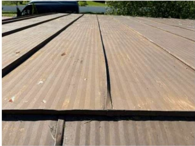
Vesikatteessa ei havaittu suoruuspoikkeamia.
