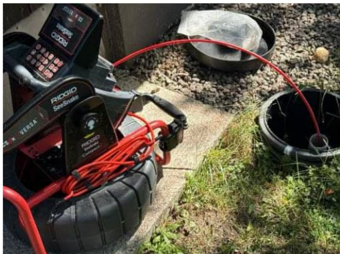
Salaojat kuvattiin putkistokameralla. Salaojituksessa ei havaittu puutteita.
