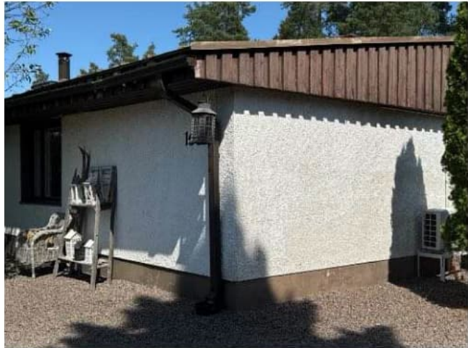
Ulkoseinissä ei havaittu korjausta vaativia puutteita tai vaurioita.
