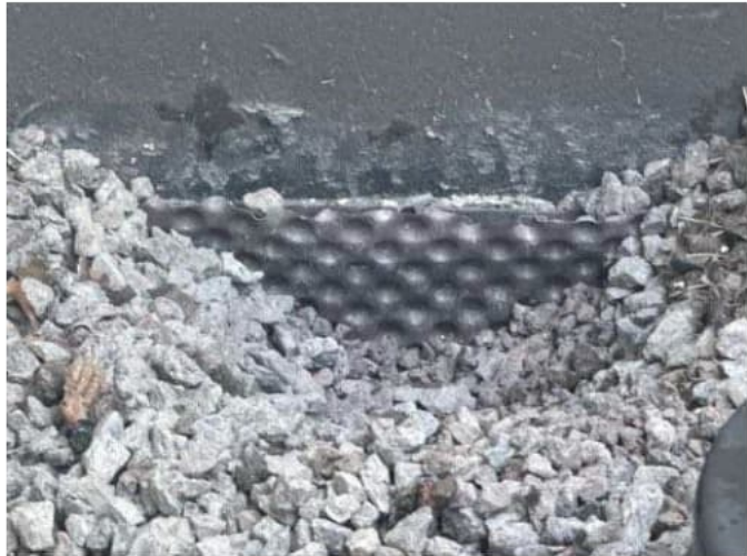
Perusmuurin vedeneristyksen puutteista ei havaittu viitteitä. Eristys sijaitsee maanpinnan alapuolella ja eristyksen toimivuutta arvioidaan pääosin muiden rakenteiden kautta.
