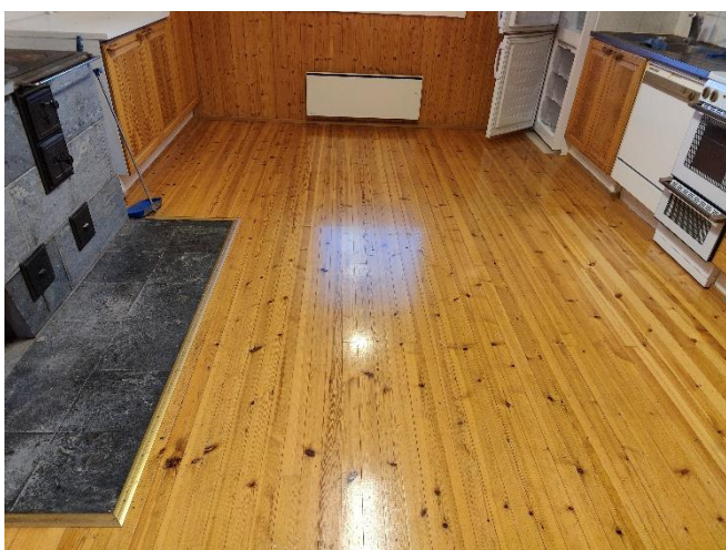
Kuva 16. Yleiskuva alapohjasta, pintamateriaalin päältä.
