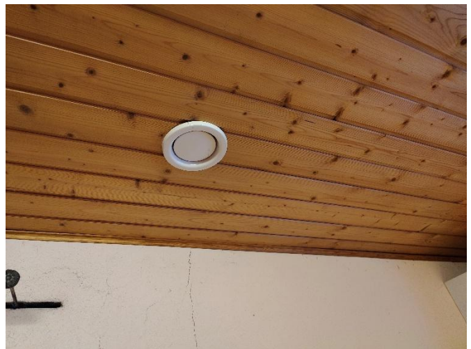
Kuva 64. Yleiskuva poistoilmaventtiili.
