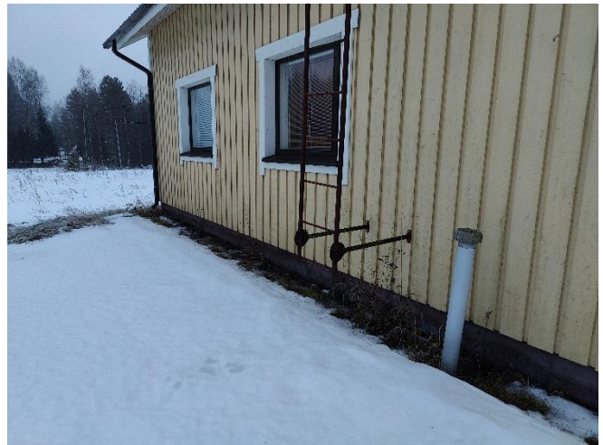
Kuva 2. Yleiskuva rakennuksen vierustalta.
