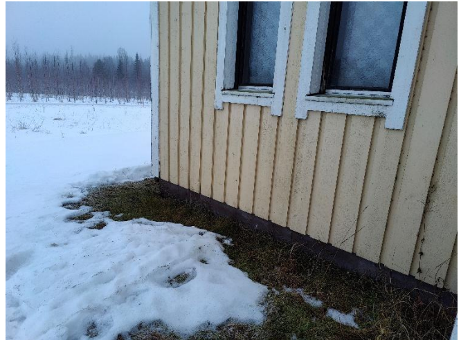
Kuva 4. Yleiskuva rakennuksen vierustalta.
