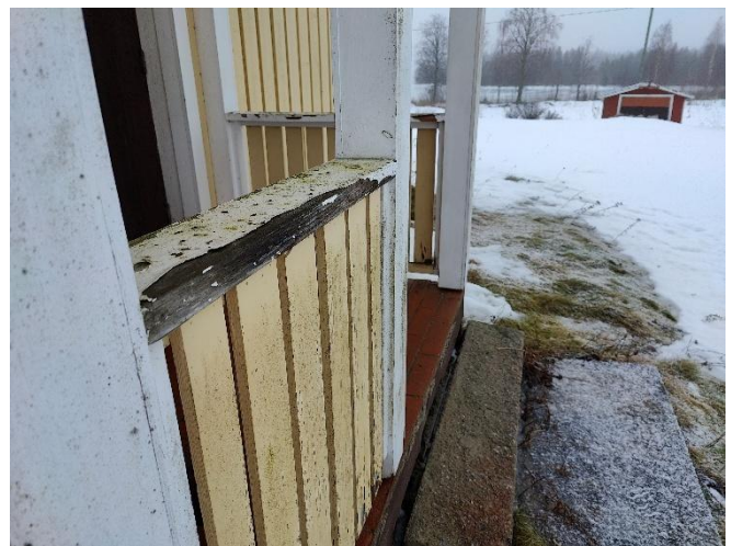
Kuva 30. Yleiskuva päädyn katoksesta.
