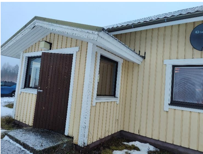
Kuva 24. Yleiskuva päädyn julkisivusta.
