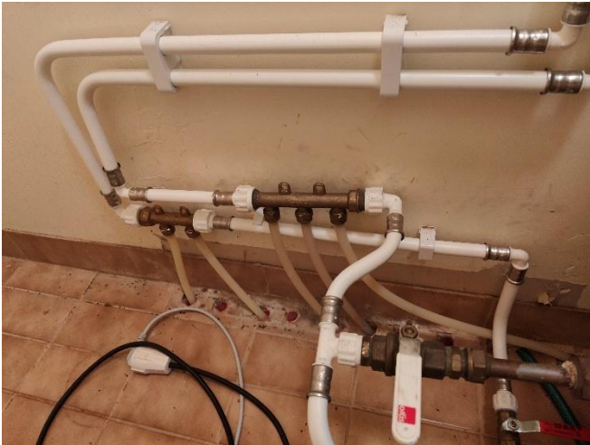
Kuva 57. Käyttöveden jakotukit.
