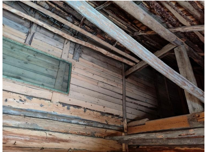
Kuva 11. Yleiskuva aittarakennuksen sisätilasta.
