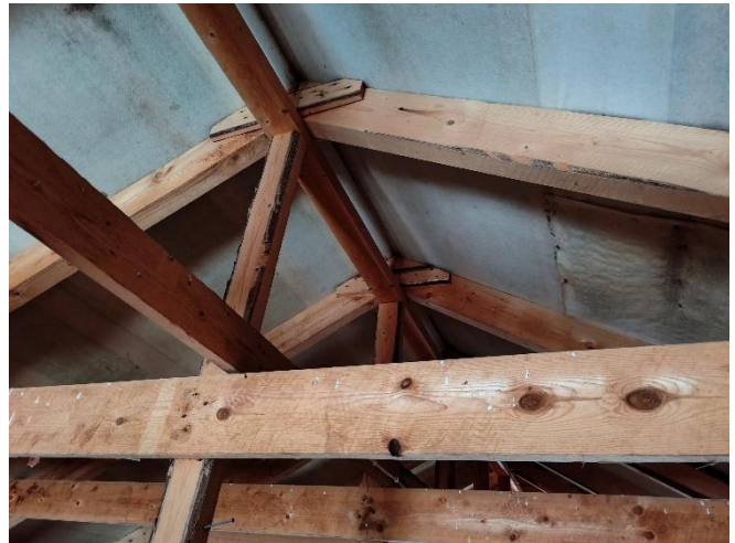
Kuva 34. Yleiskuva harjalta, ullakon puolta kuvattuna.
