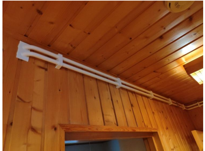
Kuva 58. Käyttövesiverkostoa pintaputkituksena.
