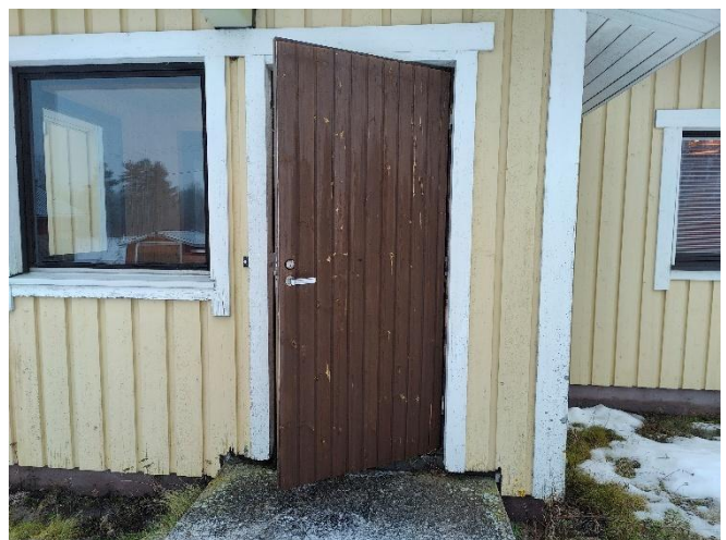
Kuva 28. Yleiskuva kylmän eteistilan ulko-ovesta.
