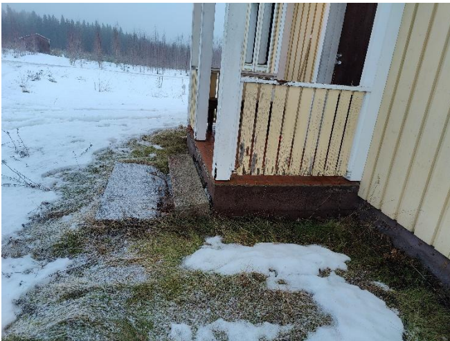
Kuva 1. Yleiskuva rakennuksen sisäänkäynnin edustalta.
