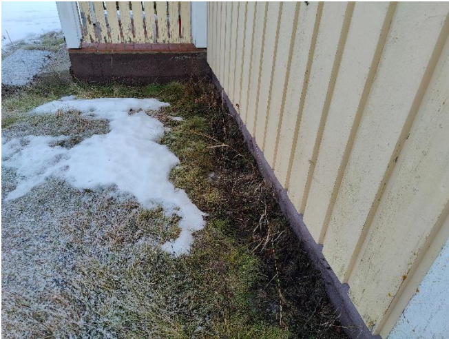
Kuva 3. Yleiskuva rakennuksen vierustäytöstä.
