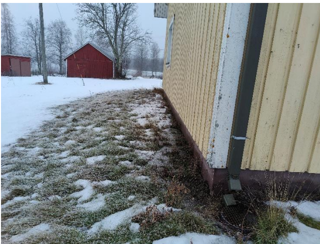
Kuva 5. Yleiskuva, rakennuksen pääty.
