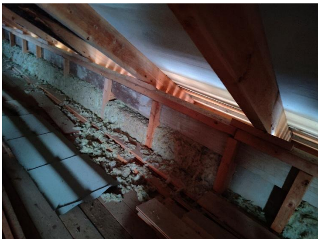
Kuva 20. Ulkoseinän kantavan rungon yläosa.
