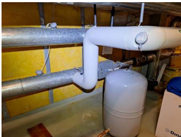
82. Alkuperäisen osan kaukolämpölinja on uusittu.
