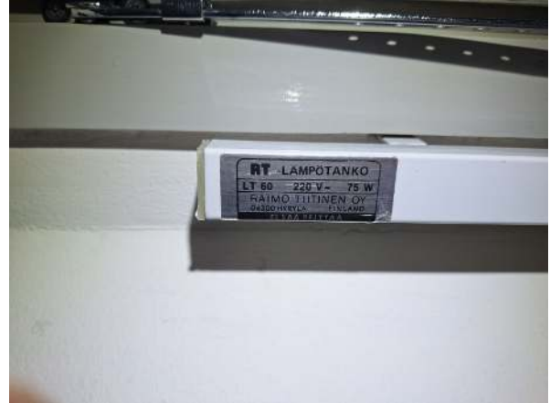
95. Alkuperäisellä osalla on lämmitystangot.
