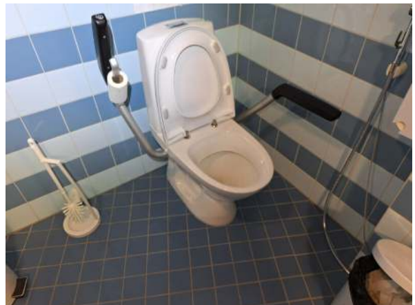
119. Vesi- ja viemärikalusteet alkuperäisiä kummallakin rakennusosalla.
