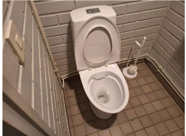
117. Vesi- ja viemärikalusteet alkuperäisiä kummallakin rakennusosalla.
