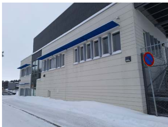
32. Kuvaa laajennusosan julkisivusta.
