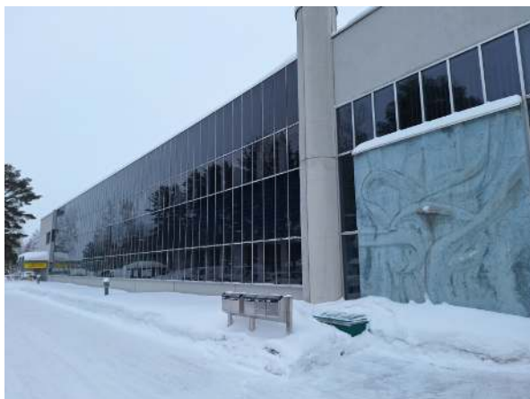
25. Yleiskuvaa julkisivusta lounaaseen, jossa suuri osa julkisivusta lasia.
