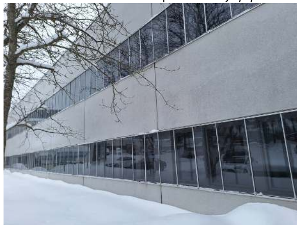
30. Kuvaa julkisivusta koilliseen.
