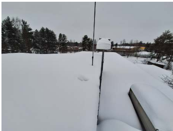
45. Vesikattoa ei voitu tarkastaa lumipeitteen vuoksi.
