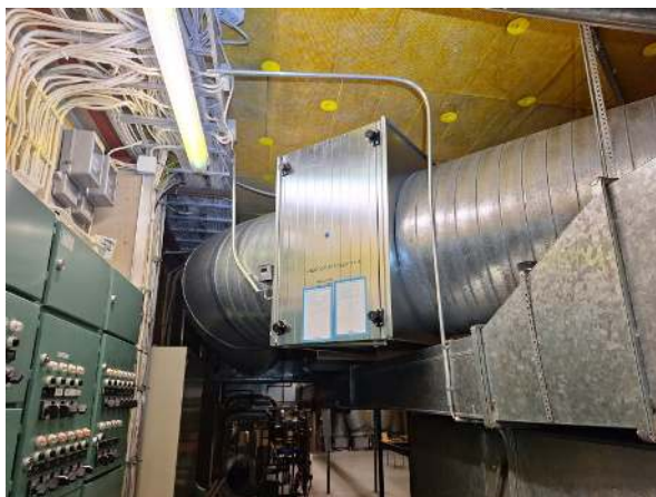
132. Ilmanvaihtokoneessa TK1 käytetään kiertoilmaa.
