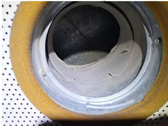
141. Ilmanvaihtokanavistossa ei havaittu pölykertymää.
