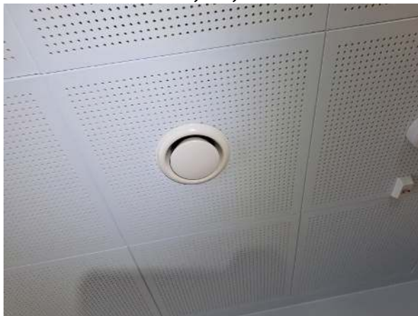
146. Poistoilman kartioventtiili.
