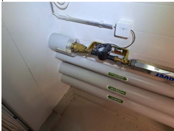
106. Laajennusosan päävesimittari.
