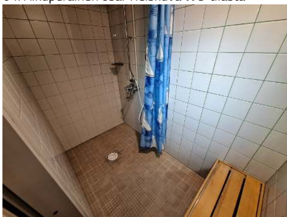
66. Alkuperäinen osa: Yleiskuva pesuhuoneesta.
