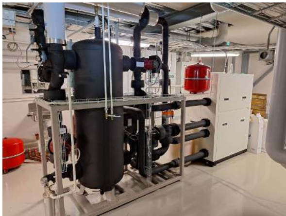
156. Laajennusosan vedenjäähdytyslaitteisto.
