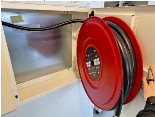
162. Kiinteistössä on alkusammutuskalusteina pikapaloposteja.
