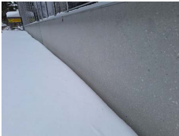
14. Julkisivuelementit jatkuvat maanpinnan tasolle/hieman sen alle.
