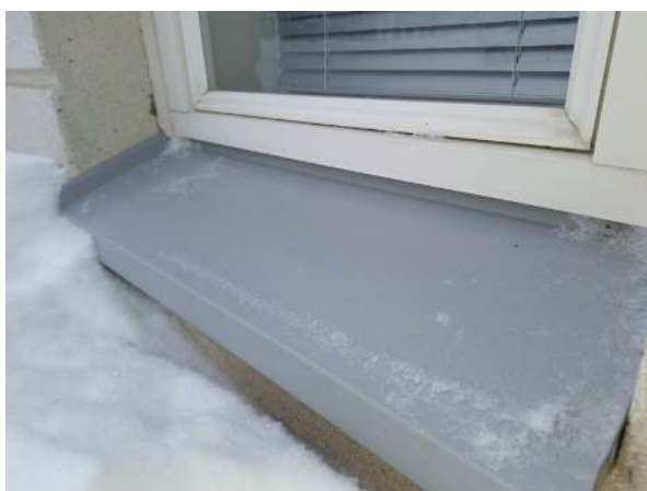
37. Laajennusosan vesipelti.
