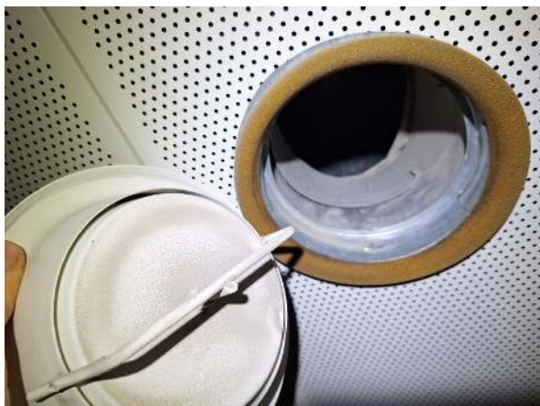
142. Poistoilman kartioventtiili.
