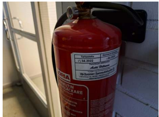
161. Kiinteistössä on alkusammutuskalusteina käsisammuttimia.
