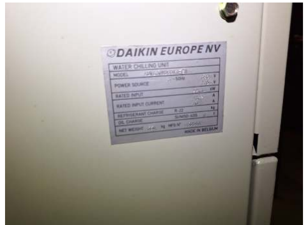
155. Alkuperäisen osan jäähdytyslaitteiston tyyppikilpi.
