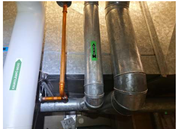
109. Alkuperäisellä rakennusosalla vesijohtoja on paikoin uusittu.
