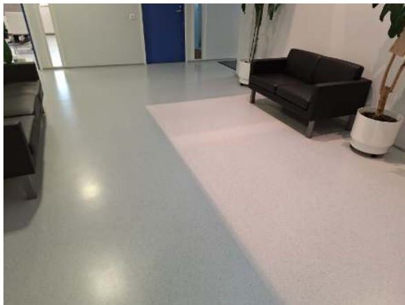
24. Laajennusosan alapohjarakenteessa ei havaittu viitteitä halkeilusta lattiapinnotteiden päällä
