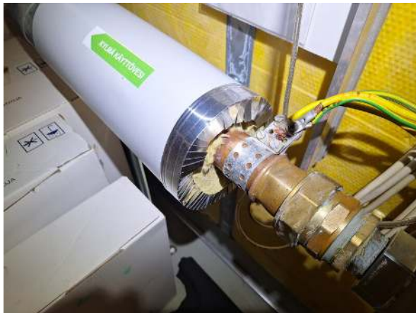
108. Alkuperäisellä rakennusosalla vesijohdot ovat kuparia.
