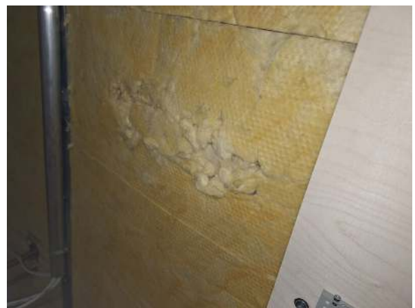
50. Alkuperäinen osa: Katossa sekä seinäpinnoilla avoimia villapintoja.
