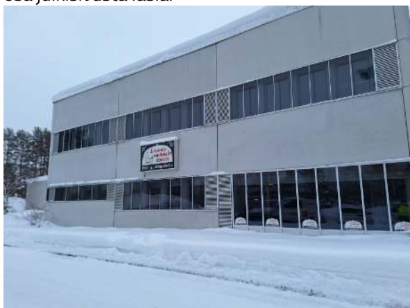
27. Alkuperäisen osan julkisivua luoteeseen.
