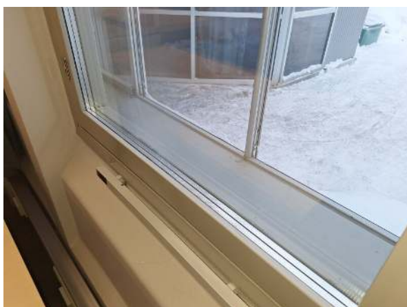
33. Alkuperäisen osan ikkunat ovat puurakenteiset, joissa eristyslaselementit.
