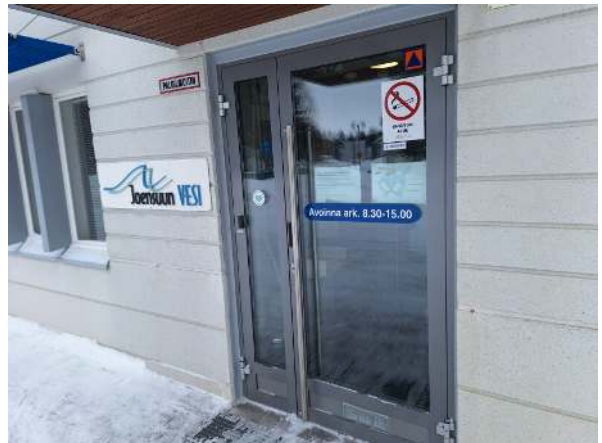
44. Laajennusosan ulko-ovet ovat hyvässä kunnossa.
