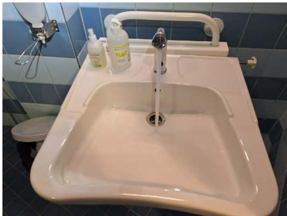
118. Vesi- ja viemärikalusteet alkuperäisiä kummallakin rakennusosalla.
