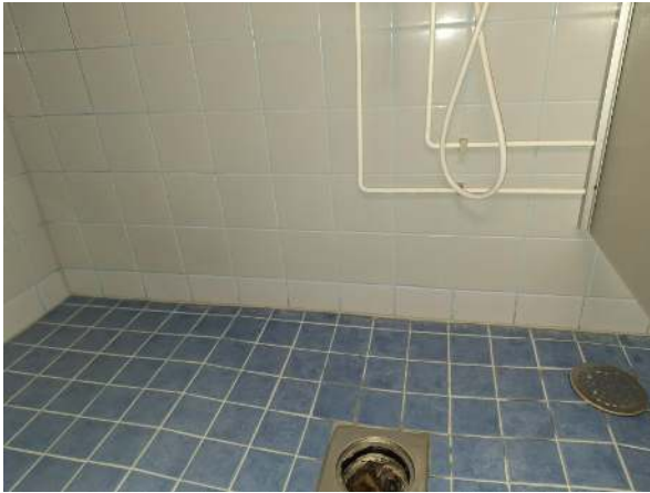
70. Havaintojen mukaan pesuhuoneen lattia sekä seinän alin laattarivi on uusittu.
