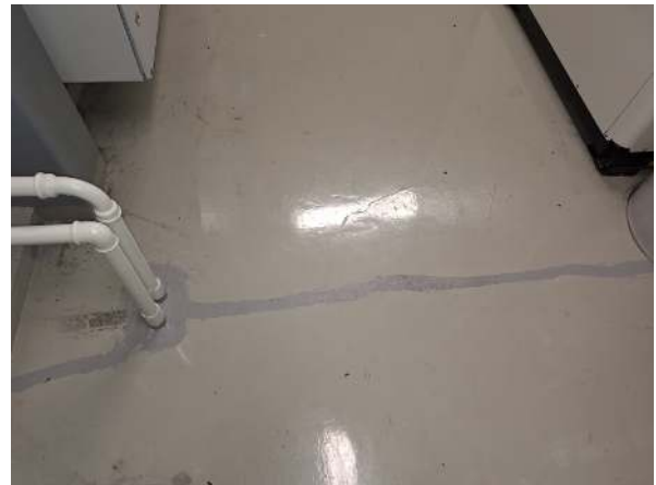
54. Laajennusosa: Pinnoitevaurioihin on tehty paikkakorjauksia.
