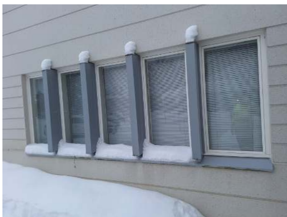
35. Laajennusosan ikkunat ulkopuolelta.
