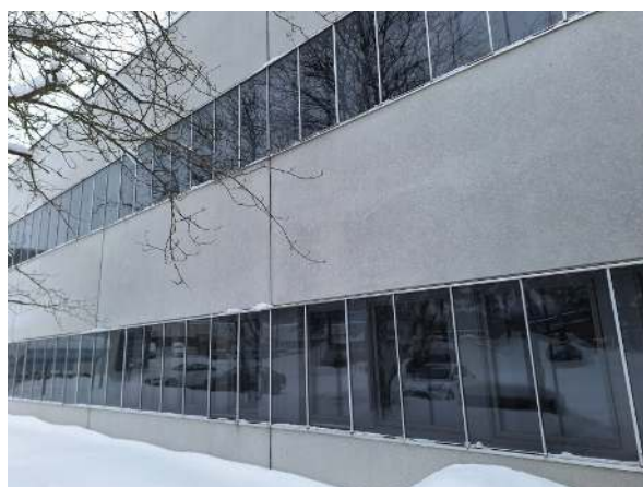
34. Ulkopinnassa ikkunanauvoissa julkisivulasitus.
