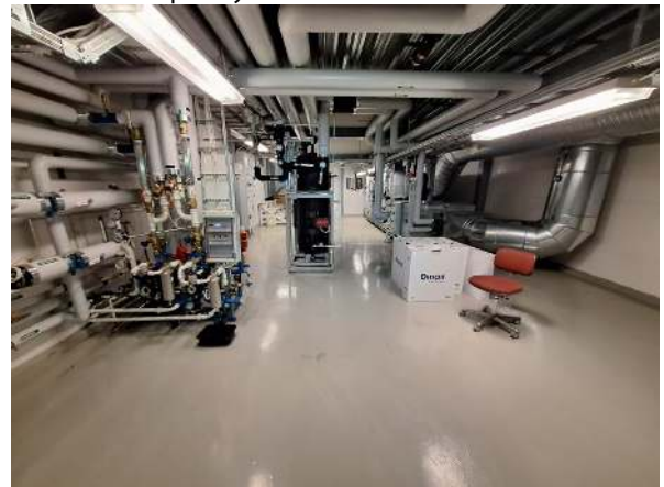
52. Yleiskuva laajennusosan teknisestä tilasta.
