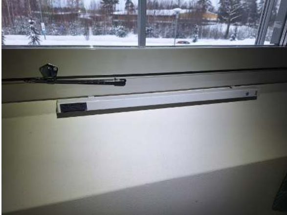
94. Alkuperäisellä osalla on lämmitystangot.
