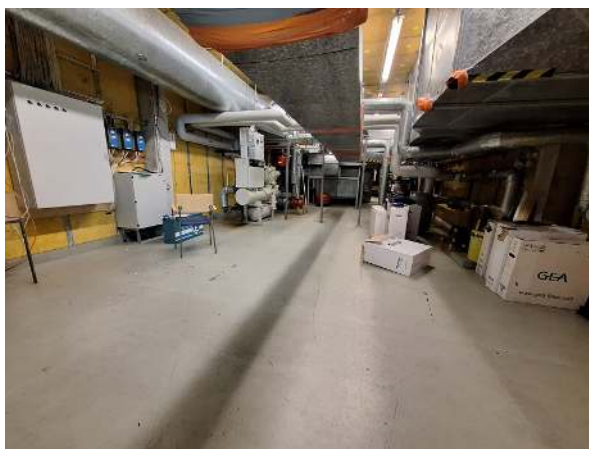
49. Yleiskuva alkuperäisen osan teknisestä tilasta.
