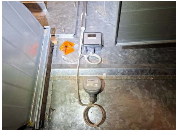
135. Paine-ero- ja lämpötilamittareita.
