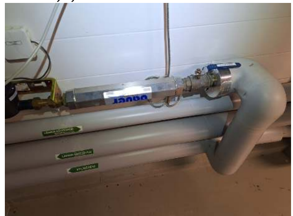
107. Laajennusosalla oleva veden suodatusjärjestelmä.
