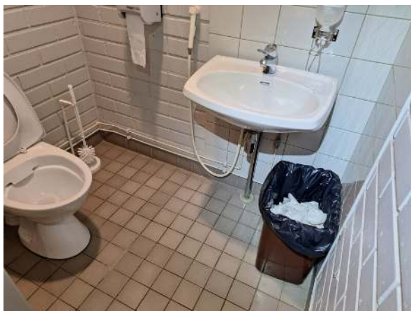
64. Alkuperäinen osa: Yleiskuva WC-tilasta
