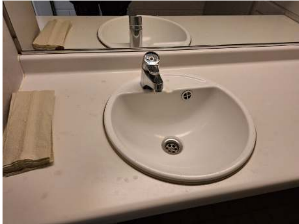
116. Vesi- ja viemärikalusteet alkuperäisiä kummallakin rakennusosalla.
