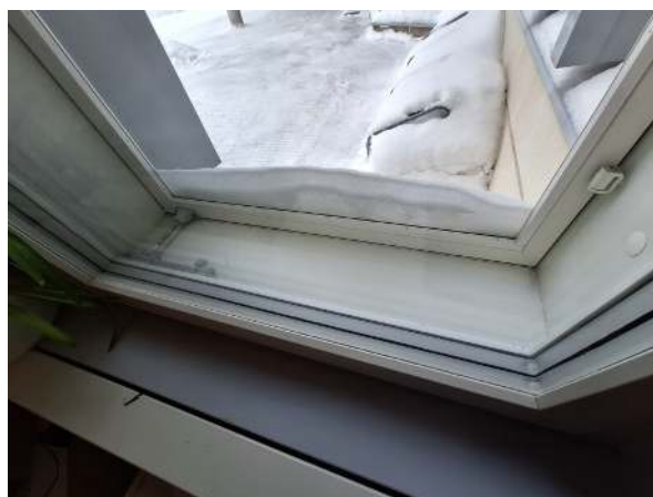
36. Laajennusosan ikkunat ovat MSE-AL-tyypin ikkunoita.
