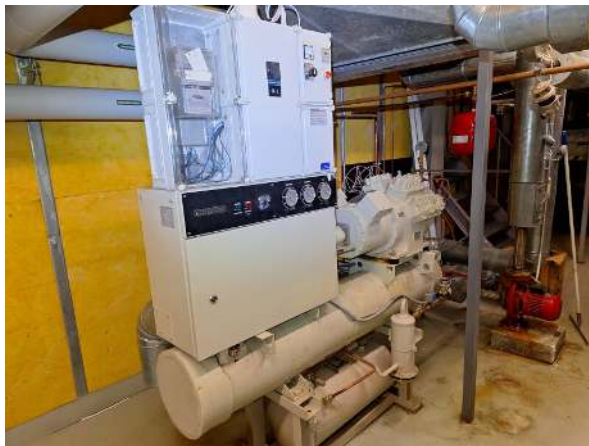
154. Alkuperäisen osan vedenjäähdytyslaitteisto.
