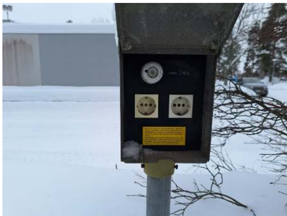
167. Vanhemmissa autolämmituspistorasioissa on suora syöttö.
