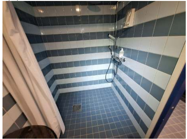
73. Yleiskuva laajennusosan pesuhuoneesta.
