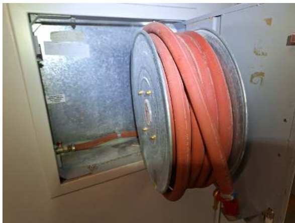
160. Kiinteistössä on alkusammutuskalusteina pikapaloposteja.
