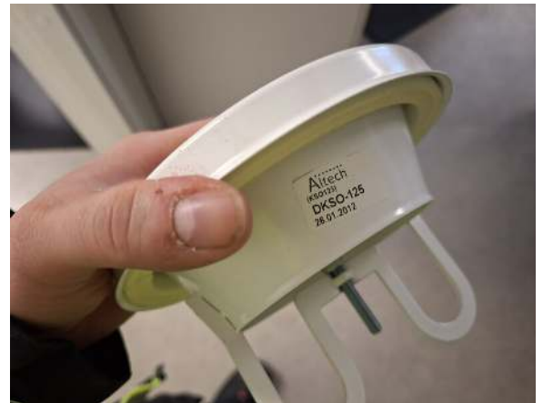
38. Poistoilman kartioventtiili.
