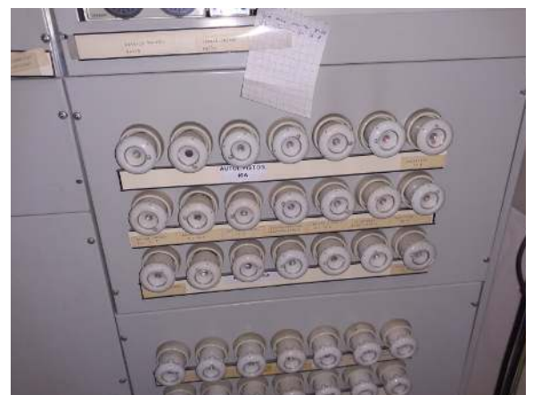
56. Sähköpääkeskus. Varokelähtöjä
