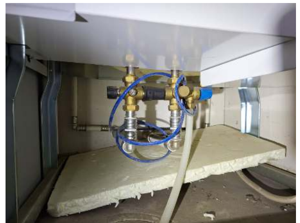
25. Vesijohdot ovat paikoin komposiittia.
