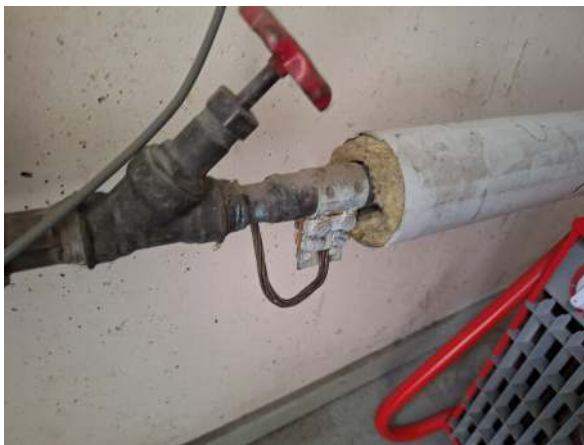
24. Vesijohdot ovat pääosin kuparia.
