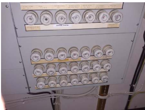
55. Sähköpääkeskus. Varokelähtöjä
