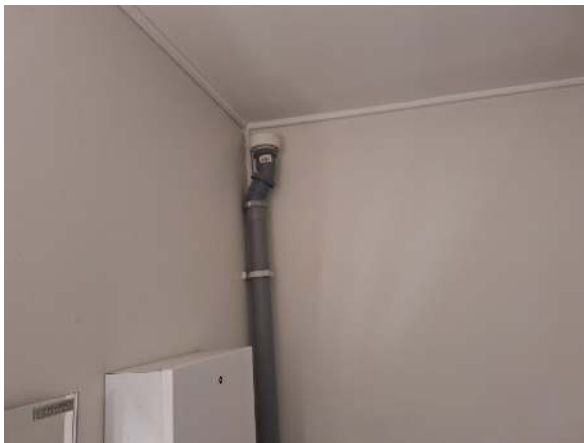
28. Tilassa oleva alipaineventtiili.
