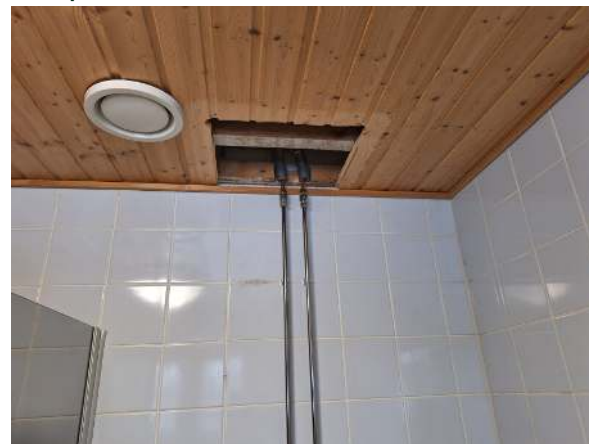
27. Vesijohdot ovat paikoin kromikuparia.
