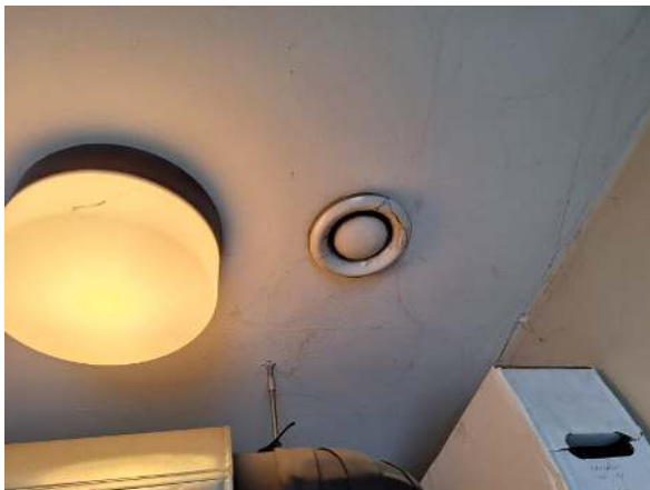
39. Poistoilman kartioventtiili.
