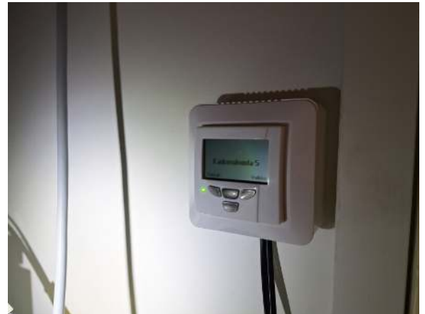
36. IV-koneen säätölaite.
