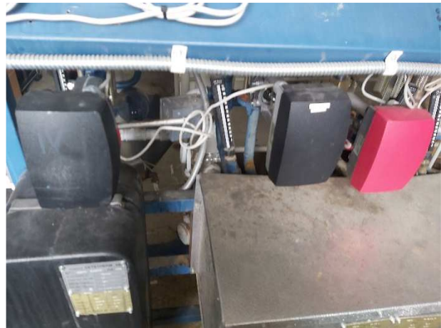
Kuva 97. Lämmitysverkostojen moottoriventtiilit.
