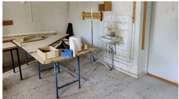
Kuva 71. Yleiskuva pohjakerroksen toimintatilasta.
