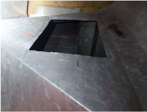
Kuva 154. Poistoilmakammion tarkastusluukku.
