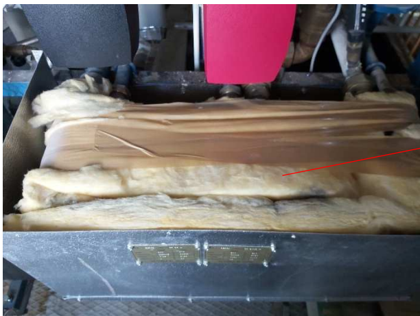
Kuva 82. Patteriverkoston ja lämpimän käyttöveden siirtimet ovat ~80 -luvulta.
