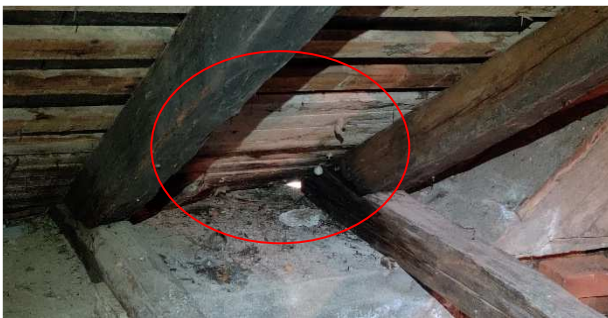
Kuva 56. Vesikatossa on muutamia paikallisia vuoto-kohtia.
