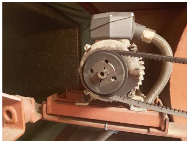
Kuva 139. Moottorin voimansiirto on hihnalla. Hihna oli tarkastushetkellä löysällä.
