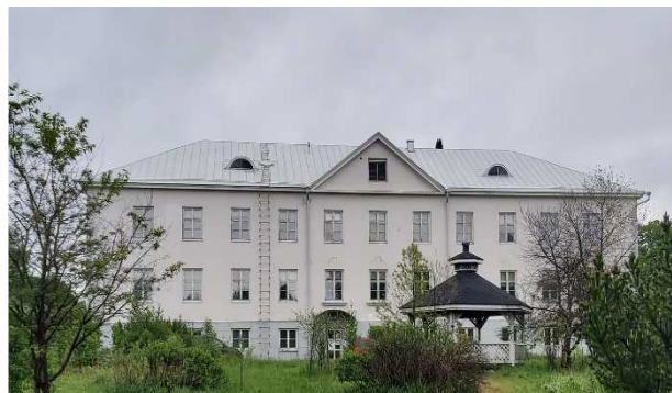
Kuva 49. Yleiskuva rakennuksen takaosan vesikattosta.
