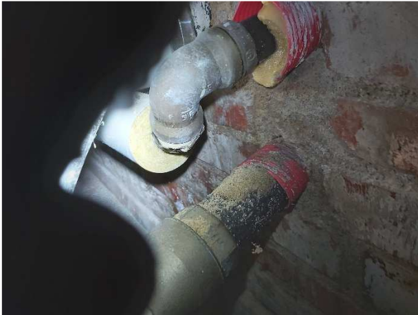
Kuva 106. Tonttijohto on muovinen PEH63.
