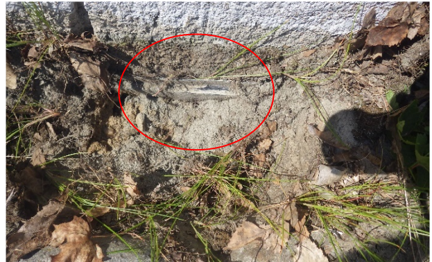
Kuva 14. Rakennuksen etupihalla on lisätty patolevy.
