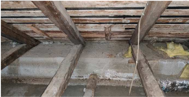
Kuva 54. Puset kattokannattajat ovat alkuperäisiä ja tuettu ulkoseinälinjojen päälle.
