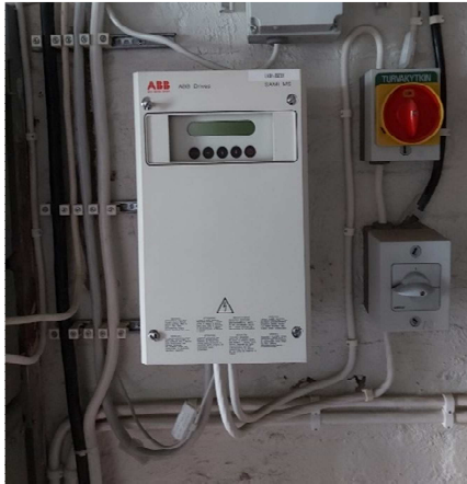
Kuva 168. Lämmönjakuhuoneen taajuusmuuttaja.
