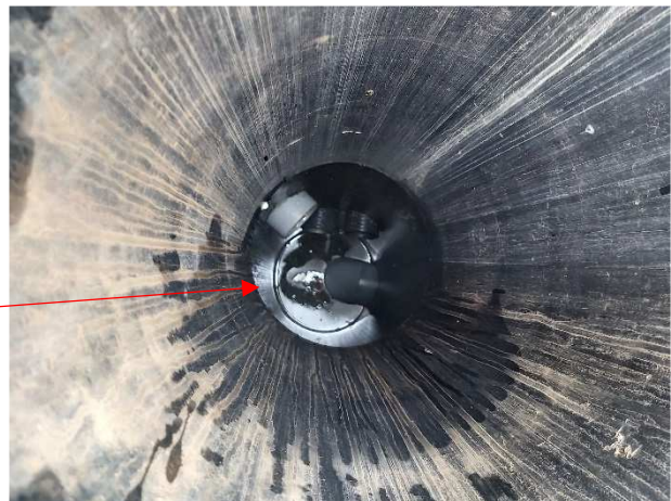
Kuva 12. Kaivossa kolme salaojaputkea ja kaksi sadevesiputkea sekä yksi poislähtö.
