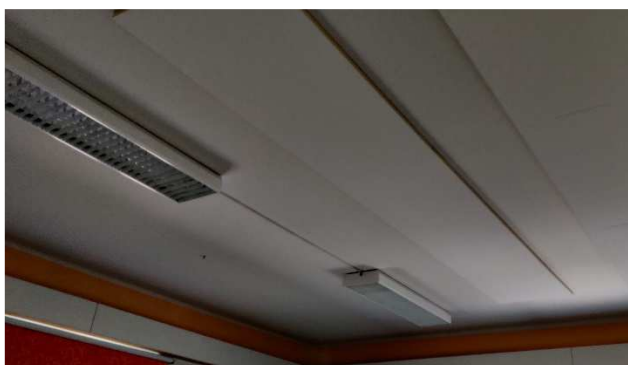
Kuva 64. Tiloissa ei pääsääntöisesti ole alakattotilaa.
