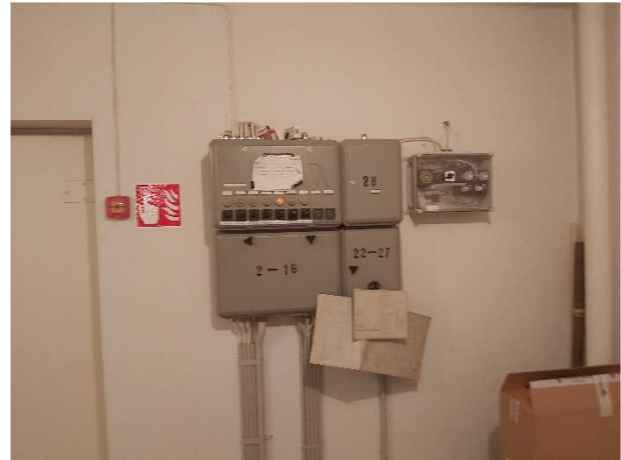
Kuva 169. Ilmanvaihtokoneiden ohjauskeskus.
