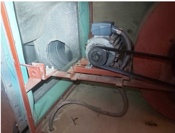
Kuva 156. Puhallinkammio. Kuvassa moottori ja sen voimansiirtohihnat.
