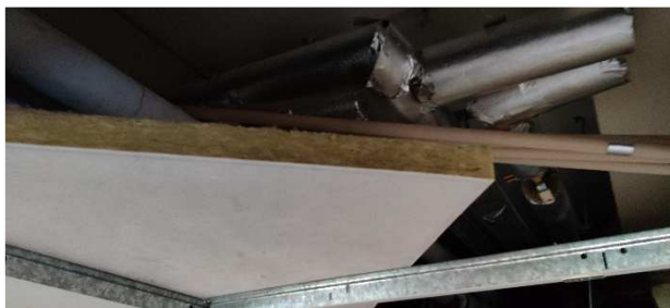
Kuva 62. Akustiikkalevyn reunat auki.
