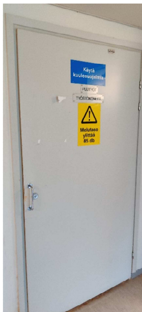
Kuva 40. Osastoivia metallirakenteisia palo-ovia.
