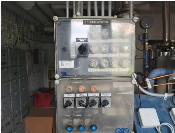
Kuva 96. Lämmitysverkostojen säätökeskus.
