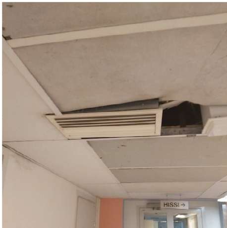
Kuva 164. Käytävän tuloilmasäleikkö.
