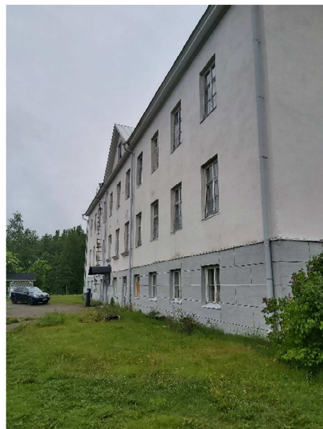
Kuva 4. Yleiskuva rakennuksen takapihasta.
