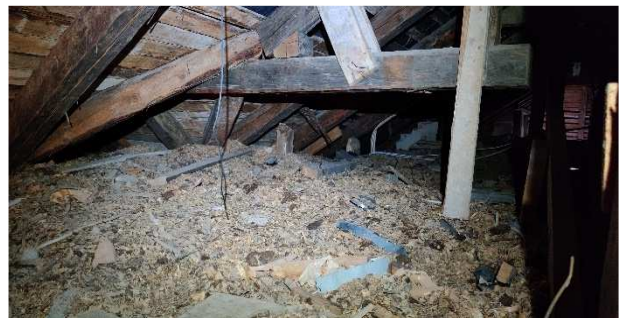
Kuva 57. Teknisen tilan yläpuolella eristeenä on sahanpurua ja kutterinlastua.
