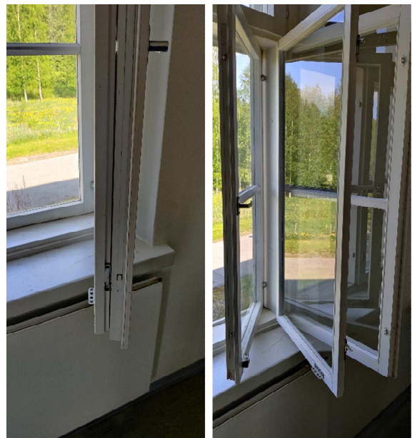
Kuva 33. Ikkunat ovat kolmilasisia puuikkunoita.
