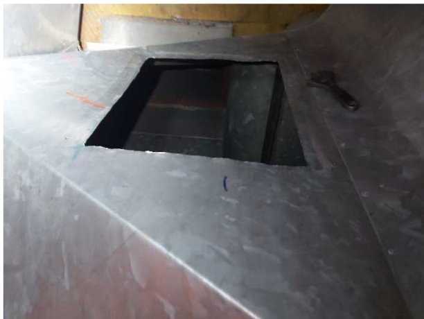
Kuva 136. Poistoilmakammion tarkastusluukku.
