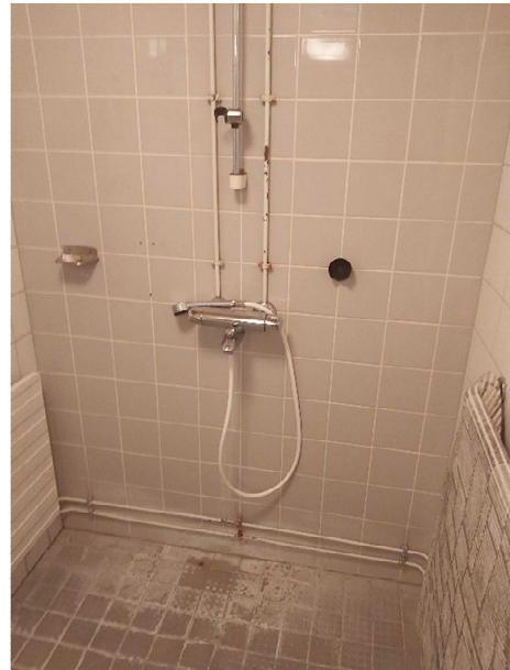
Kuva 119. Yleiskuva suihkusekoittajasta. KytKentäjohto on tuotu yläkautta.
