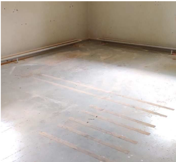
Kuva 24. Osa alapohjan pintamateriaalista on maalattua betonia. Siinä ei todettu pintakosteuspoikkeamaa.
