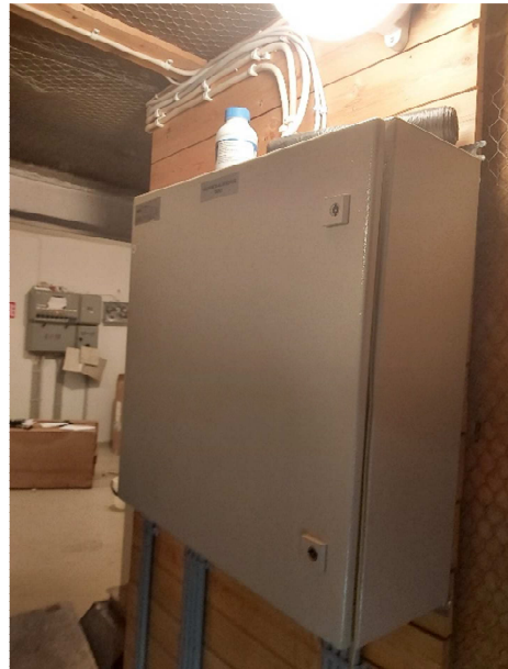
Kuva 167. Ilmanvaihtokonehuoneen VAK-keskus.
