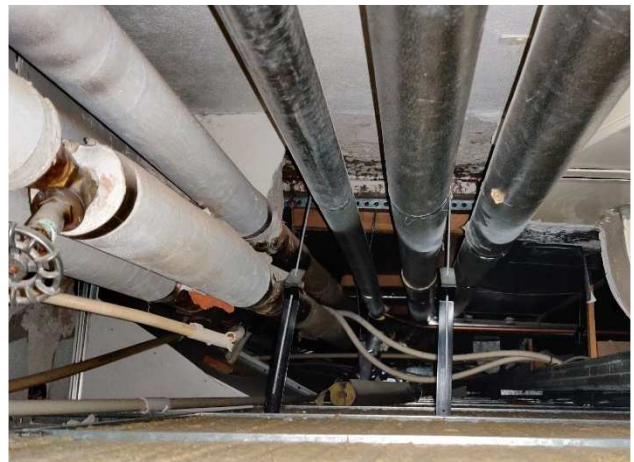
Kuva 109. Käyttövesiputkia alakattotilassa.
