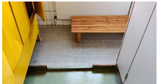
Kuva 75. Yleiskuva kerroksesta olevasta pesuhuoneesta.
