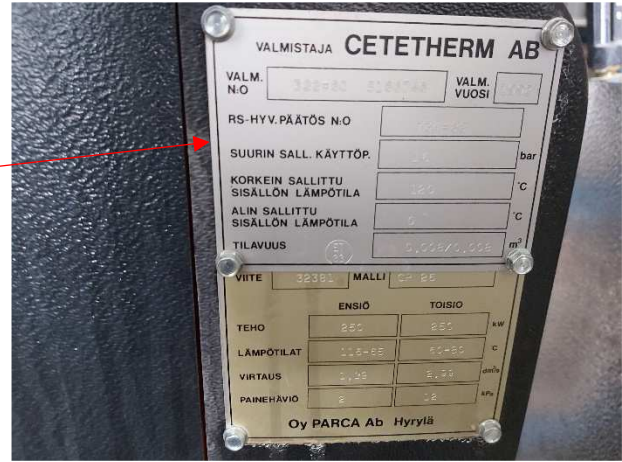
Kuva 85. Siirtimen mitoitustiedot.
