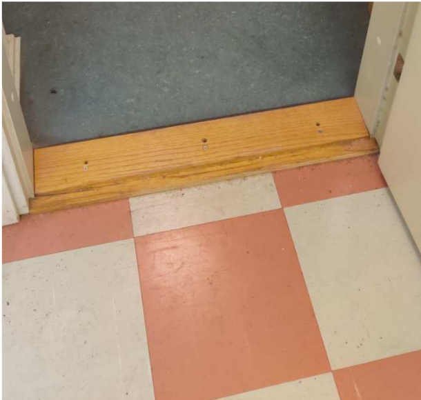
Kuva 26. Pohjakerroksen käytävällä on 300x300 vinyyli-laattoja.
