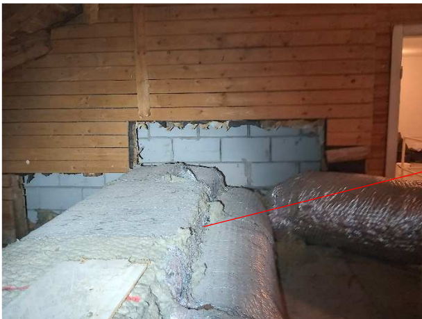
Kuva 160. Alkuperäinen rakennusaineinen kanava yläpohjatilassa.
