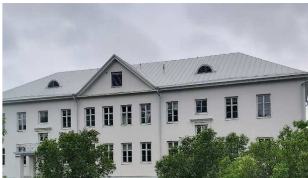
Kuva 48. Yleiskuva rakennuksen etuosan vesikattosta.
