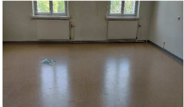
Kuva 69. Kerrosten lattiapinnat ovat pääsääntöisesti muovimattoja.
