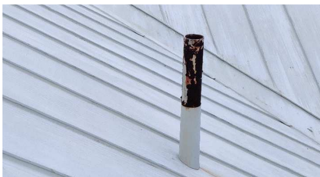
Kuva 110. Viemärin tuuletusputki on tuotu vesikattolle.
