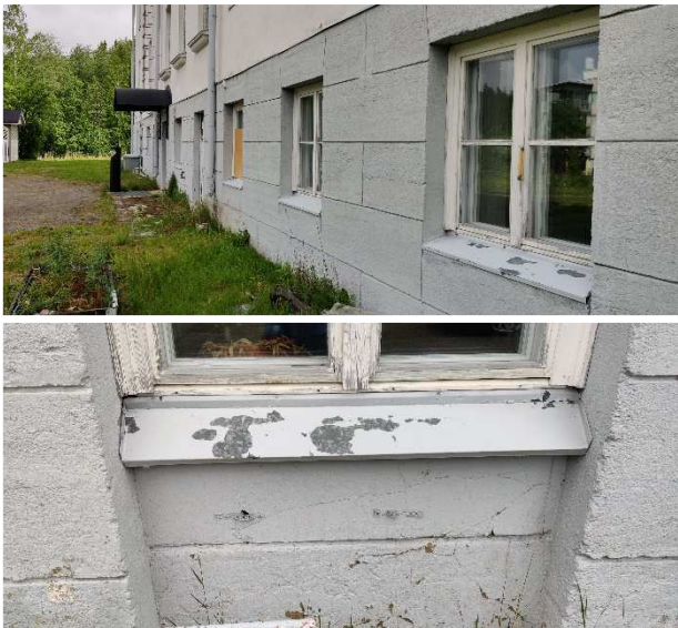
Kuva 32. Yleiskuva ikkunoista ja vesipenkkipelleistä.
