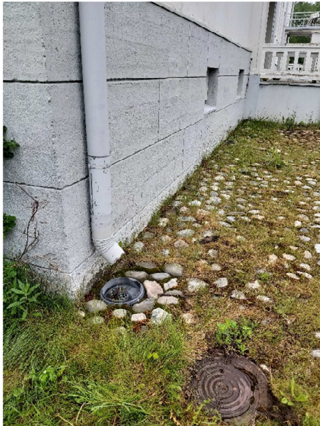
Kuva 9. Etupihan nurkalla oleva syöksytorvi ja sadevesikaivo.
