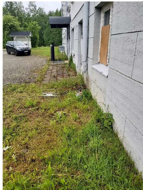
Kuva 8. Takapihan maanpinta on tasainen tai kaataa lievästi rakennukseen päin.
