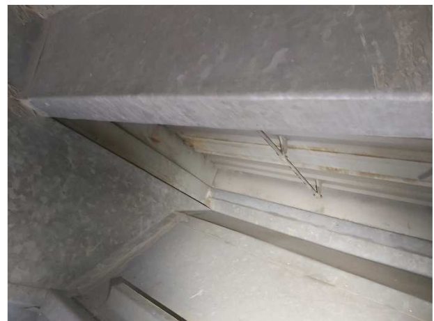
Kuva 145. Pelti sulkeutui koneen sulkemisen jälkeen.
