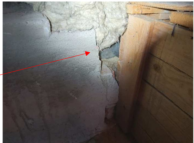
Kuva 161. Rakennusaineisen kanavan sisällä on peltikanavat.
