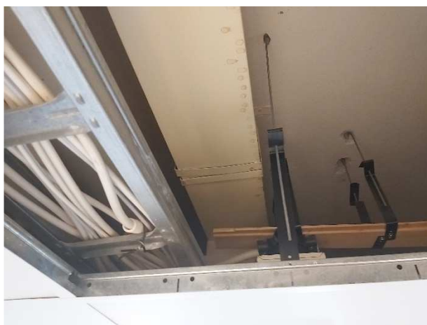
Kuva 61. Yleiskuva käytävän alakattotilasta.
