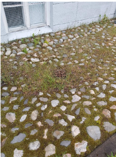
Kuva 16. Rakennuksen etuosalla perusmuurin vierustalla on luonnonkiveä.
