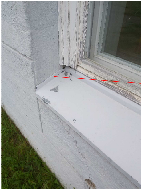
Kuva 34. Vesipenkkipeltien kallistukset ovat pääsääntöisesti asianmukaiset.
