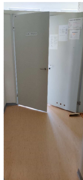
Kuva 41. Väliovet ovat pääsääntöisesti puurakenteisia.
