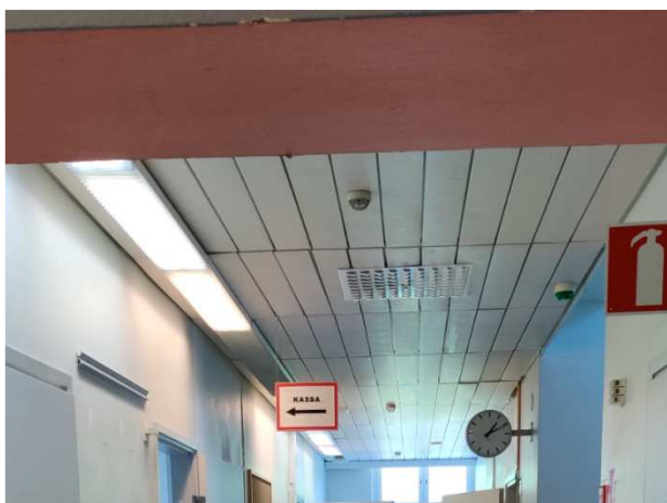
Kuva 60. Yleiskuva käytävän alakatosta.
