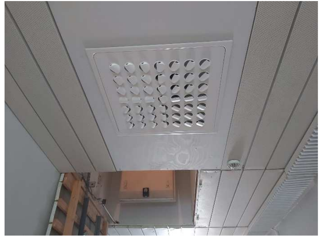
Kuva 163. Uusittu kattohajottaja kerroksen käytävällä.
