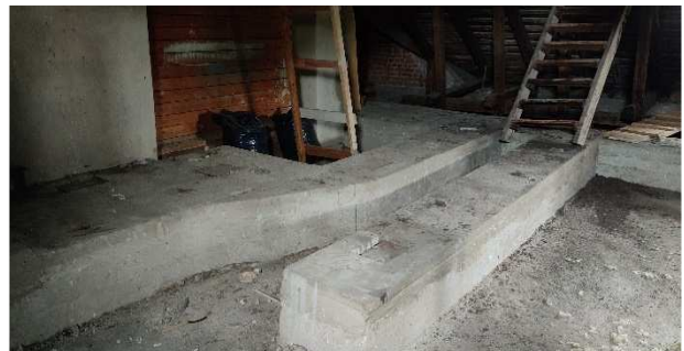
Kuva 59. Yläpohjassa kulkevat ilmanvaihtokanavat ovat kivirakenteisia, rakennusaineisten kanavien sisällä on peltikanavaa.
