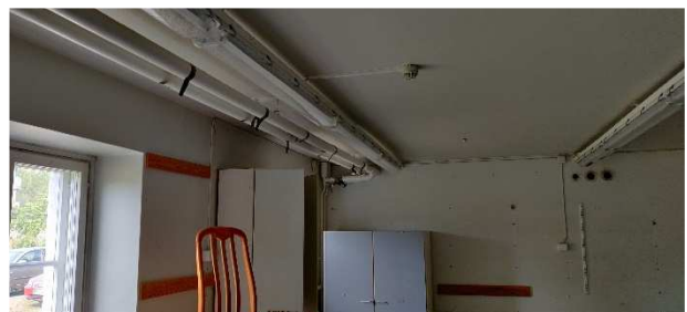
Kuva 67. Yleiskuvia väliseinistä. Pinnat on tasoitettu ja maalattu.
