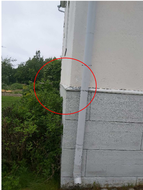
Kuva 18. Perusmuurin ja rapatun julkisivun liittymässä on pellitys.
