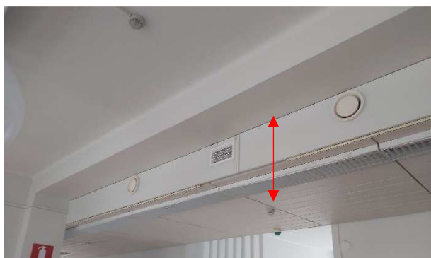
Kuva 65. Käytävän ja tilan välinen korkeusero.
