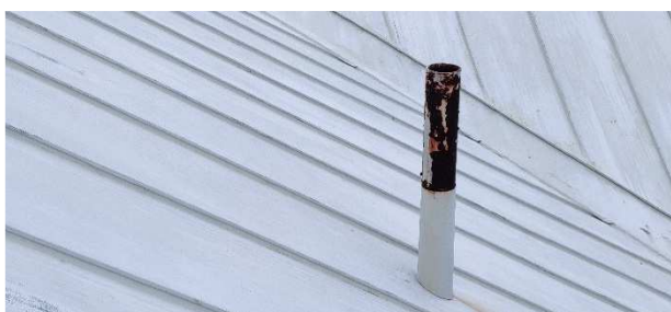
Kuva 50. Viemärin tuuletusputket on tuotu vesikattolle.
