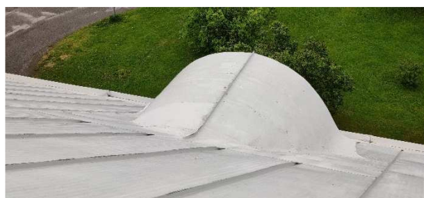
Kuva 51. Ullokkeiden liittymät on tehty asianmukaisesti vesikatolta tarkasteluna.
