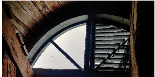
Kuva 55. Yläpohja tuulettuu vesikatolla olevien ulokkeiden kautta.
