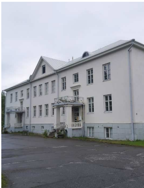
Kuva 3. Yleiskuva rakennuksen etupihasta.
