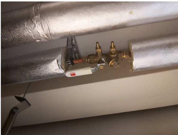
Kuva 108. Käyttöveden linjasäätöventtiili.
