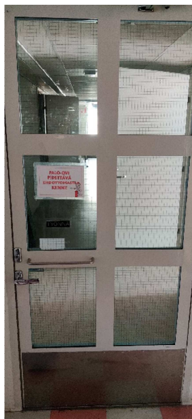
Kuva 40. Osastoivia metallirakenteisia palo-ovia.
