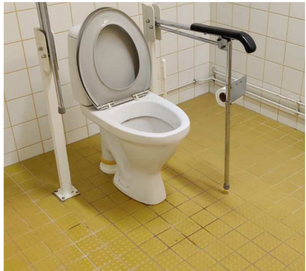
Kuva 25. Pohjakerroksen wc-tilat ovat klinkkerilaat- taa.
