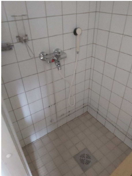
Kuva 118. Yleiskuva suihkusekoittajasta. KytKentäjohto on tuotu alakautta.
