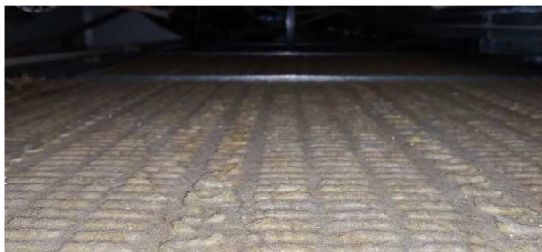
Kuva 63. Akustiikkalevyn pinnat auki yläpuolelta.
