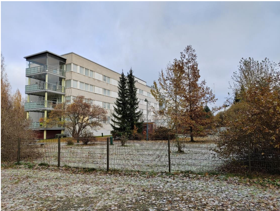
Kuva 4. Uusin purettava sairaalarakennus syksyllä 2023.
