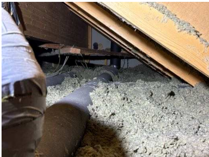
Yläpohjassa ei havaittu korjausta vaativia puutteita
