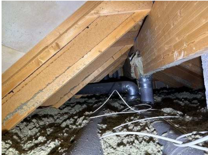
Vesikattorakenteissa ei havaittu korjausta vaativia puutteita tai vaurioita.
