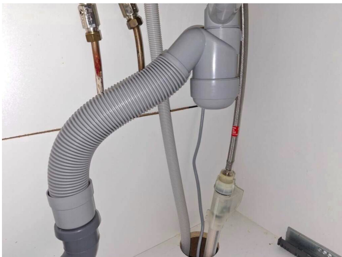
Kuva 10 Allaskaapin rakenteissa ei havaittu vaurioita.
