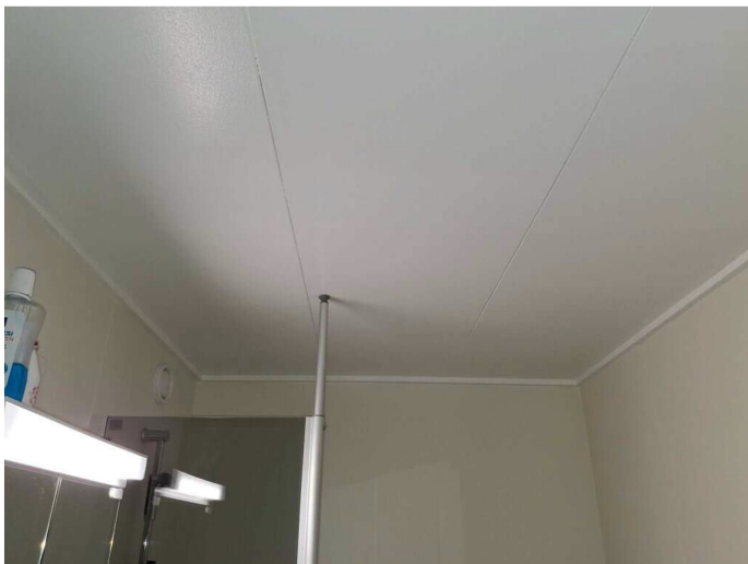
Kuva 16 Peltikasetti seinät ja sisäkatto on maalattu.
