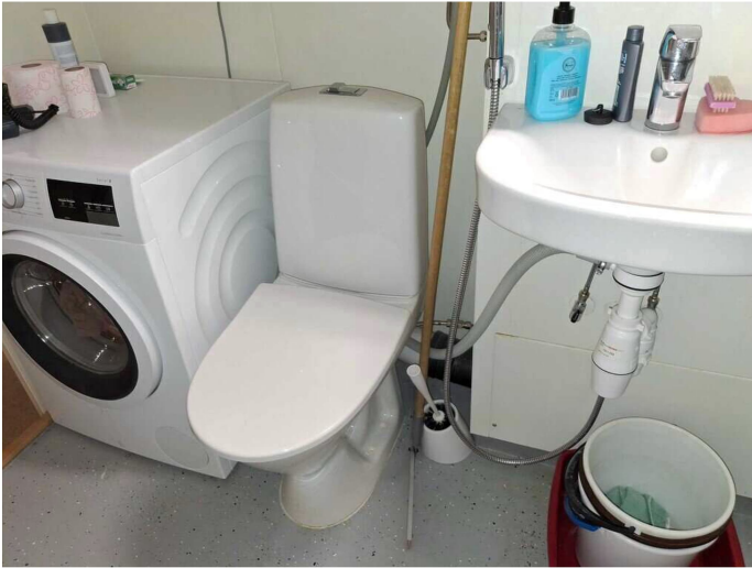
Kuva 18 Vesikalusteet on uusittu kylpyhuoneen saneerauksessa.
