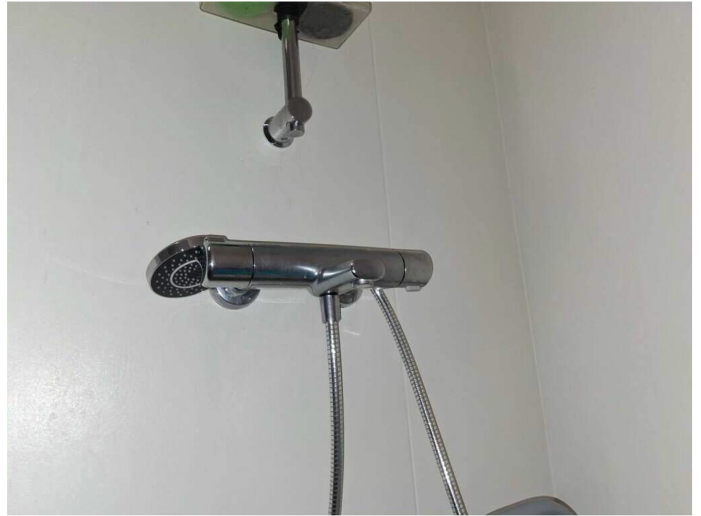
Kuva 23 Suihkusekoittaja on uusittu.
