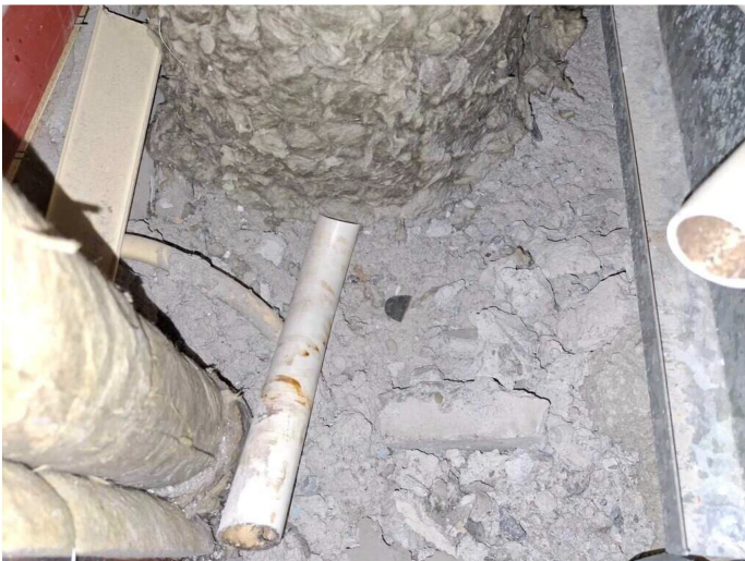
Kuva 20 Hormin rakenteissa ei havaittu vaurioita tai vuotojälkiä.
