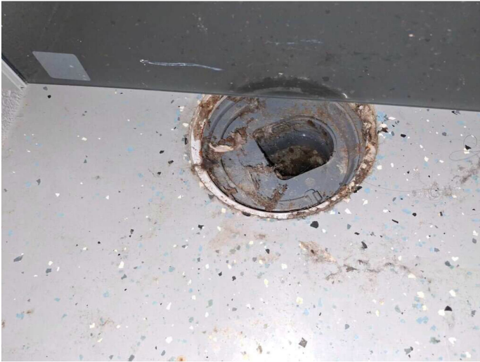
Kuva 22 Lattiakaivossa on vuosiluku 2022.
