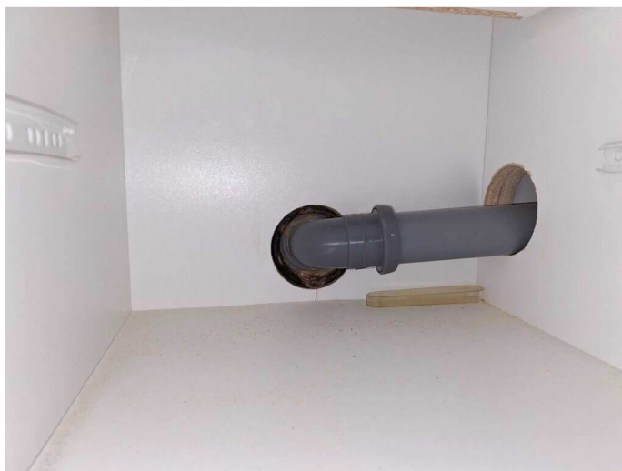
Kuva 9 Keittiön altaan viemäri on uusittu.
