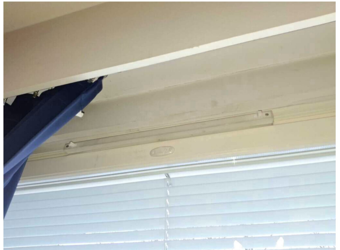
Kuva 25 Uusituissa ikkunoissa on korvausilmasäleiköt.
