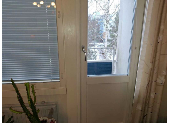
Kuva 3 Parvekkeen ovi on uusittu.
