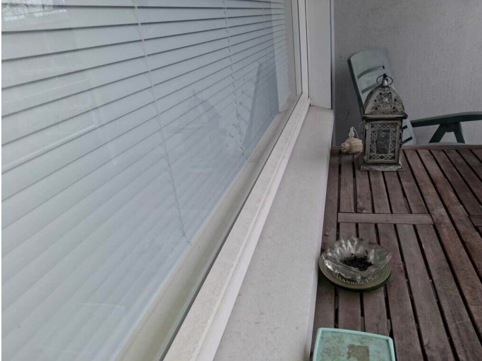
Kuva 2 Rakennuksen ikkunat on uusittu vuonna 2006.
