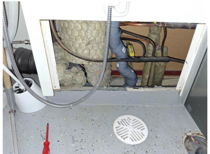
Kuva 21 Alkuperäinen seinäkaivo on poistettu ja korvattu lattiakaivolla.
