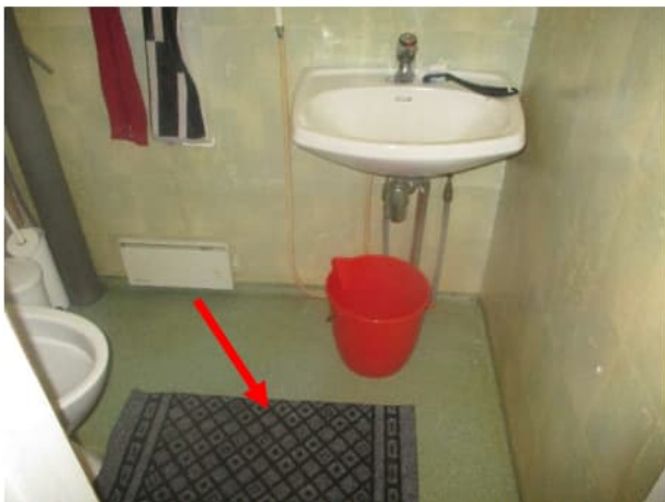
Tilan lattiassa havaittiin kohonneita pintakosteuksia sekä laipiossa vuotojälkiä.
