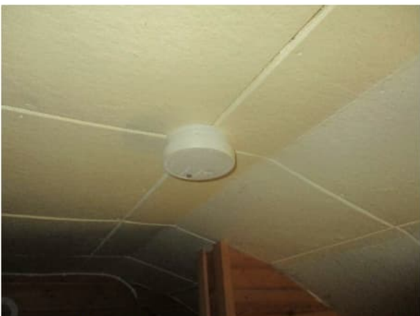
Käytössä olleet palovaroittimet olivat patterikäyttöisiä.
