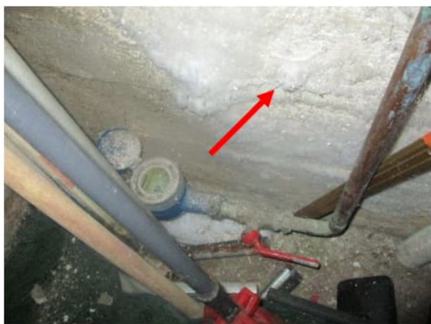
Kellarin varaston alapohjarakenteessa sekä maanpaineiseinissä havaittiin lähes kauttaaltaan kohonneita pintakosteuksia sekä paikoitellen runsaasti kosteuteen viittaavaa kalkkihärmää ja levypinnoilla kasvustoa.
