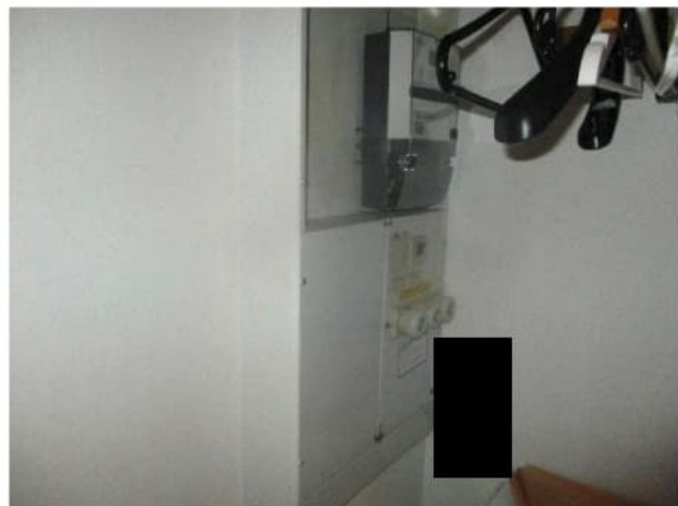
Sähköpääkeskus (pääsulakkeet 3X25 A) ja sähkömittari sijaitsevat eteisessä.
