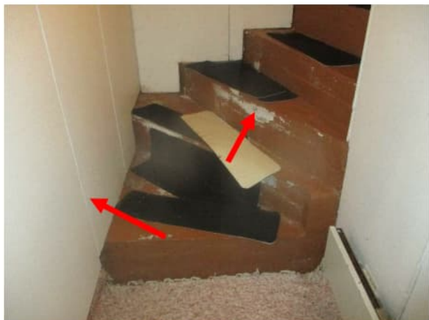
Kellarin käytävän alapohjarakenteessa, portaissa sekä maanpaineiseinissä havaittiin lähes kauttaaltaan kohonneita pintakosteuksia sekä paikoitellen runsaasti kosteuteen viittaavaa kalkkihärmää ja levypinnoilla tummentumaa.
