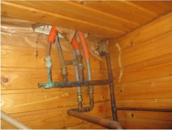
Käyttövesiputket ovat muovia / kuparia ja viemäriputket muovia.
