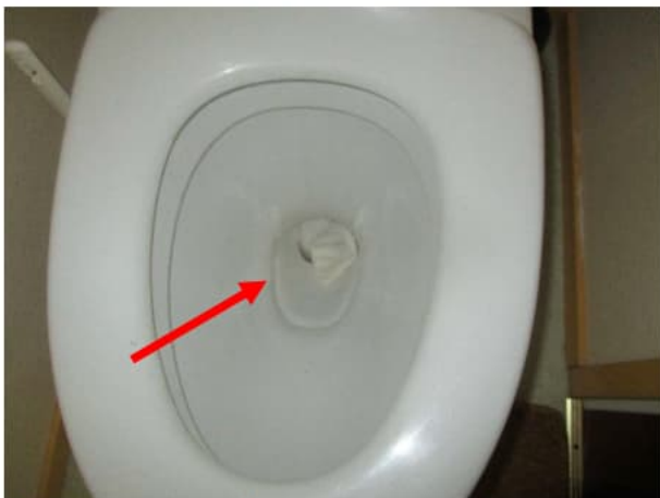
Saatujen tietojen mukaan wc-istuin on rikkoutuessaan vuotanut rakenteisiin.
