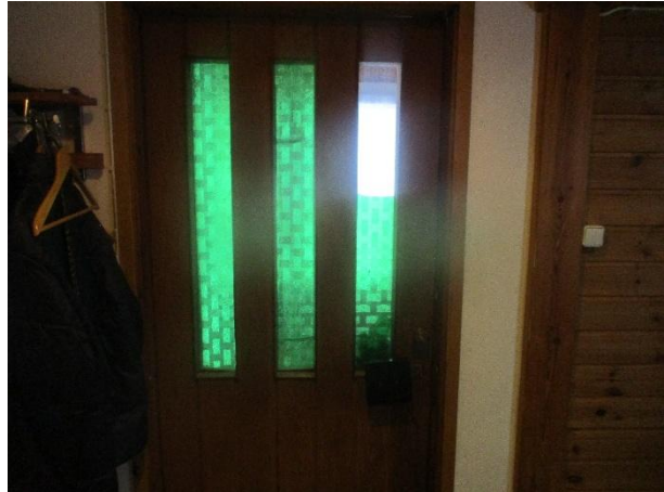
Rakennuksen ulko-ovi on uusittu 1-lehtinen ja lasiaukollinen.
