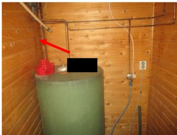
Paneeliseinässä oli havaittavissa vanhoja valumajälkiä käyttövesiputkien alapuolella.
