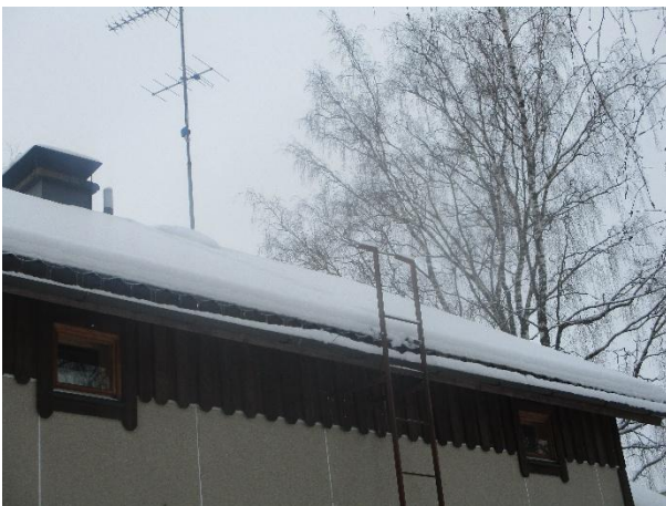
Sääolosuhteista johtuen vesikatteen ja sen läpivientien ja kattoturvalaitteiden tarkastaminen ei ollut mahdollista.
