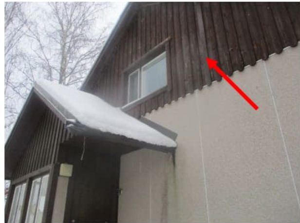
Ulkoseinien kivilevyverhouksen pinnoite on paikoitellen erittäin huonokuntoinen sekä julkisivuverhouksen ja muiden puuosien maalipinta oli kulunut.
