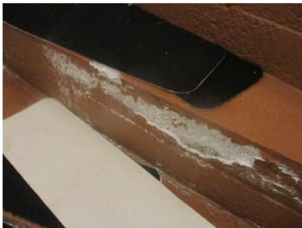
Kellarin käytävän alapohjarakenteessa, portaissa sekä maanpaineiseinissä havaittiin lähes kauttaaltaan kohonneita pintakosteuksia sekä paikoitellen runsaasti kosteuteen viittaavaa kalkkihärmää ja levypinnoilla tummentumaa.
