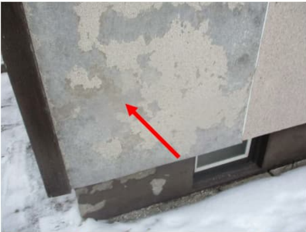
Ulkoseinien kivilevyverhouksen pinnoite on paikoitellen erittäin huonokuntoinen sekä julkisivuverhouksen ja muiden puuosien maalipinta oli kulunut.
