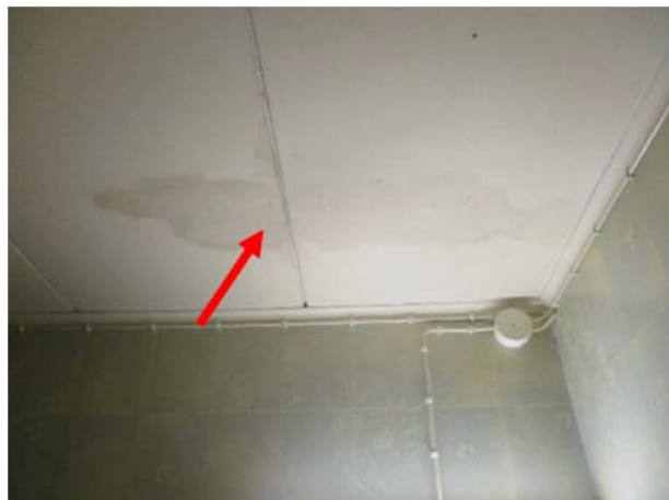
Tilan lattiassa havaittiin kohonneita pintakosteuksia sekä laipiossa vuotojälkiä.
