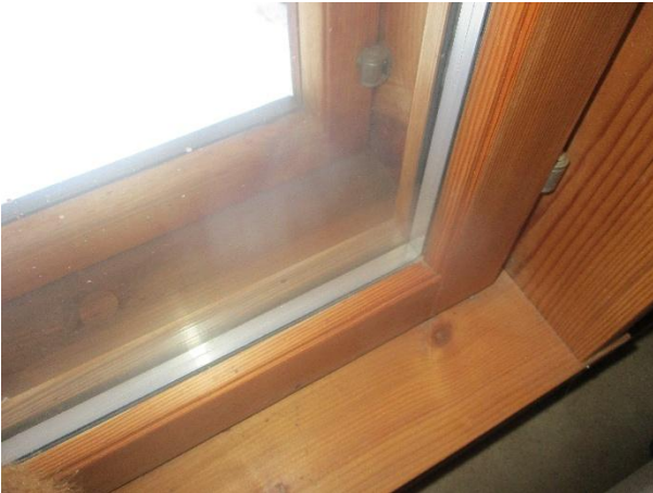
Osa ikkunoista on puupuitteisia.
