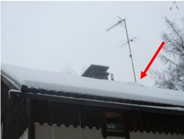
Rakennuksen yläpohjaan on kulku vesikatolla sijaitsevan huoltoluukun kautta, joka ei ollut sääolosuhteista johtuen tarkastettavissa.
