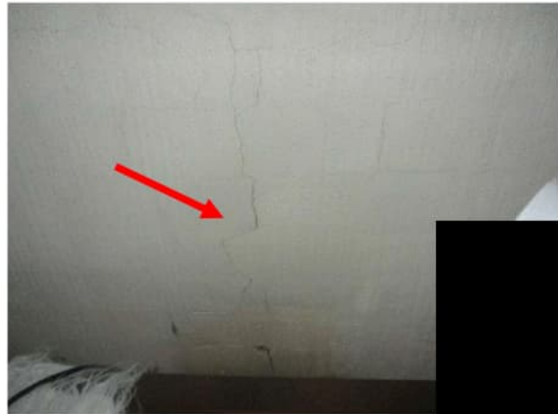
Keskikerroksen makuuhuoneen takassa oli havaittavissa halkeamia ja saatujen tietojen mukaan se on käyttökiellossa.
