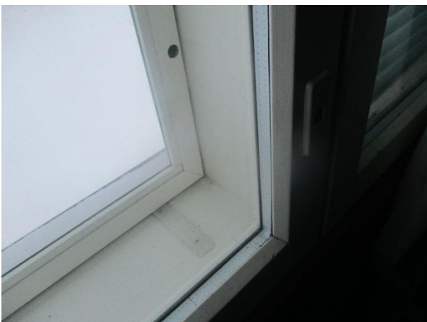
Ikkunat ovat pääosin uusittuja 3-lasisia (eristyslaselementti sisäpuutteessa) ja puualumiinipuitteisia ikkunoita. Osassa ikkunoissa on tuuletusikkunat, jotka ovat varustettu aukipitolaiteilla.
