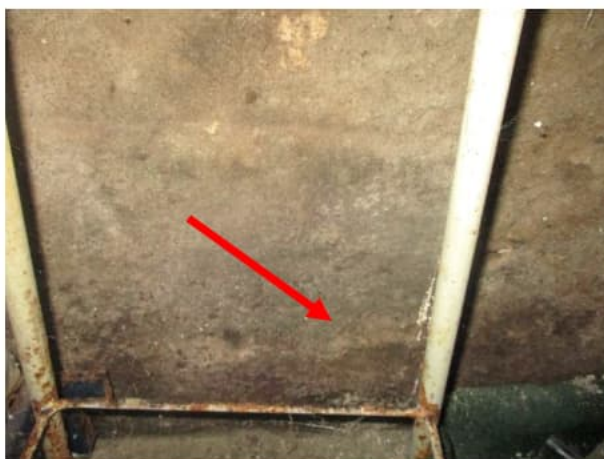
Kellarin varaston alapohjarakenteessa sekä maanpaineiseinissä havaittiin lähes kauttaaltaan kohonneita pintakosteuksia sekä paikoitellen runsaasti kosteuteen viittaavaa kalkkihärmää ja levypinnoilla kasvustoa.
