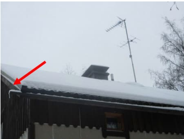
Kattovedet ovat johdettu räystäskouruista rakennuksen vierustalle.
