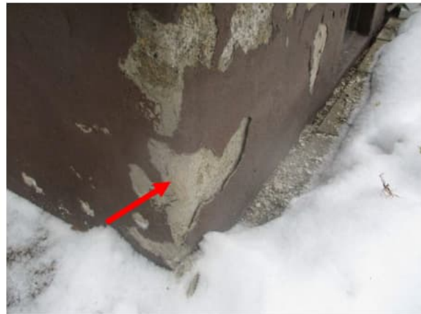
Sokkelin / perusmuurin pinnoitteessa oli havaittavissa runsaasti kosteuden aiheuttamaa rapaumaa ja pinnoitteen sekä sokkelin korjaus on ajankohtaista.
