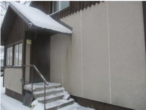
Sisäänkäynnin betoniportauksissa oli havaittavissa rapaumaa.
