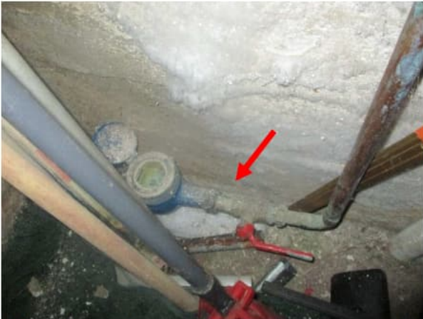
Rakennuksen tulovesiputki ja vesimittari sijaitsevat kellarikerroksen varastossa ja lämminvesivaraaja pukuhuoneessa / kodinhoituhuoneessa. Vesimittarin kiinnitys on puutteellinen.
