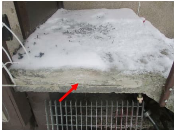
Ulkoseinien kivilevyverhouksen pinnoite on paikoitellen erittäin huonokuntoinen sekä julkisivuverhouksen ja muiden puuosien maalipinta oli kulunut.
