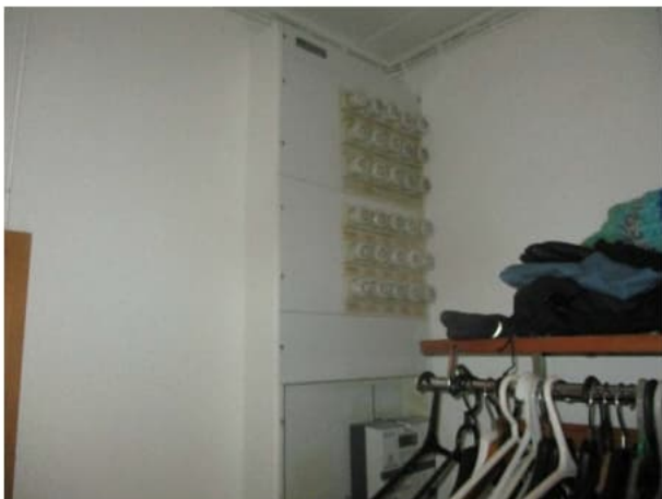
Sähköpääkeskus (pääsulakkeet 3X25 A) ja sähkömittari sijaitsevat eteisessä.
