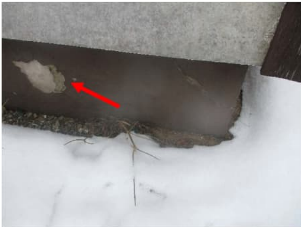
Sokkelin / perusmuurin pinnoitteessa oli havaittavissa runsaasti kosteuden aiheuttamaa rapaumaa ja pinnoitteen sekä sokkelin korjaus on ajankohtaista.
