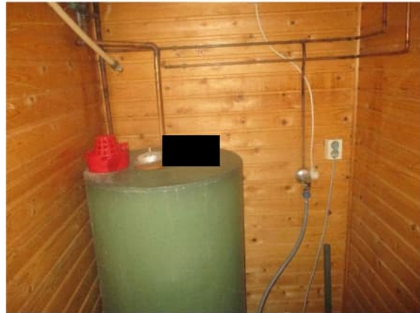
Rakennuksen tulovesiputki ja vesimittari sijaitsevat kellarikerroksen varastossa ja lämminvesivaraaja pukuhuoneessa / kodinhoituhuoneessa. Vesimittarin kiinnitys on puutteellinen.
