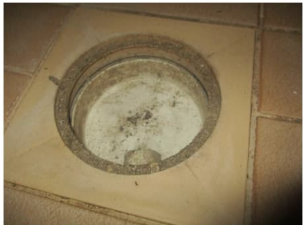
Päällisin puolin saunan lattiakaivossa ei havaittu poikkeavaa / vaurioita.
