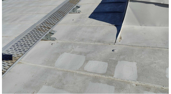
Kuva 6 Peltikateosuuksia on paikattu vastikään.
