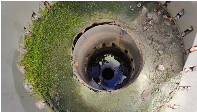
Kuva 19 Käännetyn rakenteen kaivo avattuna.
