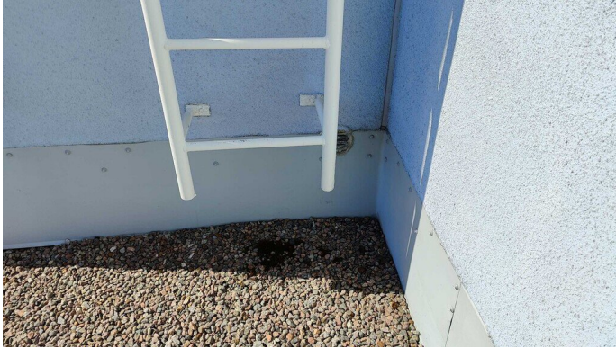
Kuva 23 Saunan (?) korvausilmaventtiilin sijainti haastava B-portaan sisäkulmauksessa, jossa arviolta suuri kinoskuorma talvisin.
