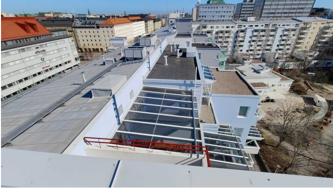
Kuva 5 Yleiskuva vesikatteen keskivaiheilta.
