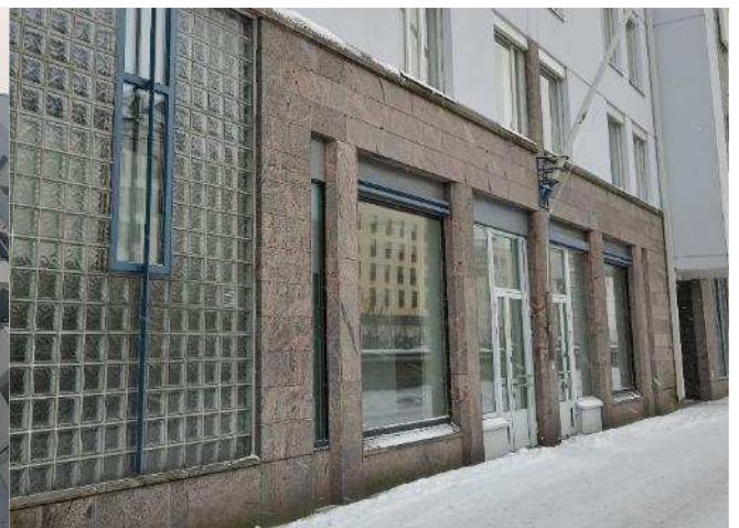
Kuva R16. Julkisivun graniittilaatoitusta ja lasitiiliä (katujulkisivu)
