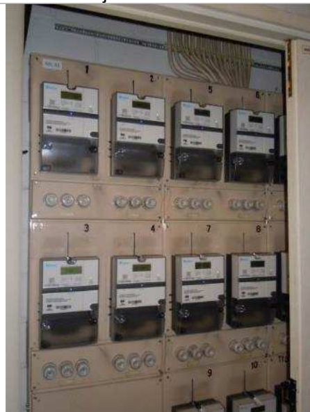
Kuva S-7, Asuntojen monimittari-keskus MKA1
