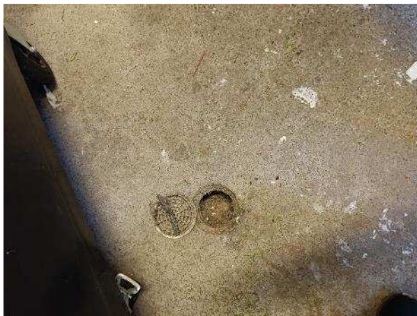
Kuva R6. Jätehuoneen lattiakaivo
