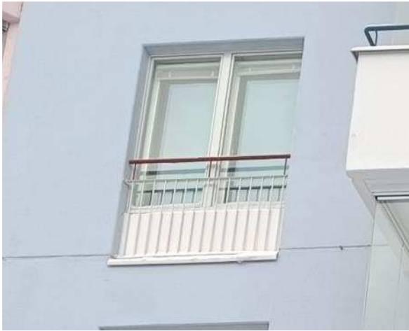
Kuva R24. Yleiskuva tyypillisestä huoneistoikkunasta sisäpihan puolella
