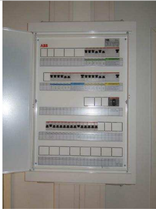
Kuva S-5, Uusi kerhotilan keskus
