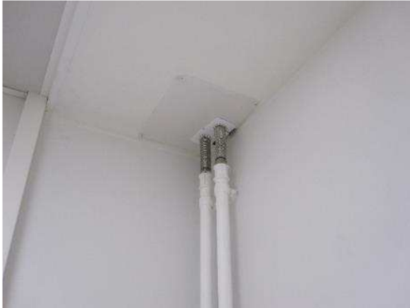
Kuva LVI-5. Patteriverkoston joustavat liittimet nousujohdoissa.
