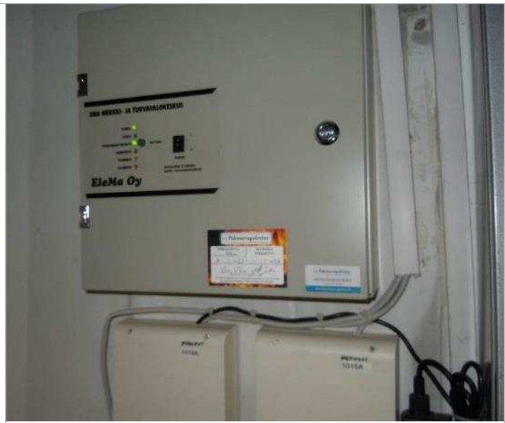
Kuva S-8, Uusi merkkivalokeskus Elema Oy
