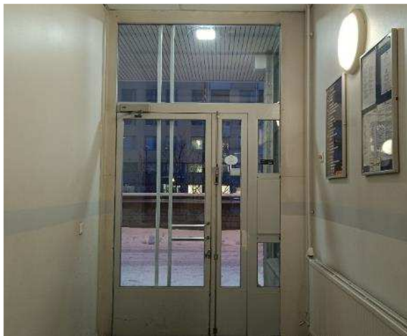
Kuva R32. Porrashuoneen sisäänkäynti
