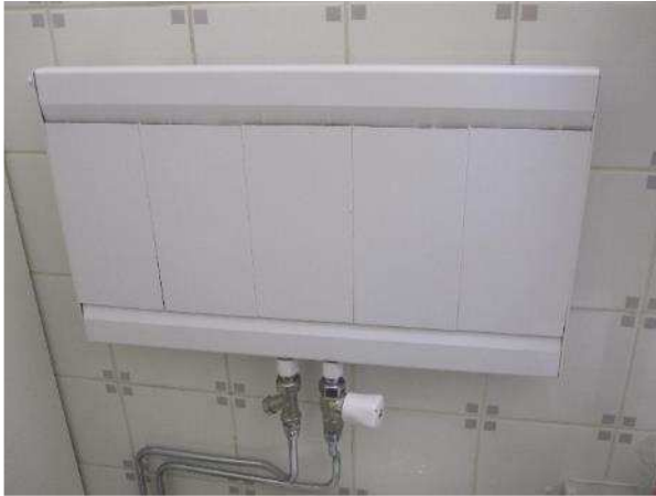
Kuva LVI-11. WC:n käyttövesipatteri.
