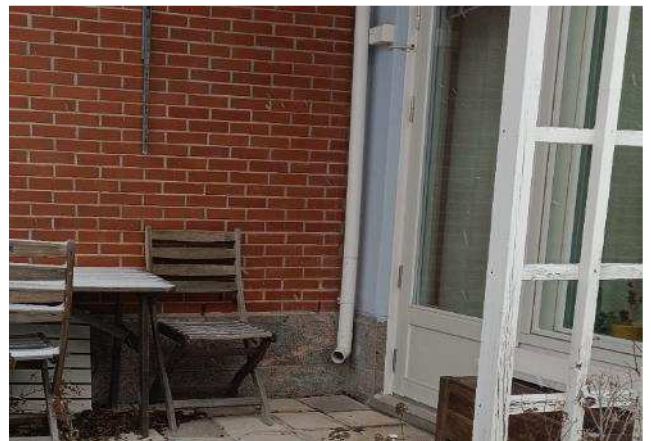
Kuva R9. Sisäpihan puolen syöksytorvi
