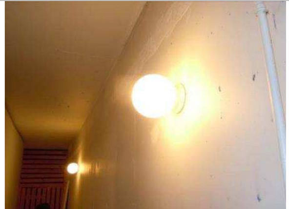
Kuva S-18, Vanha pallokupuvalaisin
