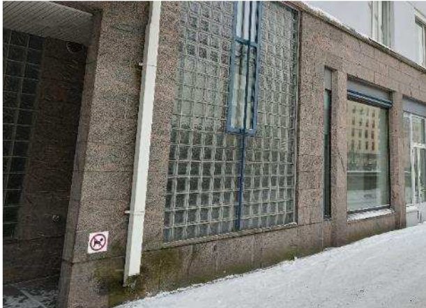
Kuva R8. Kadun puolen syöksytorvi
