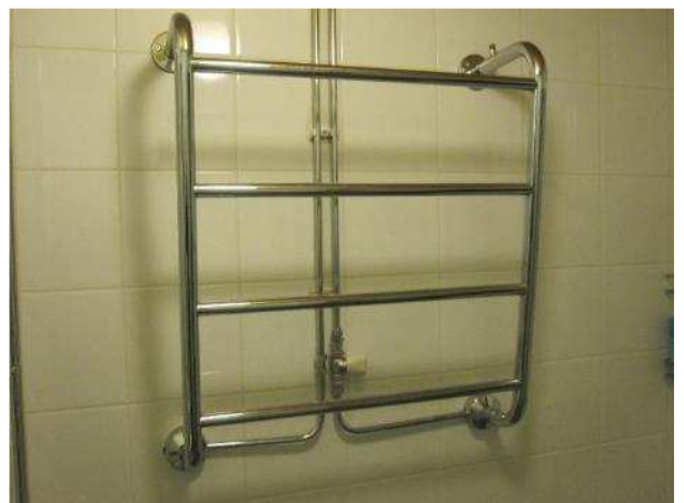
Kuva LVI-10. Käyttövesipatteri.
