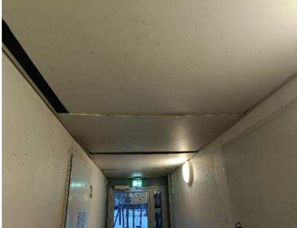
Kuva R42. Kellarikäytävien kuitusementtikattolevyt
