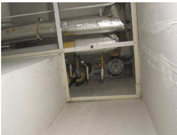
Kuva LVI-9. Sulku- ja linjasäätöventtiilit.
