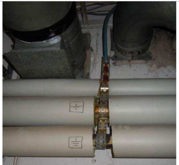
Kuva S-2, Putkistomaadoitukset
