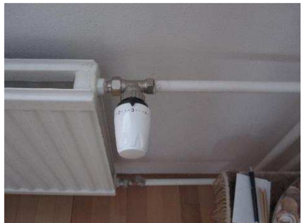
Kuva LVI-8. Termostaattinen patteriventtiili mallia TA TRV-2.
