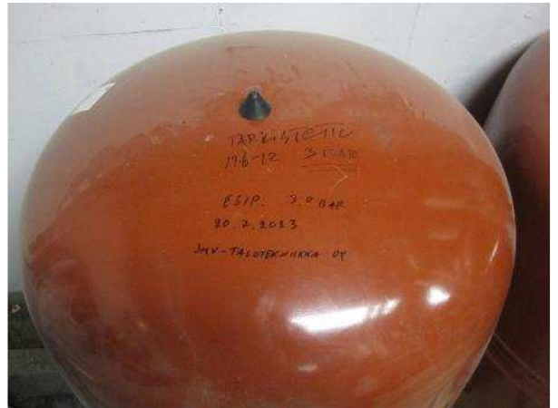
Kuva LVI-4. Patteriverkoston paisuntasäiliöt, 2x 400 litraa.
