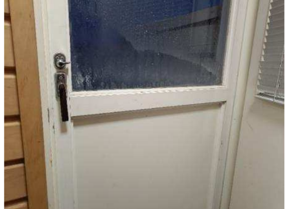
Kuva R28. Saunaosaston kattoterassin ulompi ovilehti oli jäässä
