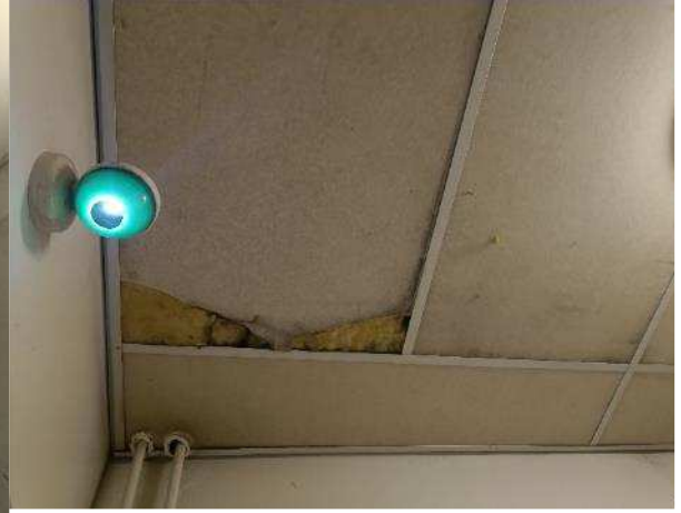
Kuva R43. Kellarikäytävien kattolevyt
