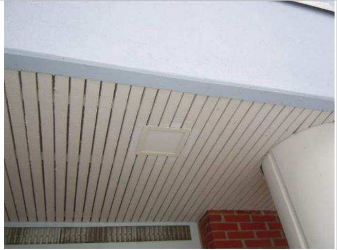
Kuva S-16, Sisäänkäynnin valaisin
