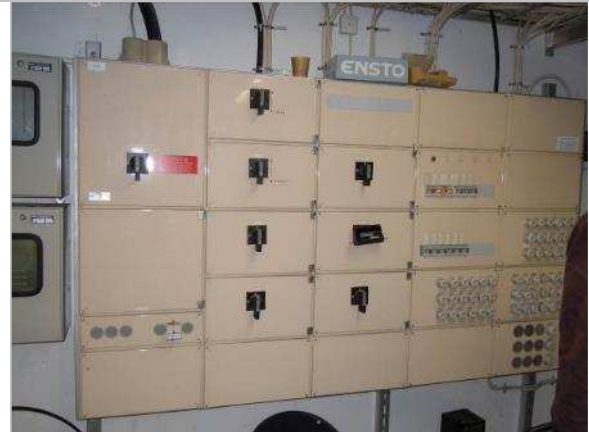
Kuva S-4 Kiinteistökeskus KK
