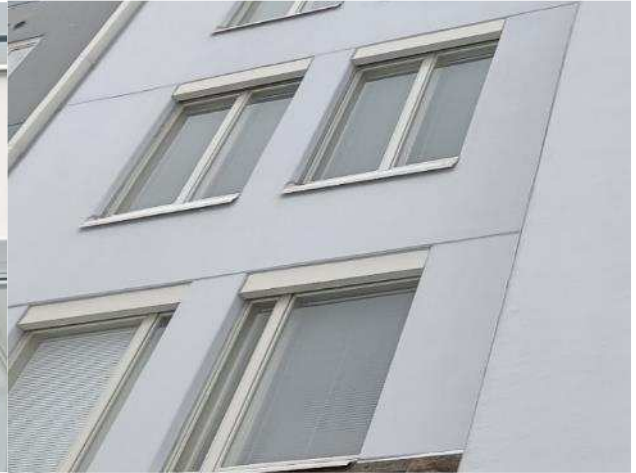
Kuva R25. Tyypillinen huoneistoikkuna kadun puolella
