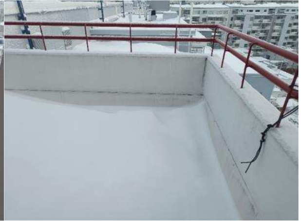
Kuva R21. Parvekkeen betoni- ja teräsrakenteiset kaiteet.
