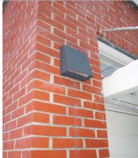
Kuva S-15, Julkisivun uusi valaisin
