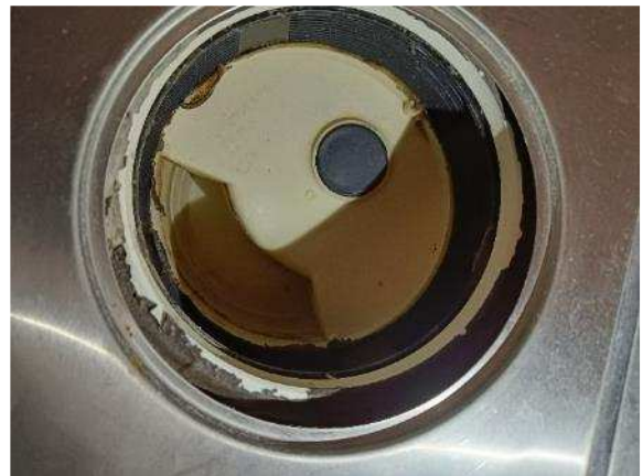
Kuva R35. Vanha lattiakaivo
