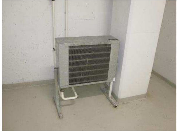
Kuva LVI-12. Kuivaushuoneen lämminilmakoje.
