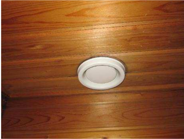
Kuva LVI-19. Poistoilmaventtiili.
