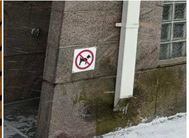
Kuva R11. Sokkelin ulkopintaa
