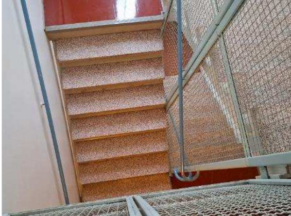
Kuva R36 Yleiskuvaa portaikosta
