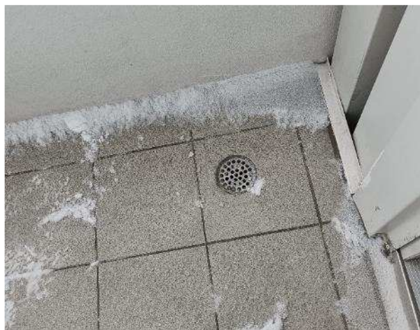
Kuva R22. Parvekkeen vedenpoisto
