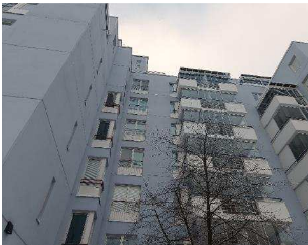
Kuva R15. Yleiskuva sisäpihan puolen julkisivulta.
