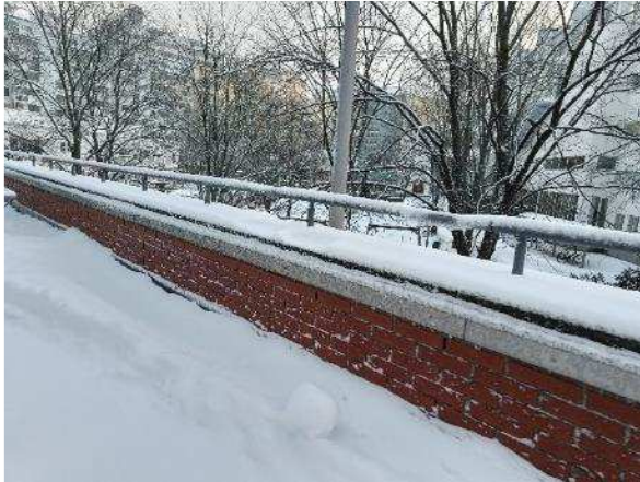
Kuva R4. Sisäpihan kaide
