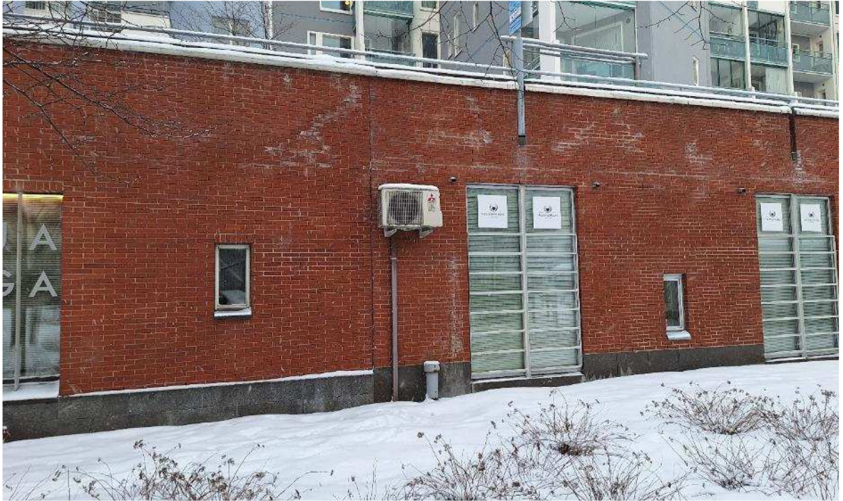
Kuva R19. Pihakannen alapuolisten tilojen tiilijulkisivu
