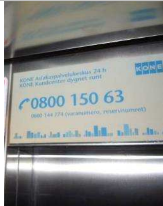
Kuva S-23, Hissin huoltotyryitys
