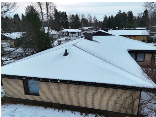
Kuvat 10. Talossa on profiloitu peltikate
