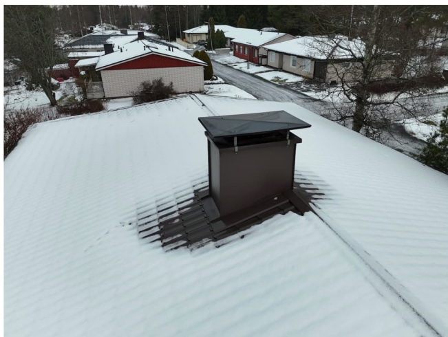
Kuva 11. Läpiviennit tulee tarkastaa ja tiivistää
