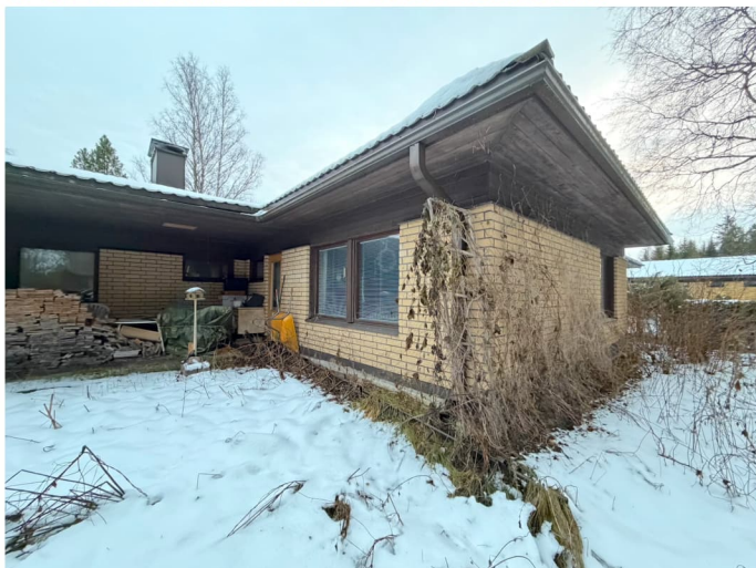
Kuva 14. Sokkelin vierustan istutukset tulee poistaa.
