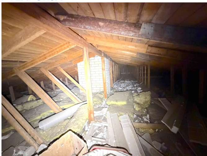
Kuva 12. Vesikaton kantavien rakenteiden kunto on hyvä.
