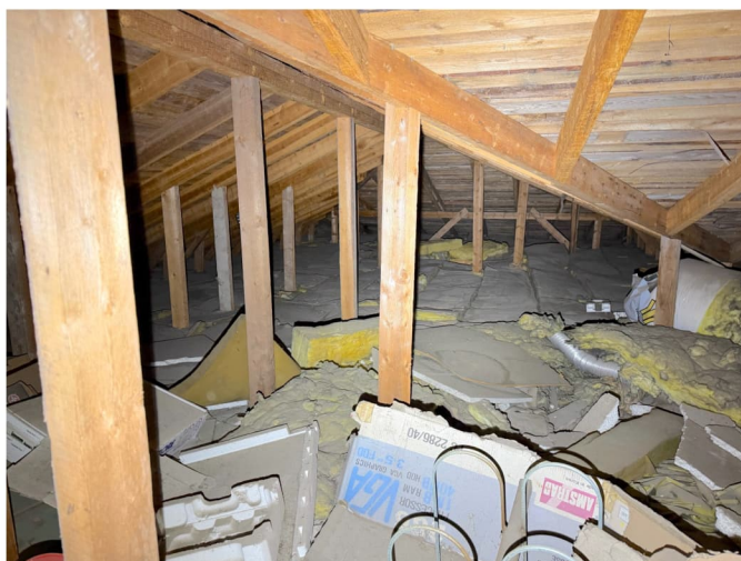
Kuva 13. Irtain tulee poistaa, poljetut eriste villat uusia.
