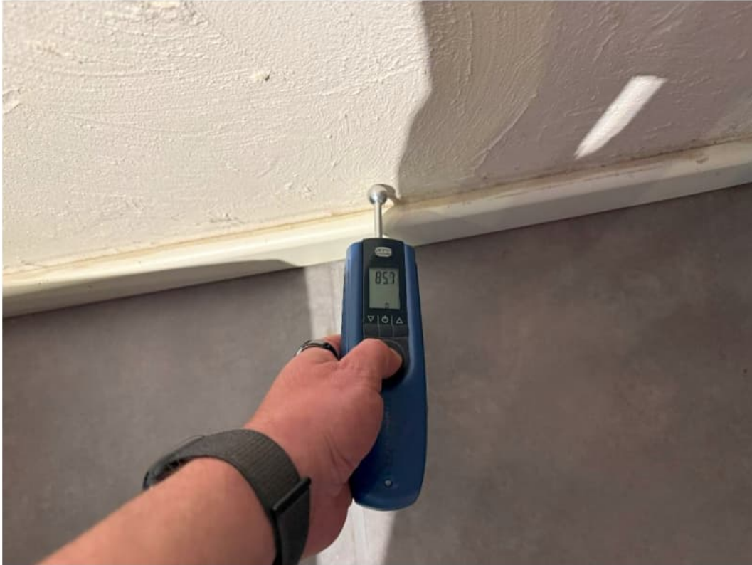
Kuva 9. Takapihan seinää alapäästä
