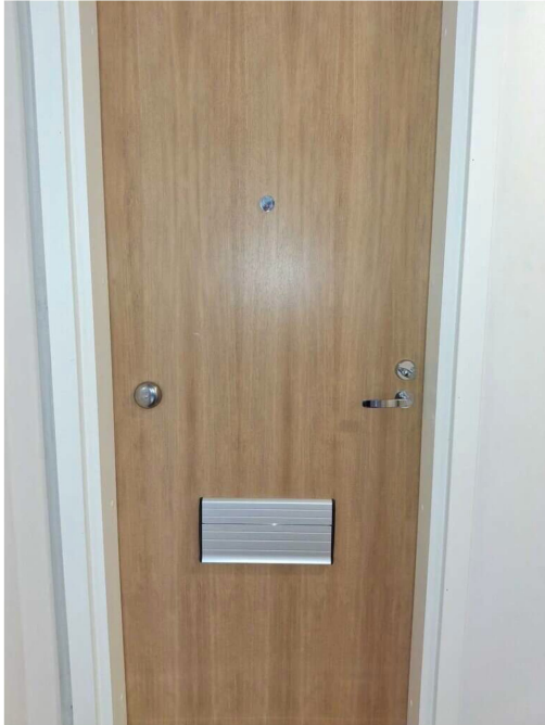
Kuva 4 Huoneiston ulko-ovi on uusittu.
