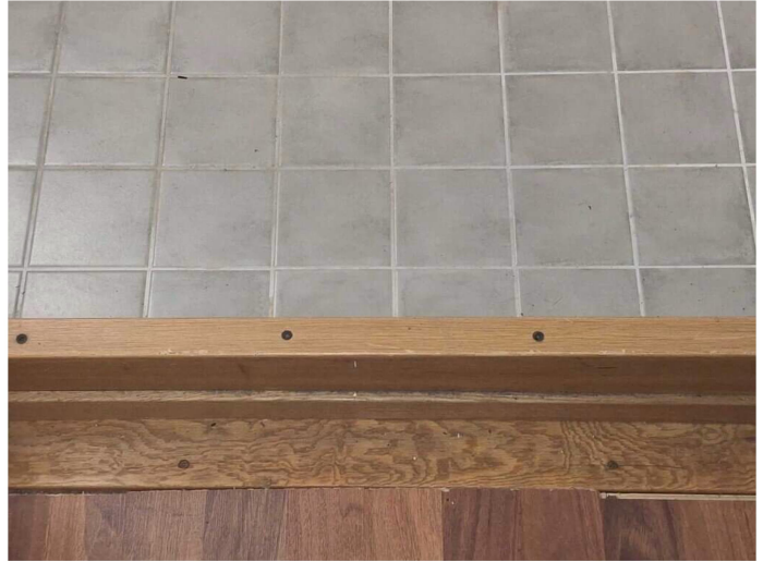
Kuva 21 Kylpyhuoneen oviaukolla on kynnysnosto.
