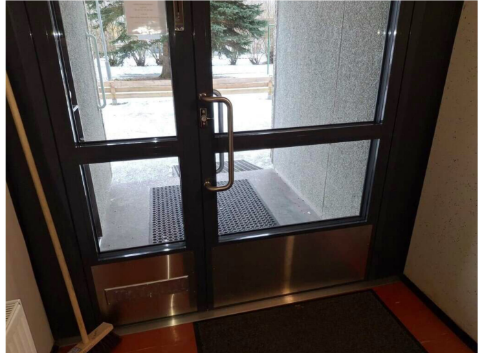
Kuva 5 Rakennuksen ulko-ovet on uusittu.
