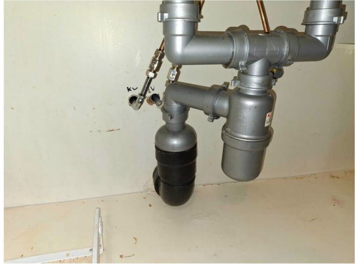
Kuva 17 Keittiön allaskaapin rakenteissa ei havaittu vaurioita, pohjalevyssä vanhoja kosteusjälkiä. Viemärointi on mustaa Pvc muovia.
