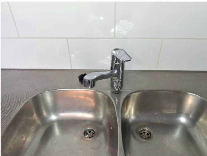
Kuva 14 Keittiön altaan sekoittaja on uusittu.
