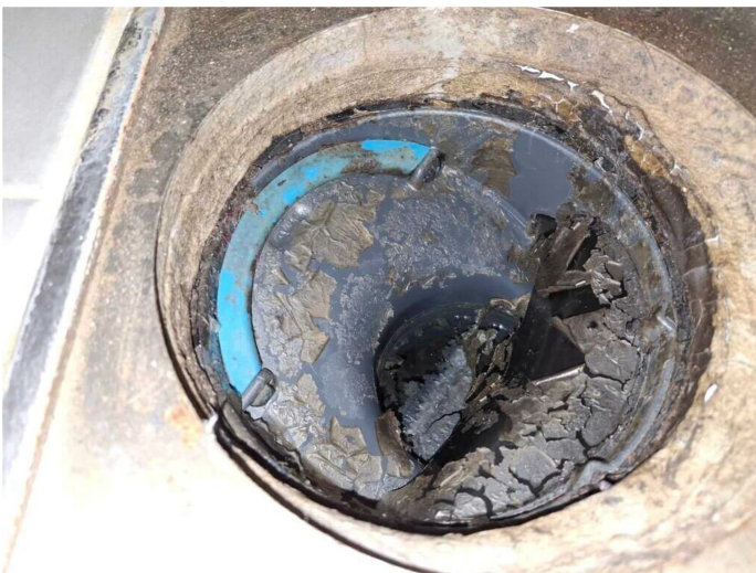
Kuva 18 Kylpyhuoneen kaivo on siirretty / uusittu.
