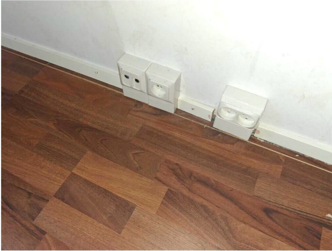
Kuva 16 Huonetoissa sähköasiat on asennettu pintaan.
