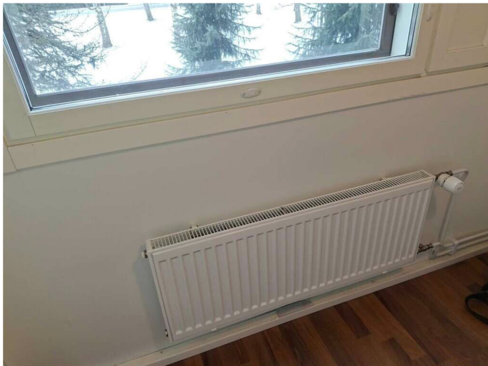
Kuva 6 Olohuoneen patteri , termostaatti ja putkisto on uusittu.
