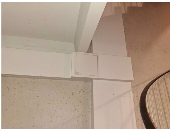
Kuva 3 Rakennukseen on suoritettu linjasaneeraus käyttövesi ja patteriputkiston osalle.
