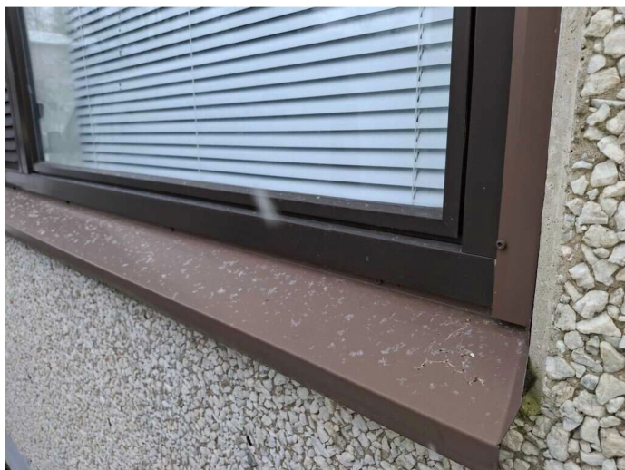
Kuva 2 Ikkunat uusittu vesipellityksin vuonna 2012.
