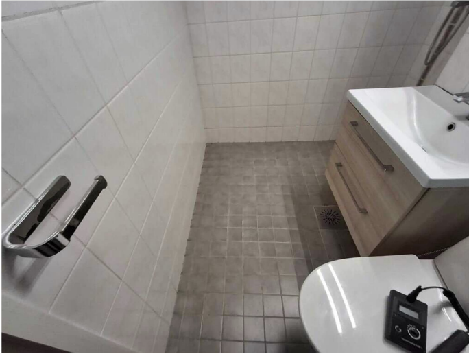
Kuva 12 Kylpyhuone on saneerattu vedeneristein.
