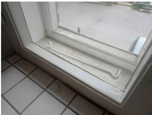
27. Ikkunat ovat MS -tyyppiset puuikkunat.
