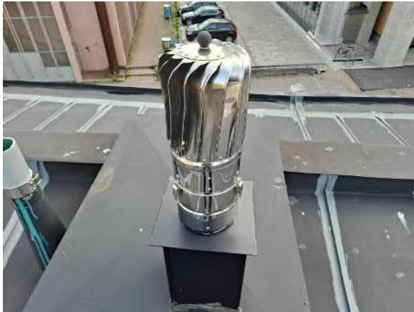
72. Tuulituuletin vesikatolla.
