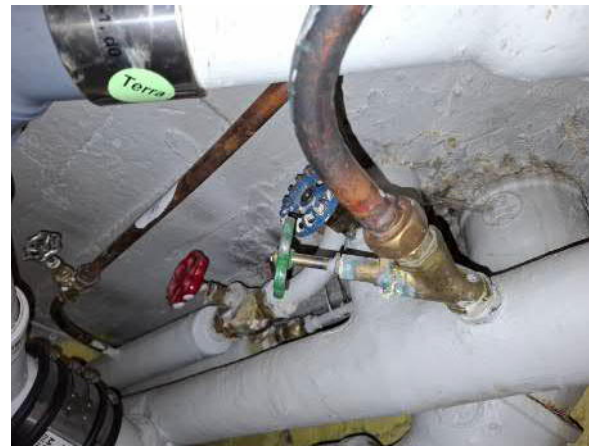
62. Käyttöveden linjaventtiileitä.
