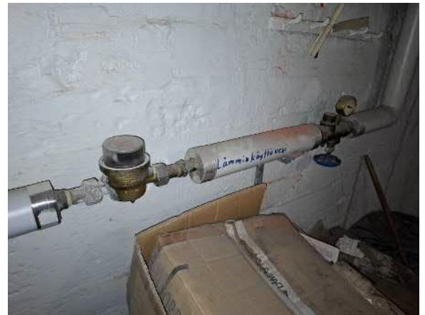
60. Myös lämmintä käyttövettä mitataan.
