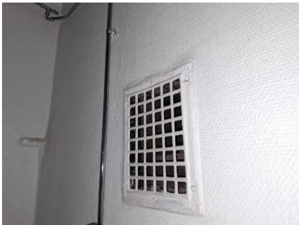
74. Alkuperäinen valurautasäleikkö.
