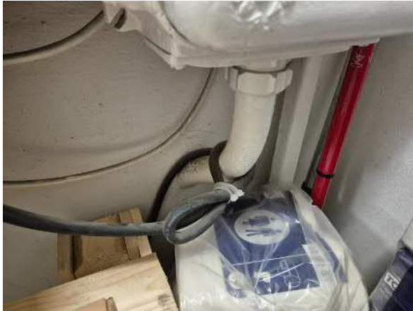
87. Liittymisjohto kulkee putkessa pääkeskuksen sinetöityyn osaan.
