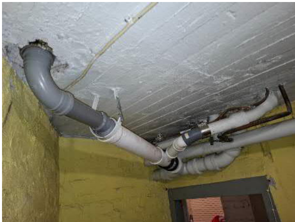
67. Viemärien uusintoja muoviksi on tehty paikoittain.
