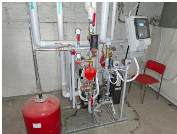
51. Lämmönjakokeskus.
