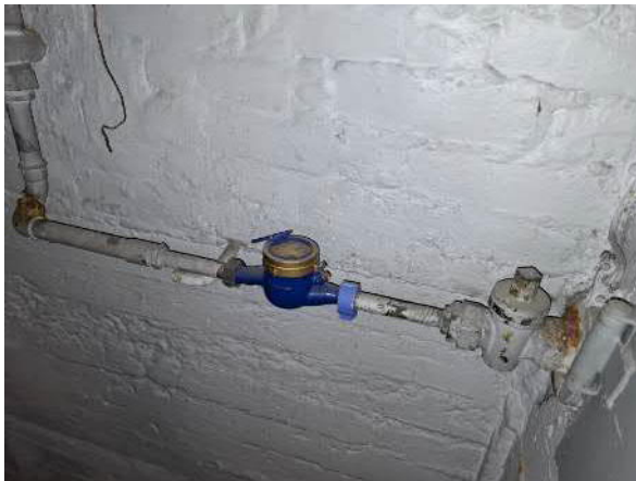
59. Kiinteistön päävesimittari.
