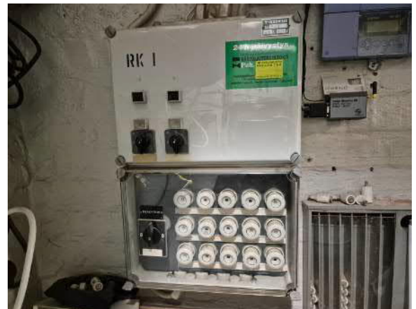
81. Lämmönjakohuoneen keskus.
