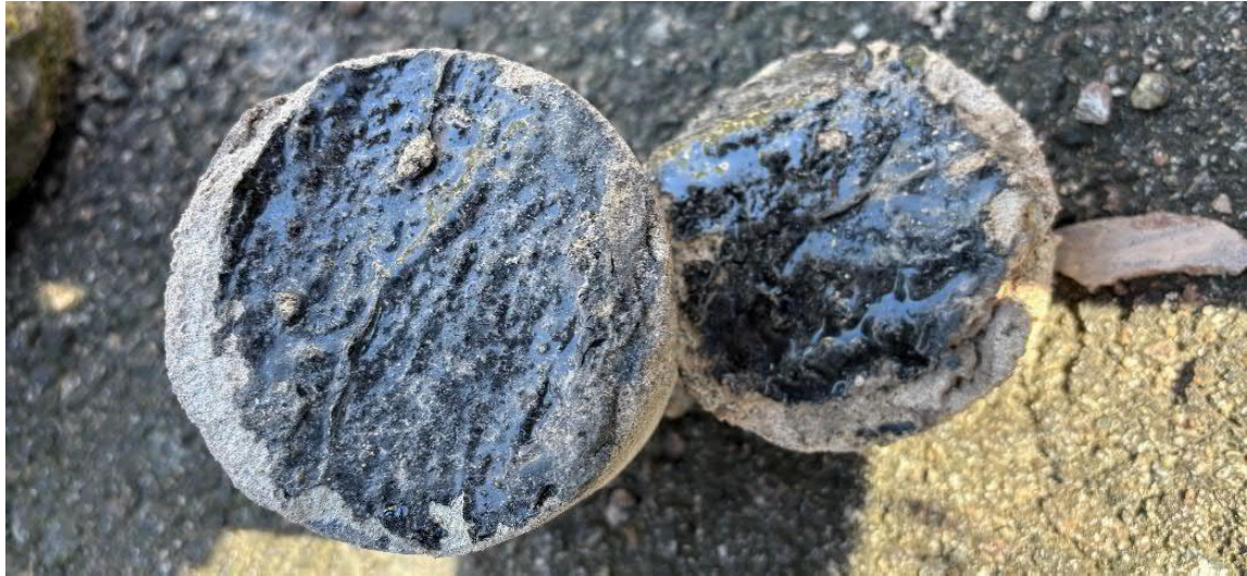
Kuva 13. Ulkoseinän graniittisokkelin takana olevan bitumivedeneristeen purkutyössä tulee huomioida, että henkilösuojautusta edellyttävä ohjearvo ylittyy.
