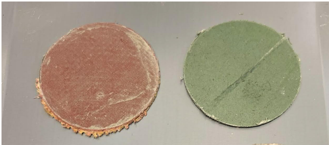
Kuva 22. Alkuperäisen märkätilan kohdalla oleva punainen muovimatto sisältää DEHP-yhdisteitä. Matto on peitetty vastaavalla vinyylilaatalla, kuin kerroksessa 2.
