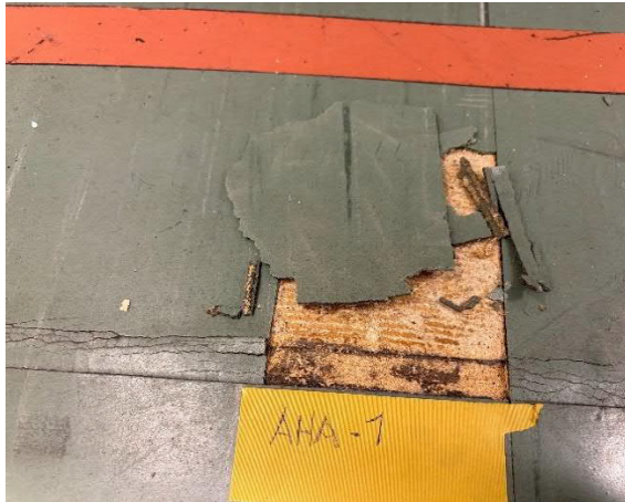
Kuva 20. Vihreä vinyylilaatta sisältää DEHP yhdisteitä
