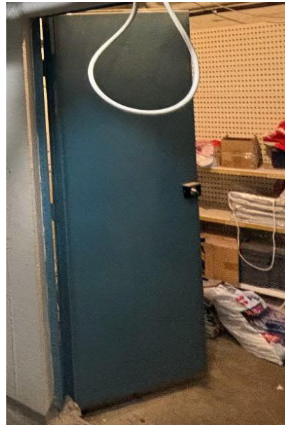
Kuva 11. Palo-ovi kuvattuna lämmönjakohuoneen puolelta.
