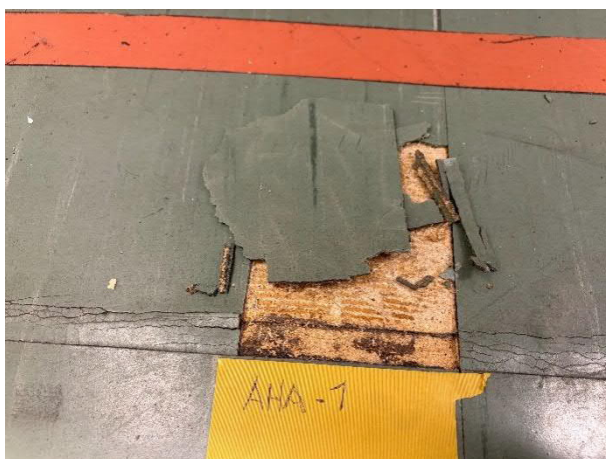
Kuva 24. Vihreä vinyylilaatta sisältää SCCP yhdisteitä
