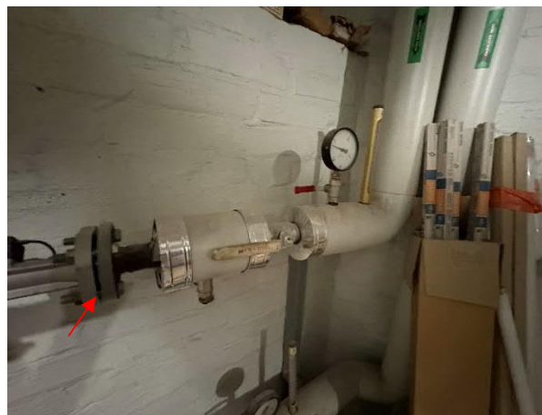
Kuva 12 a ja b. Putkistojen laippaliitosten tiivisteet sisältävät asbestia.
