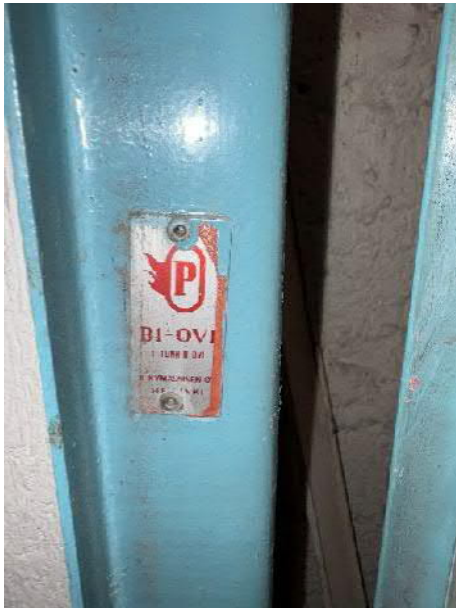
Kuva 10. Kellarin lämmönjakohuoneen ja porraskäytävän välinen ovi on alkuperäinen B2-luokan palo-ovi.
