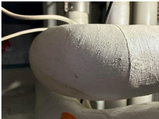
Kuva 8. Analyysivastauksen perusteella putkieristeissä ei todettu asbestia.
