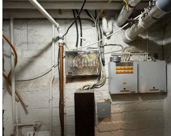
Kuva 26. Kellarikerroksessa on vanhoja, mutta edelleen käytössä olevia sähkölaitteita. Haitta-aineiden esiintyminen niissä on todennäköistä.
