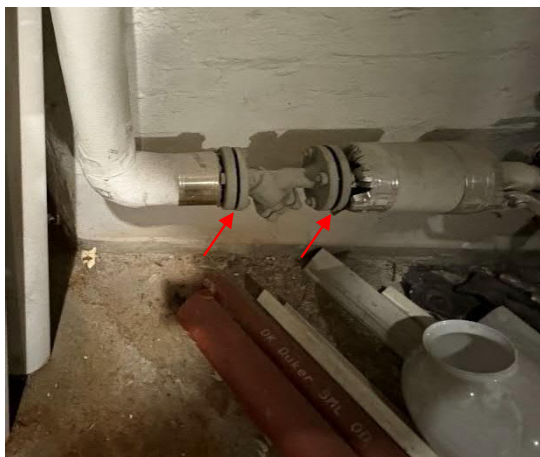
Kuva 12 a ja b. Putkistojen laippaliitosten tiivisteet sisältävät asbestia.
