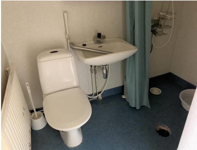
Kuva 5. Kytkentäviemärit irrotettu ja viemärinpäät tukittu, vedet pois päältä
