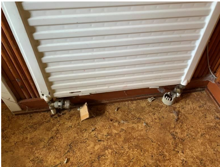
Kuva 3. Osa patteritermostaateista on rikki
