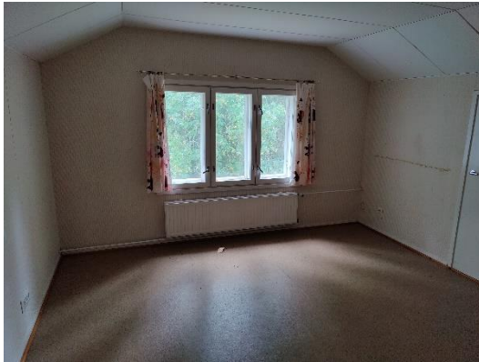
Yläkerran huoneissa ei merkkejä vesikattovuodoista
