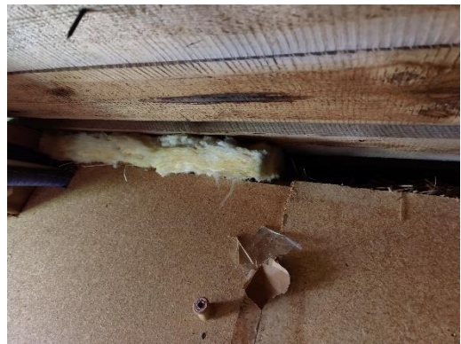
Lappeensuuntaisesti eristetyn osan ilmarakoa tilkitty villanpaloilla
