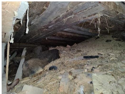
Alapohjapalkeissa ei havaittu lahovaurioita.
