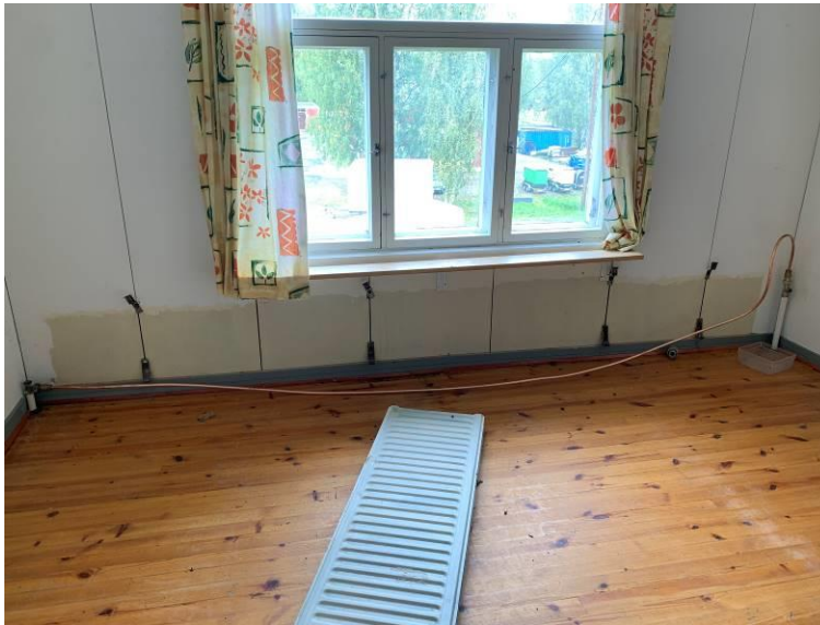
Kuva 2. Lämmityspatteri irrotettu ja patterin tilalle asennettu liitosputki
