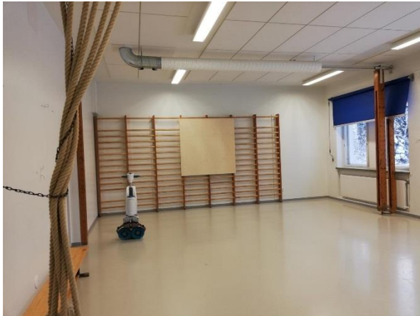
Kuva 9: Ensimmäisen kerroksen lattiapinta on pääosin muovimassapintaista.
