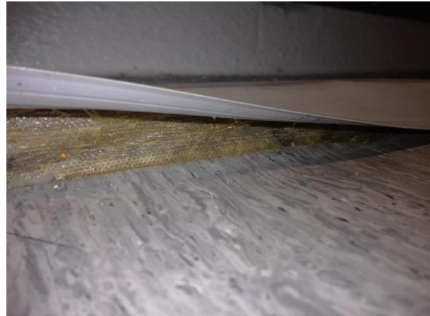
Kuva 13: Lattian ja seinän liitoskohdat ovat tiivistyskorjattu.
