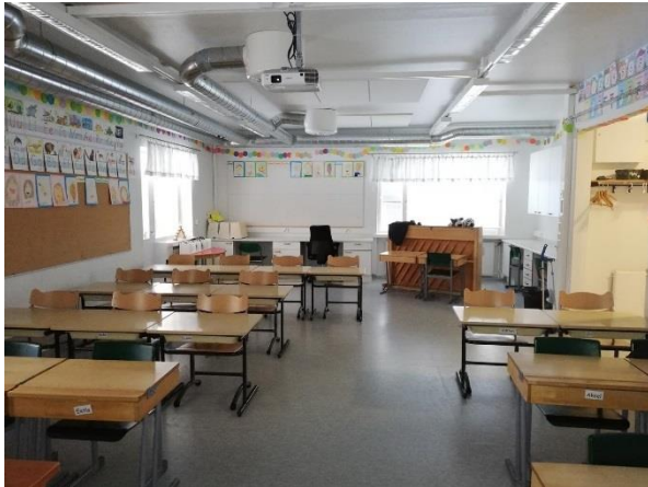
Kuva 12: Toisen kerroksen lattiapinnoitteena on käytetty muovimattoa.
