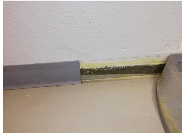
Kuva 10: Lattian ja seinän liitoskohdat on tiivistetty.
