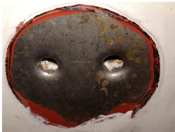
Kuva 9: Oven rakenteista on todettavissa asbestieristys.
