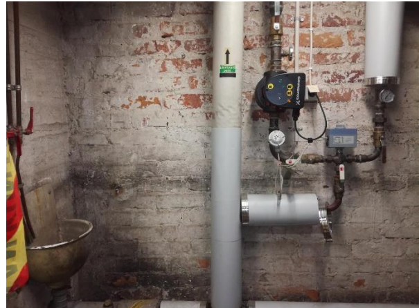
Kuva 4: Pannuhuoneen pinnoitteena katossa ja seinissä on tasoiteslammaus.
