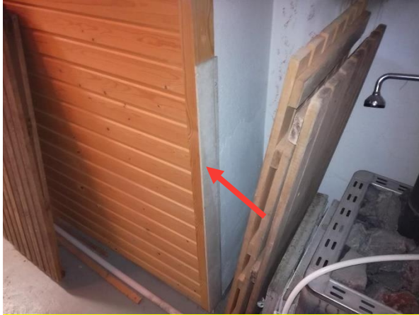
Kuva 10: Saunan seinässä vähäinen määrä kuitusementtilevyä.
