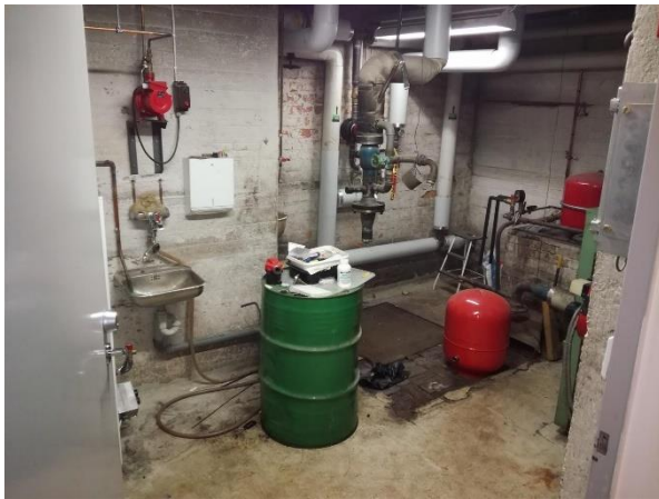
Kuva 12: Poistetun lämmityslaitteen kohdalla tiililadonnan alla vaalea, todennäköisesti asbestia sisältävä materiaalikerroks.
