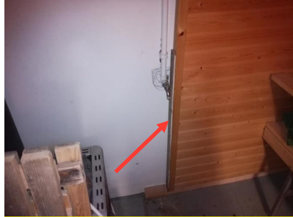
Kuva 11: Saunan seinässä vähäinen määrä kuitusementtilevyä.
