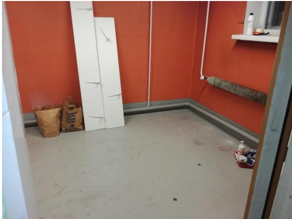
Kuva 19: Pesuhuoneessa lattiamaalit eivät sisällä lyijyä.
