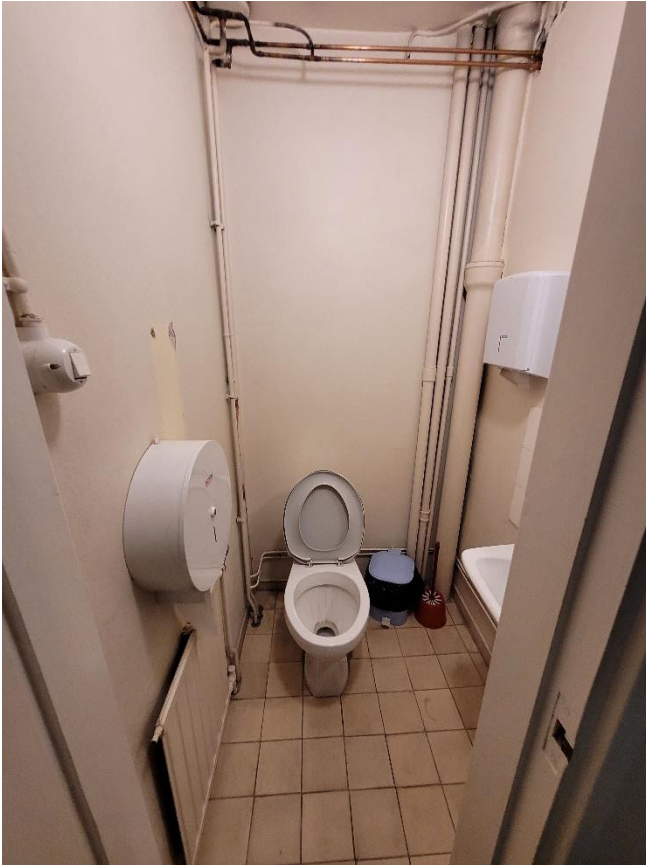
Kuva 25: Wc -tila. Pinnat kuluneet
