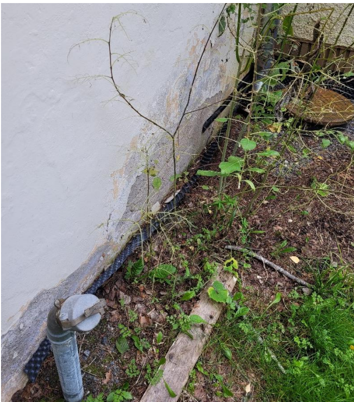
Kuva 12: Patolevyn yläosa irti. Taakse päässyt roskaa.
