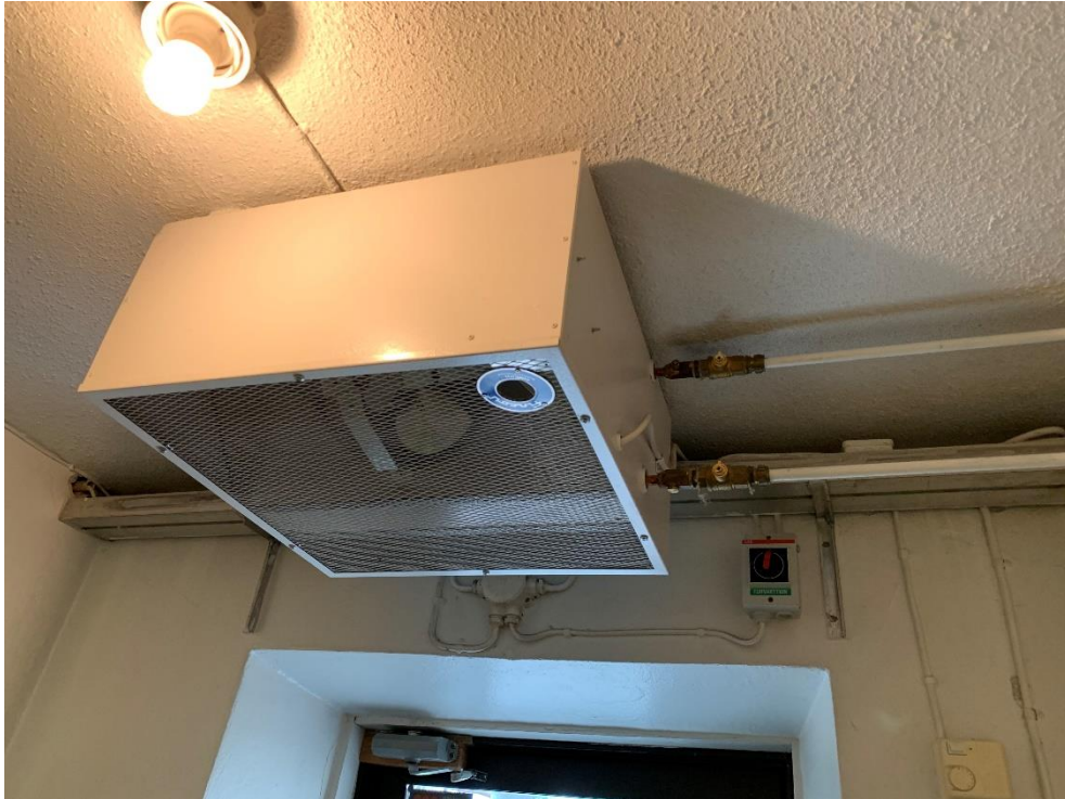
Kuva 5. Nuorisotilan oven päällä on lämminilmapuhallin
