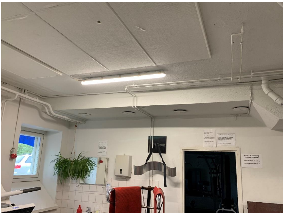
Kuva 10. Kiinteistössä on alkuperäisiä ilmanvaihtokanavia, jotka ovat muurattuja hormoneja, uudet ilmanvaihtokanavat ovat sinkittyjä kierresaumakanavia.
