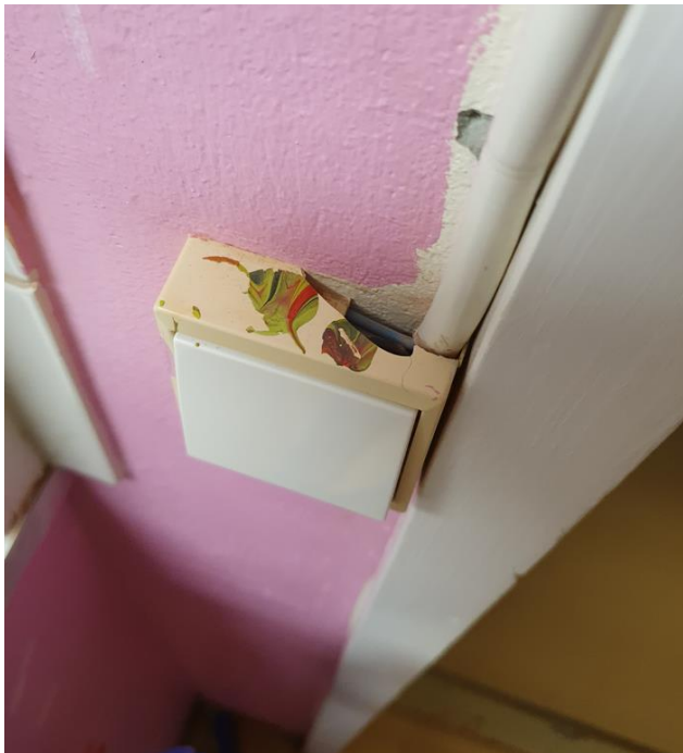
Kuva 7: Keittiön rikkiäinen valokytkin
