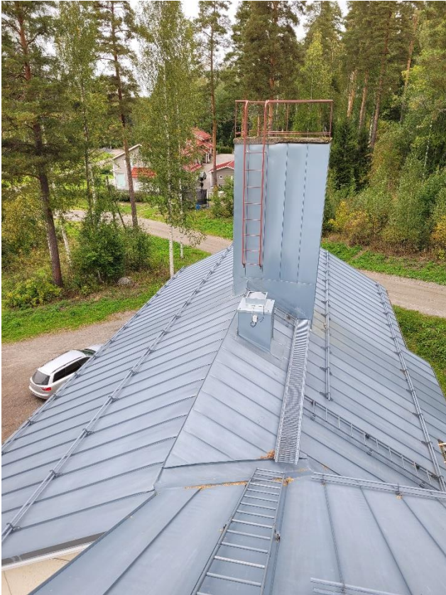
Kuva 11: Vesikatto hyvässä kunnossa
