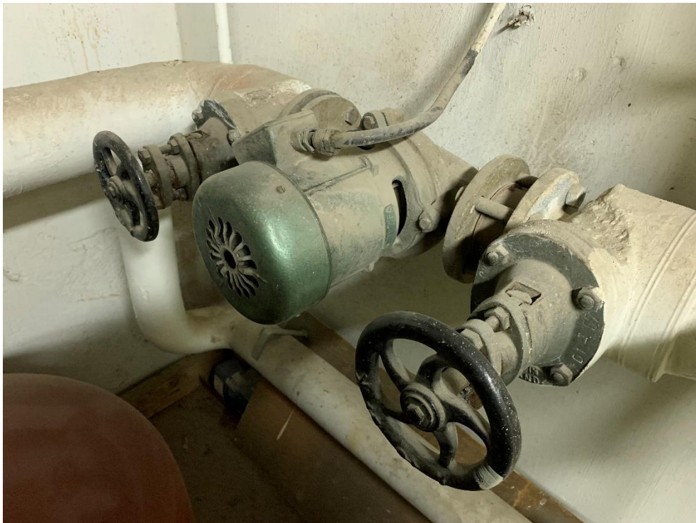
Kuva 2. Pumput ovat vanhoja, mutta niissä ei näy vuotojälkiä ja niiden käyntiäni on tasainen.
