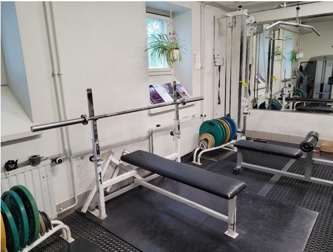
Kuva 16: Kellarin seinissä kolhuja
