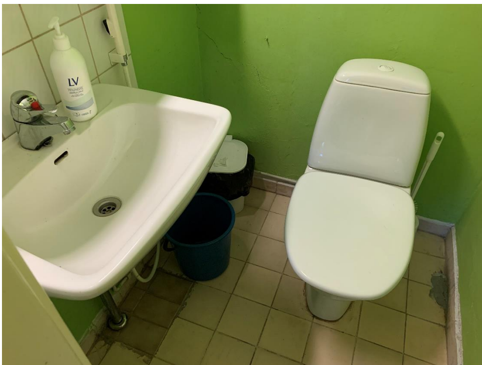
Kuva 8. Vesi- ja viemärikalusteet ovat eri ajankohtina uusittuja. Kalusteet ovat pääosin tyydyttävässä kunnossa ja kalusteiden laajamittaiseen uusimiseen ei ole tarvetta
