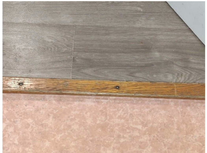
Kuva 13 Kylpyhuoneen oviaukolla on kynnysnosto.
