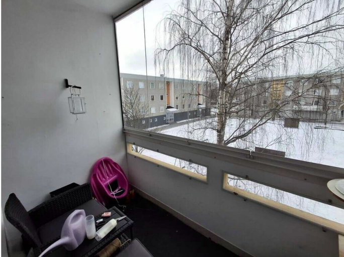
Kuva 2 Parveke on lasitettu.
