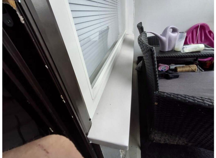
Kuva 3 Ikkunat on uusittu vuonna 2022, ikkunoihin on asennettu vesipellitykset reunanostoin.
