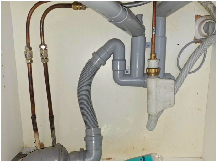
Kuva 17 Keittiön allaskaapin rakenteissa ei havaittu vaurioita.
