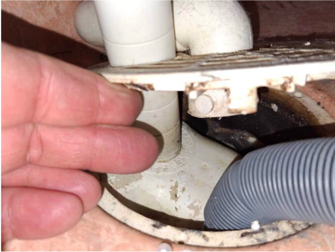
Kuva 10 Kylpyhuoneen lattiakaivo, kaivoon on liitetty muovimatto kiristysrenkaalla.
