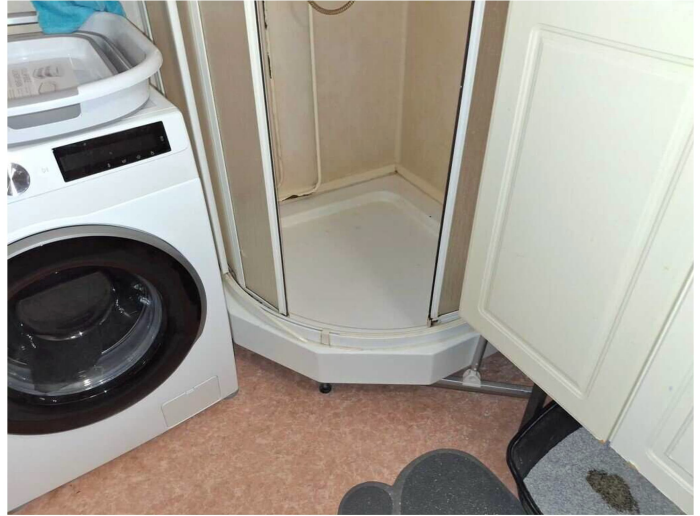
Kuva 7 Kylpyhuoneessa on suihkukaappi altaalla. Altaasta vesi johdetaan pintaviemäriputkella tilan lattiakaivoon. Kylpyhuoneen lattia ja seinäpintojen kosteus normaali.
