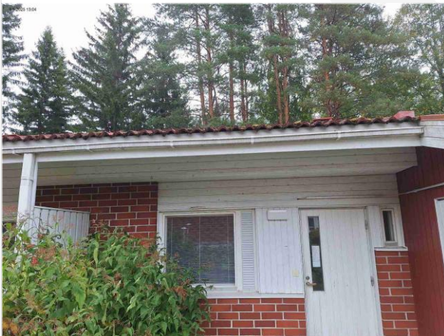
Kuva 107 Kaato puutteellinen, rivitalo
