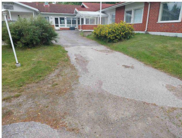
Kuva 8 Asfaltointi halkeili
