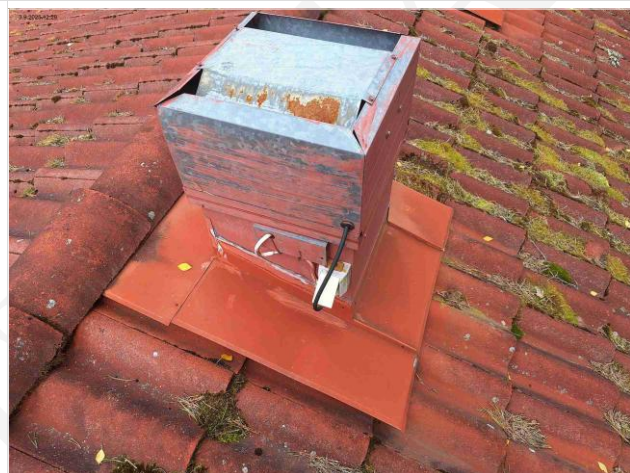
Kuva 167 Poistoimuri, rivitalo
