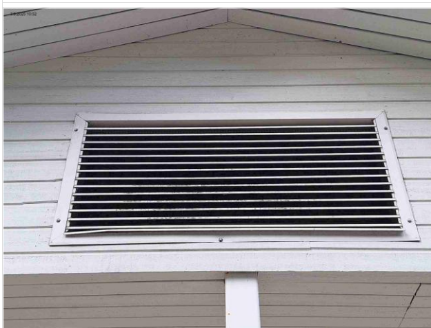
Kuva 172 Tuloilmasäleikkö likainen
