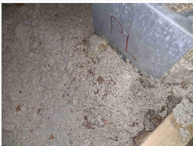
Kuva 55 Lämmöneristeen kastuneet
