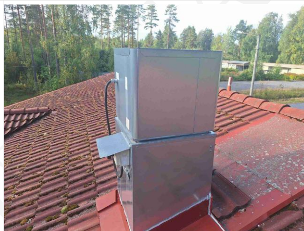
Kuva 161 Poistoimuri
