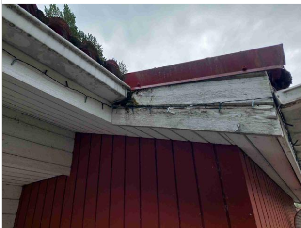
Kuva 80 Vuotojälki räystäslaudoituksessa
