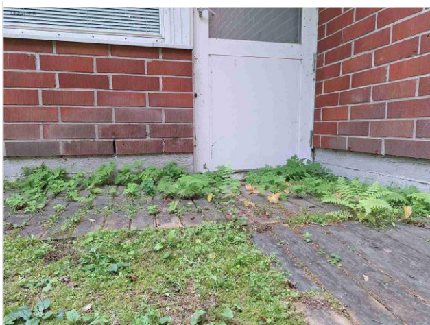
Kuva 28 Perustusten tasoerotarkastelu, lattiapinta maanpinnan tasolla
