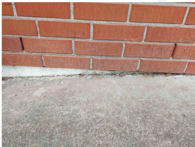
Kuva 70 Tuuletusraot tiiliverhoilussa
