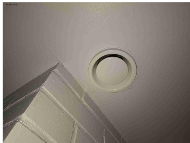
Kuva 169 Poistoilmaventtiili
