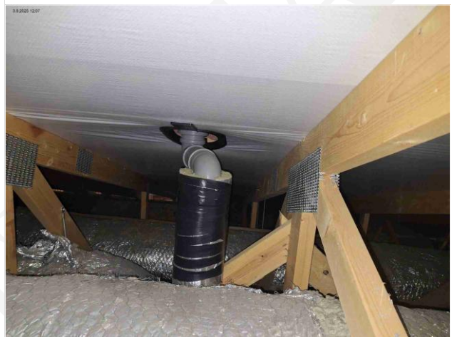
Kuva 66 Rako putkieristyksessä
