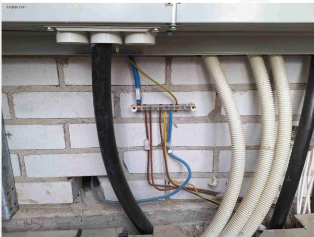
Kuva 187 Rivitalon maadoituskisko
