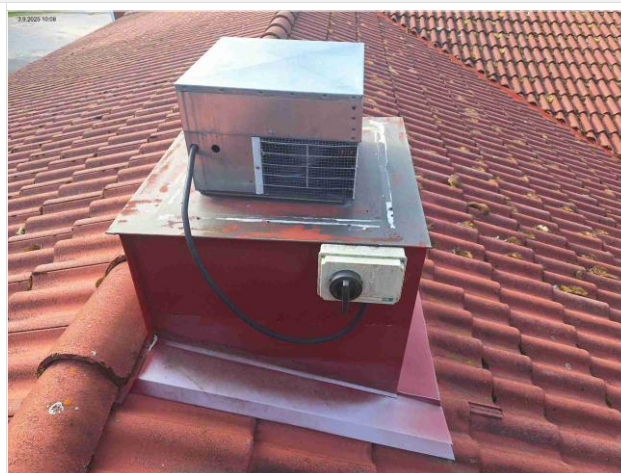
Kuva 157 Poistoimuri
