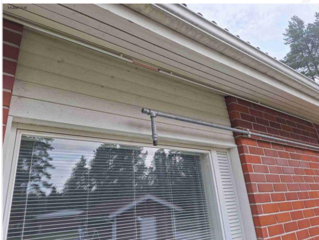
Kuva 177 Ikkunasuutin
