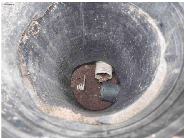
Kuva 5 Salaojakaivon pohjalla maa-aineksia
