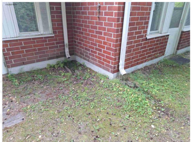
Kuva 25 Avokourut liian lyhyet
