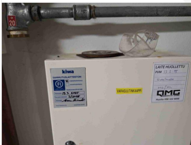
Kuva 176 Sammutuslaitteiston määräaikaistarkastuksen ja huollon merkinnät
