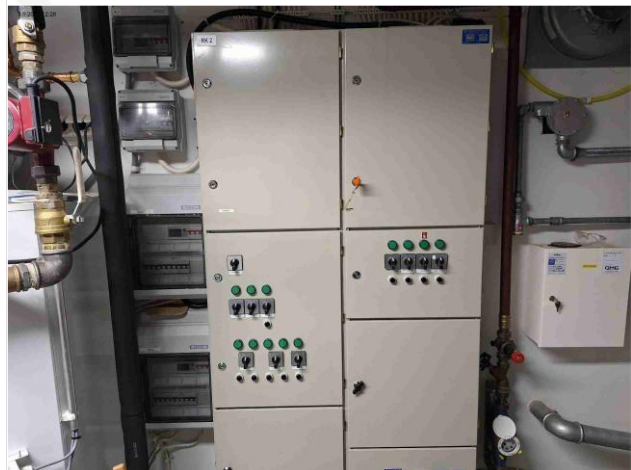
Kuva 188 Rk2 teknisessä tilassa
