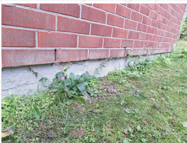
Kuva 31 Humusmaa kiinni perustuksissa
