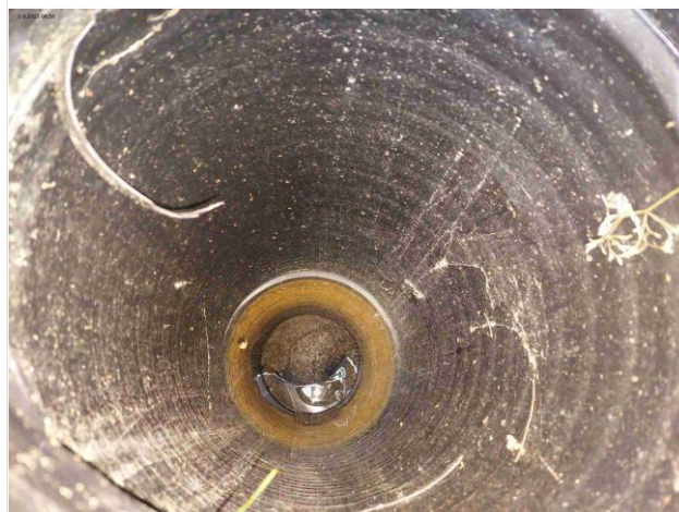
Kuva 6 Salaojakaivon pohjalla maa-aineksia
