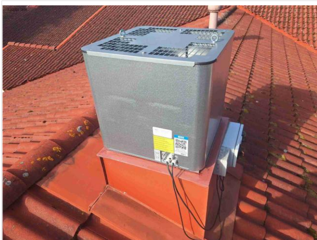
Kuva 158 Poistoimuri
