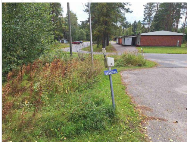
Kuva 198 Lämpötolpat vääntyneet
