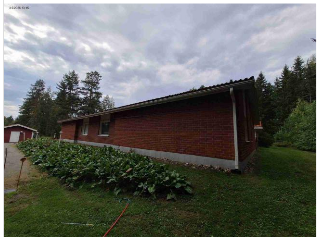
Kuva 110 Syöksyjen määrä riittämätön
