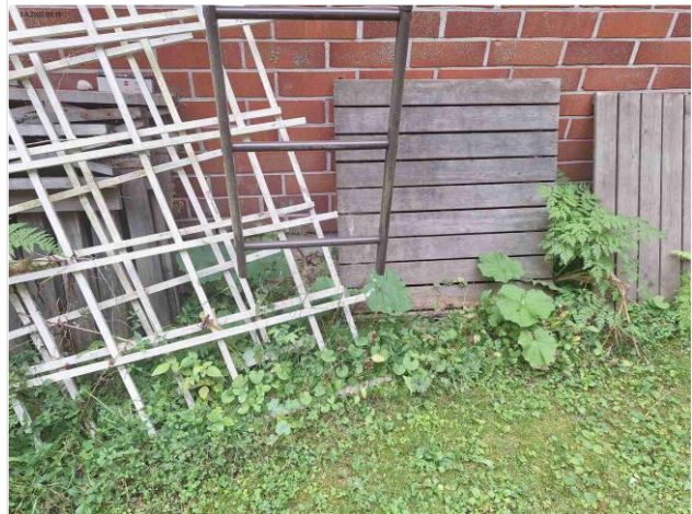
Kuva 114 Seinätikkaista puuttui kiipeilyeste
