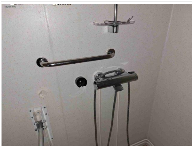
Kuva 148 Uusittu sekoittaja
