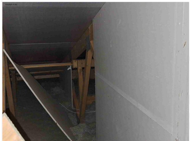
Kuva 64 Puutteita palokatkoseinälevytyksessä
