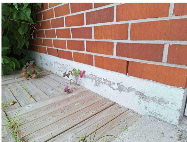
Kuva 21 Perusmuurin pinnoite irtoili, rivitalo
