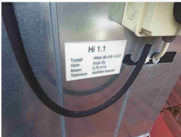
Kuva 162 Poistoimuri
