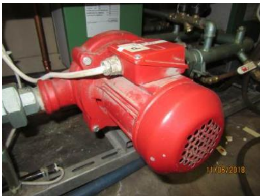
Kuva 54. Lämmitysverkoston kiertovesipumppu
