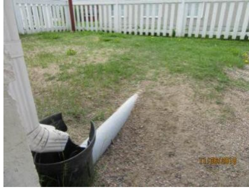
Kuva 75. Rännikaivosta purku maastoon
