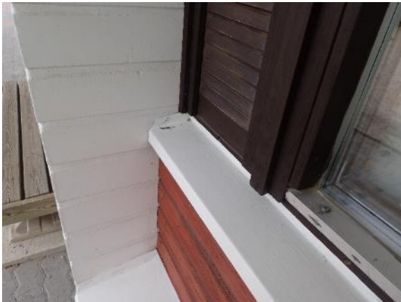
Kuva 29. Vesipeltien kallistukset ovat vähäiset
