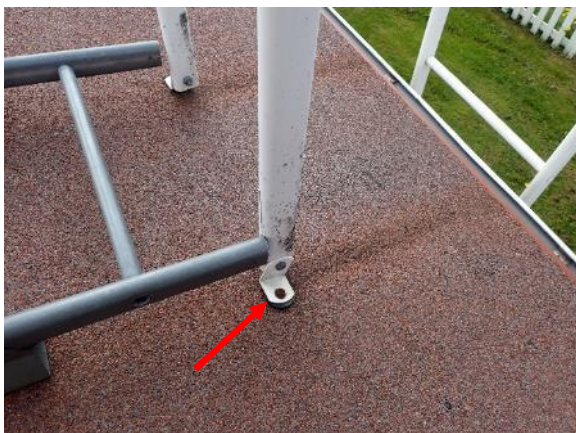
Kuva 41. Talotikkaiden yläpää on kiinnitetty vesikatteen läpi kattorakenteisiin.
