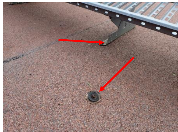
Kuva 42. Kattovarusteet ovat kiinnitetty vesikatteen läpi kattorakenteisiin.
