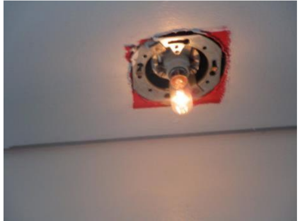
Kuva 104. Poistumistievalaisimia (kupu puuttui).
