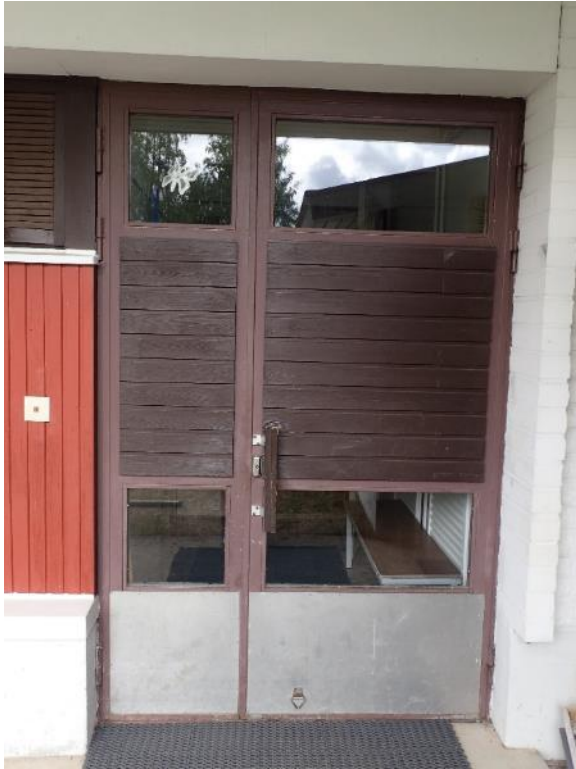
Kuva 31. Yleiskuva metallirunkoisesta ulko-ovesta
