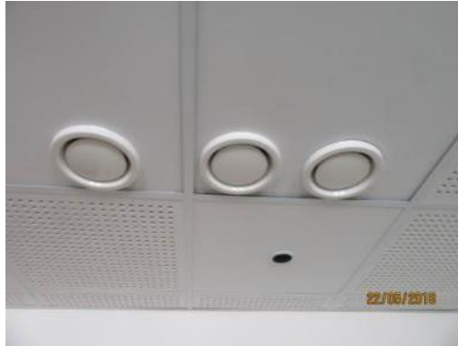
Kuva 83. Poistoilmaventtiilit
