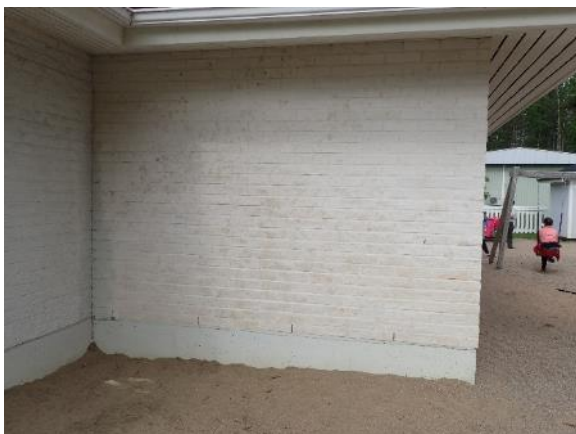
Kuva 24. IV-konehuoneen seinässä on tuuletusraot muurauksen alaosassa
