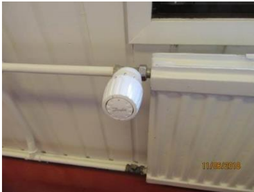
Kuva 56. Patteriventtiili
