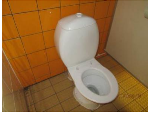
Kuva 67. Lasten wc-istuimen huuhtelupainike on rikki
