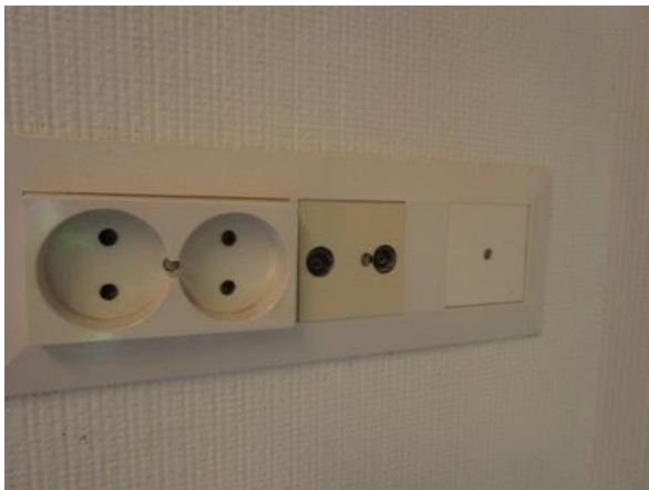
Kuva 97. Maadoittamattomia pistorasioita.
