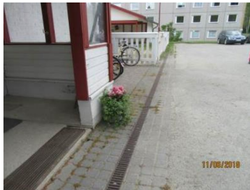
Kuva 77. Aco linjakuivatuskourusta purku maastoon
