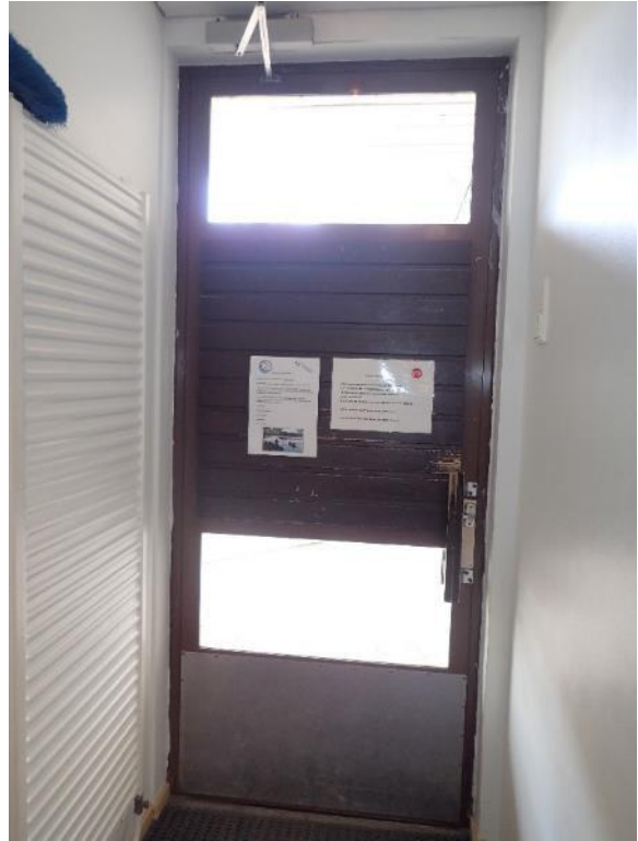
Kuva 32. Yleiskuva metallirunkoisesta ulko-ovesta
