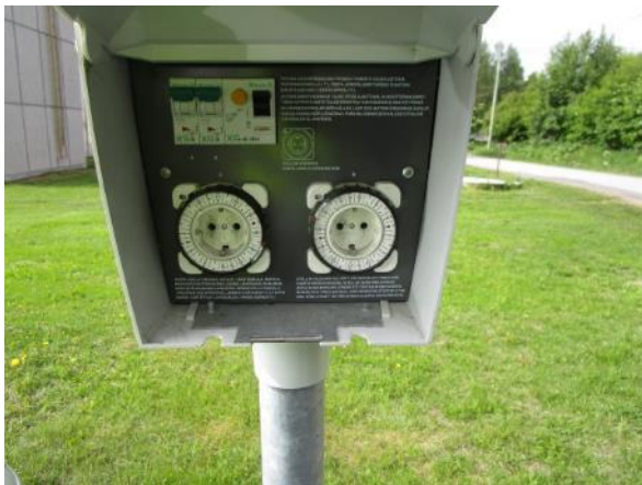
Kuva 92. Julkisivuvalaistusta, kupu pois.
