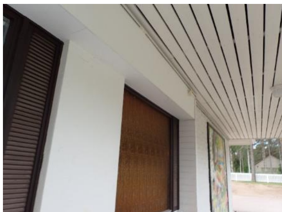
Kuva 26. Rakennusten julkisivuissa on pieniä osia, jotka ovat puuverhottuja, ikkunoiden välit.
