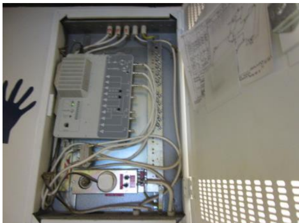
Kuva 105. Antennivahvistin, uusittu.
