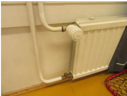
Kuva 58. Patteriventtiili
