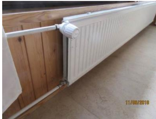
Kuva 57. Patteriventtiili
