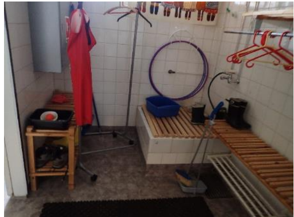
Kuva 51. Osa eteisten lattiapinnoista oli uusittu
