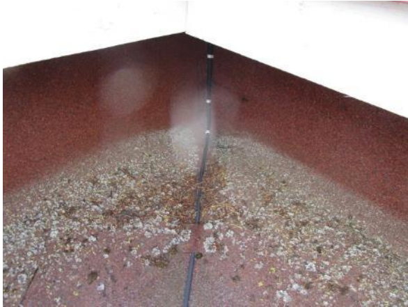
Kuva 102. Näkymä katon sulanapitolämmityksestä.
