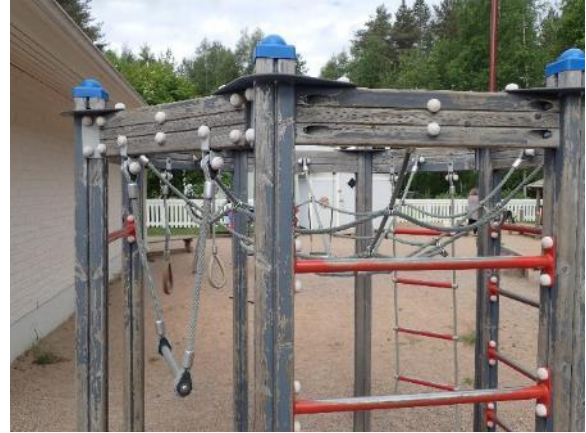
Kuva 10. Maalipinnat ovat kuluneet ja puuosat halkeilleet
