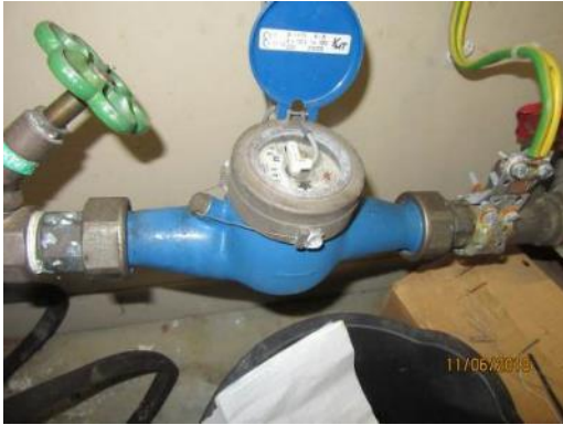
Kuva 60. Vesimittari
