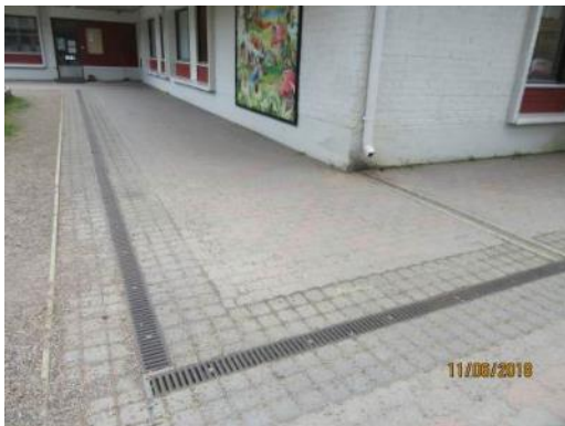
Kuva 76. Aco linjakuivatuskouru
