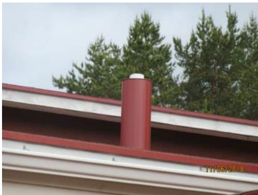
Kuva 70. Tuuletusviemäri katolla
