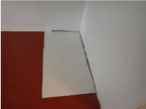
Kuva 46. Huoneen lattiasta puuttuu pala muovimattoa puretun kiintokalusteen alta
