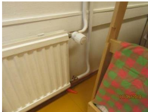
Kuva 59. Patteriventtiili
