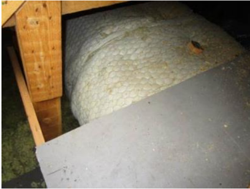
Kuva 82. Kanavaeristykset ovat kunnossa
