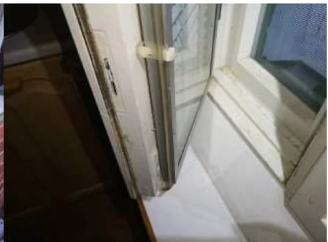
Osaan ikkunoista asennettu 3. lasi jossain vaiheessa
