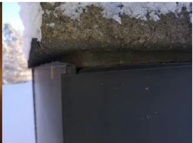
Piipun pellitys ei tiivis yläosasta
