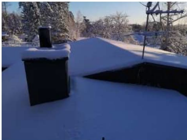
Vesikattoa ei voitu lumen vuoksi tarkastaa
