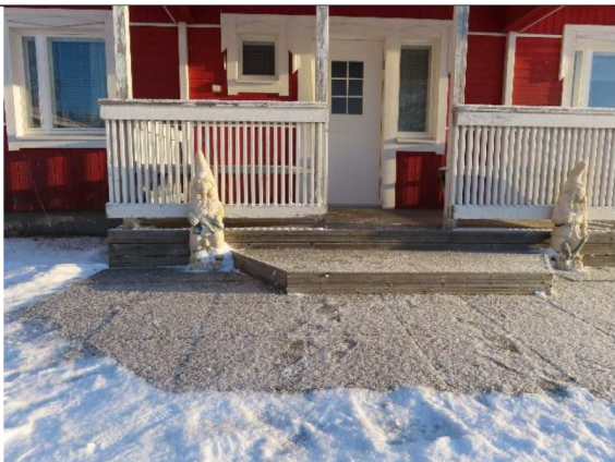
Rakennuksen korkeusasema on hyvä
