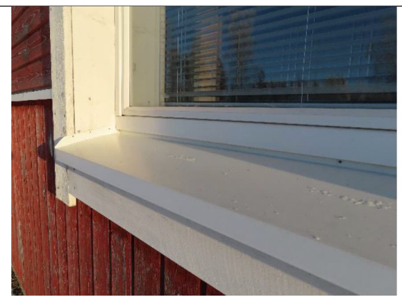
Ikkunat ja ikkunapellitykset ovat kunnossa
