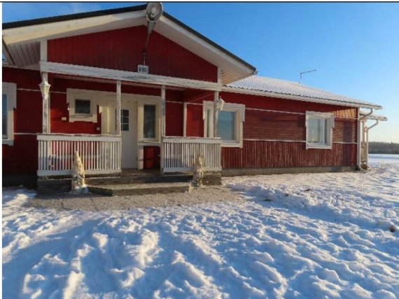
Julkisivut ovat pääosin kunnossa
