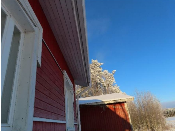
Räystäisen alustoissa on yläpohjaan johtavat tuuletusraot
