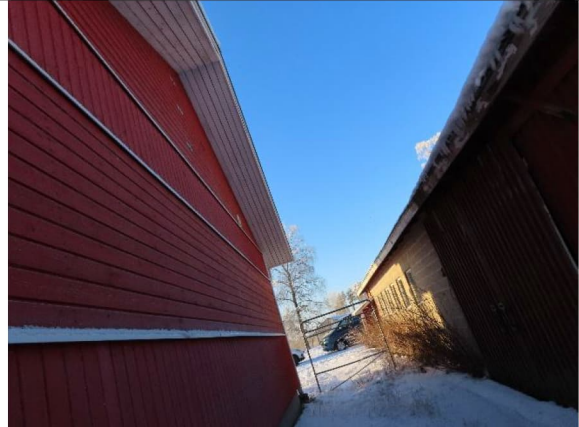
Räystäisen alustoissa on yläpohjaan johtavat tuuletusraot
