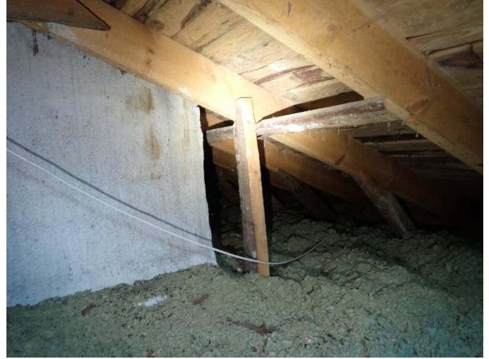
Yläpohjakuvaa. Yläpohjassa ei ole kiinteää kulkusiltaa.
