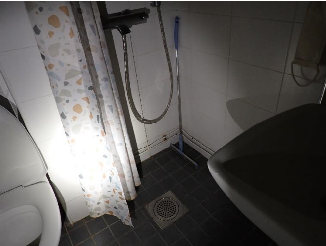
Yläkerran pesuhuoneen pinnat ovat tyydyttävässä kunnossa.
