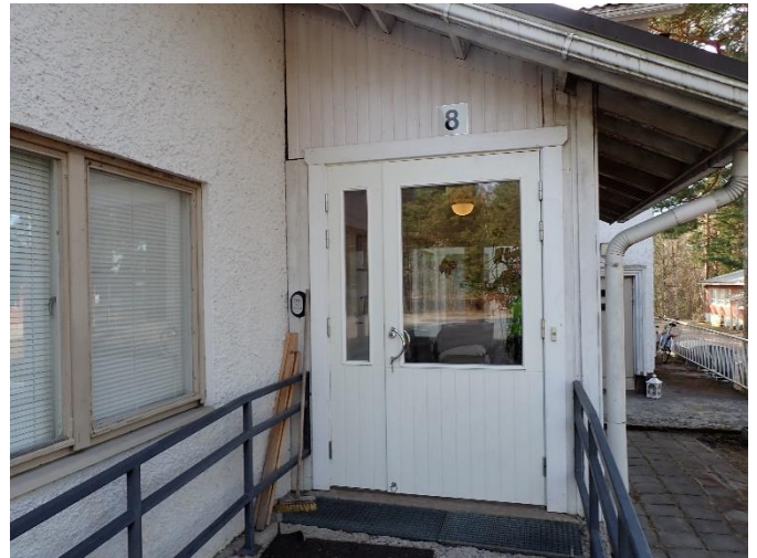
Pääovi on tyydyttävässä kunnossa
