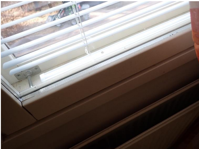
Toimistotilan ikkunat ovat tyydyttävässä kunnossat.
