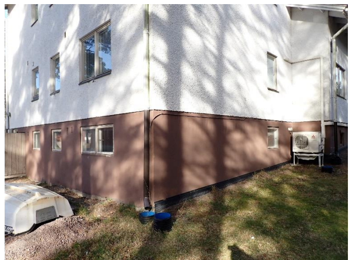
Rakennuksen sokkeliä vasten on asennettu patolevy.
