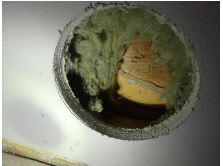
Materiaalinäyte N2 otettiin mineraalivillasta.
