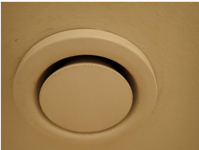
Pesuhuoneen poistoilmanvaihtoventtiili.
