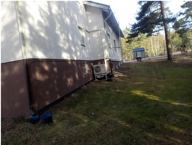
Julkisivun alaosa on betonia.
