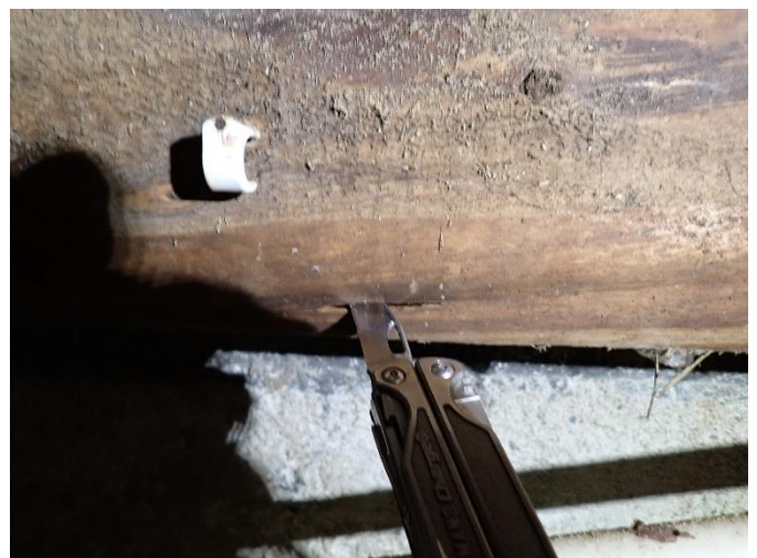
Osa kannatinpalkeista oli lahoja ja puukko upposi usean senttimetrin verran puun sisään kevyesti painaen.
