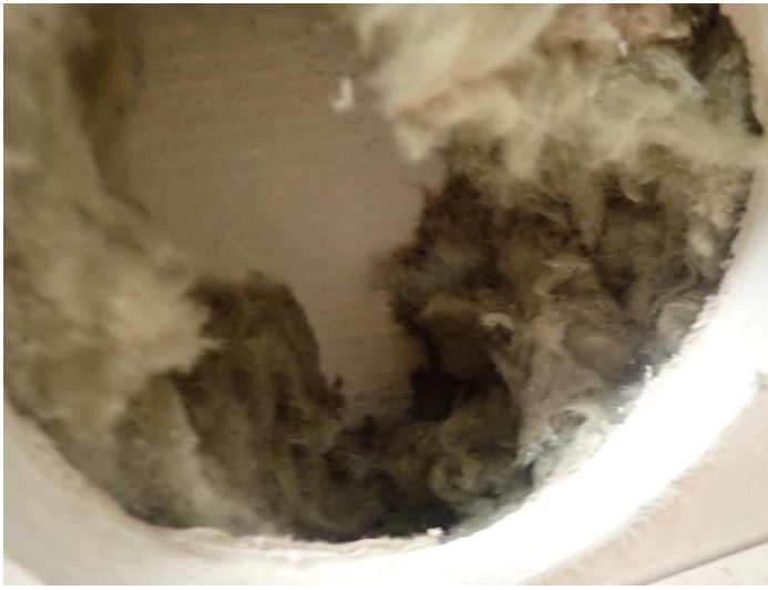
Materiaalinäyte N1 otettiin mineraalivillasta.
