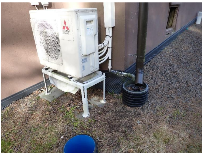
Rännivedet johtetaan pois rakennuksen vierestä.
