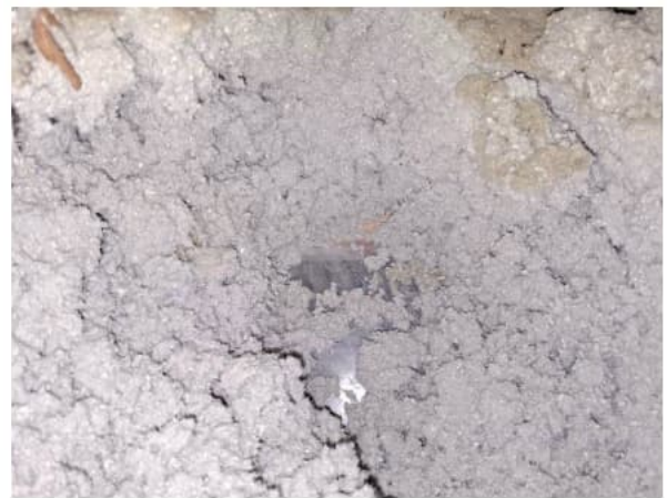
Kuva 18. Villaeristeiden alla on höyrynsulkumuovi.
