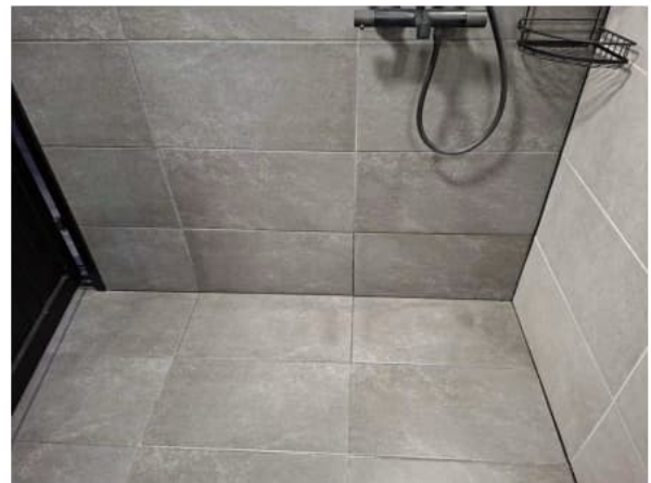
Kuva 41. Märkätilat on remontoitu.
