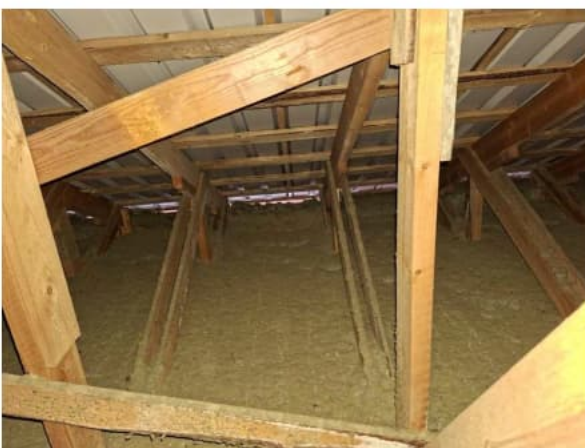
Kuva 13. Tuuletusrako räystäälle on riittävä.
