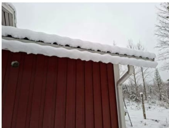
Kuva 39. Kourut ja syöksyt vaikuttavat toimivilta.
