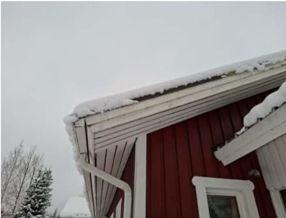
Kuva 22. Valkoiset osat kaipaavat huoltomaalausta.
