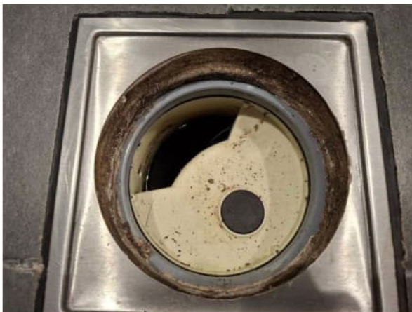
Kuva 40. Suihkun lattiakaivo. Kaivo on alkuperäinen.
