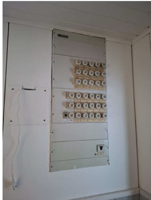
Kuva 54. Sulaketaulu kodinhoitohuoneessa.
