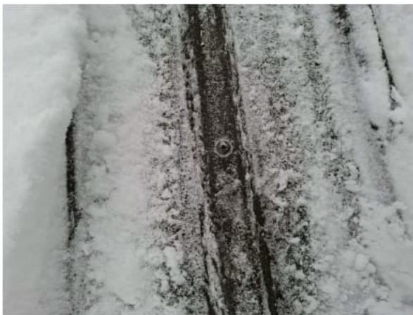
Kuva 3. Peltikate on naulakiinnitteinen.
