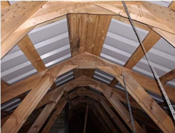
Kuva 15. Aluskatetta ei ole. Puuosat siistikuntoisia.
