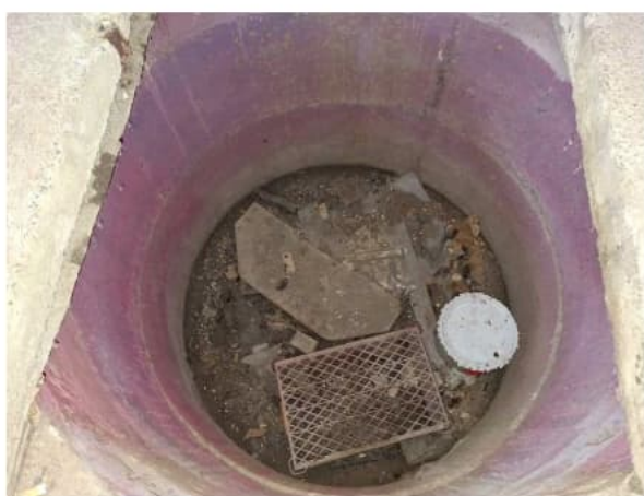
Kuva 30. Kaivonrenkaista tehty "kellari".
