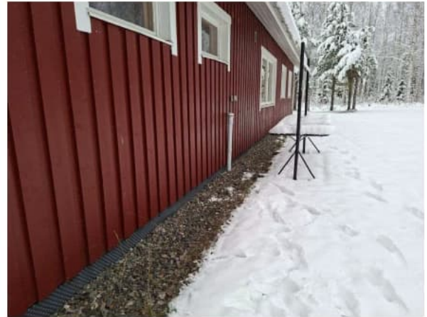
Kuva 23. Sokkelin vierustalla kulkee murskekaista.
