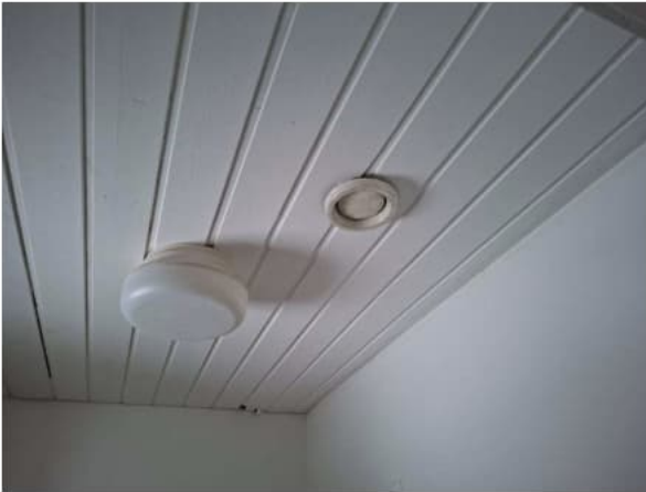
Kuva 46. Poistoilmaventtiili kodinhoitohuoneessa.
