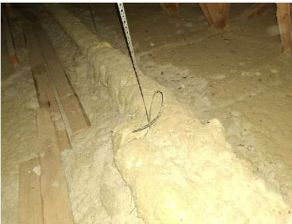
Kuva 11. Ilmanvaihtokanavat on kannakoitu reikänauhalla.
