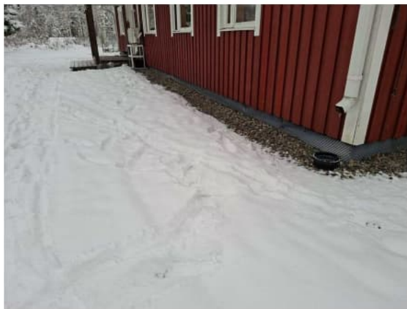
Kuva 28. Maanpinnan muotoja etupihalla.
