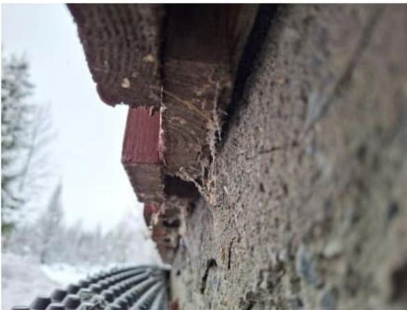
Kuva 26. Julkisivuverhouksella on edellytykset tuulettua.
