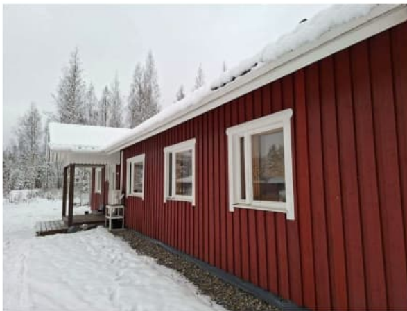
Kuva 20. Julkisivut ovat yleisilmeeltään siistit.
