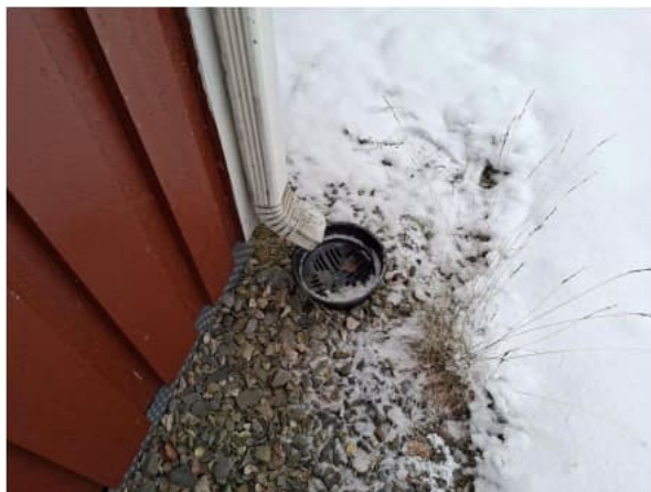
Kuva 37. Kaivo takanurkalla syöksytorven alla.
