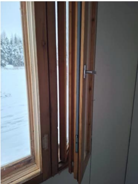
Kuva 34. Ikkunoissa ei havaittu toiminnallisia puutteita.
