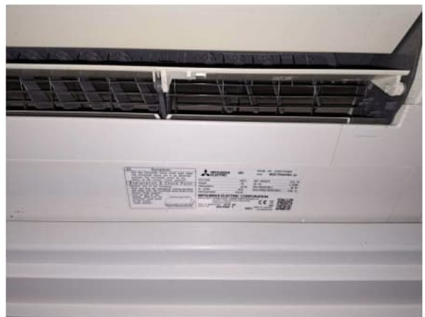
Kuva 56. Ilmalämpöpumpun tyypikilpi.
