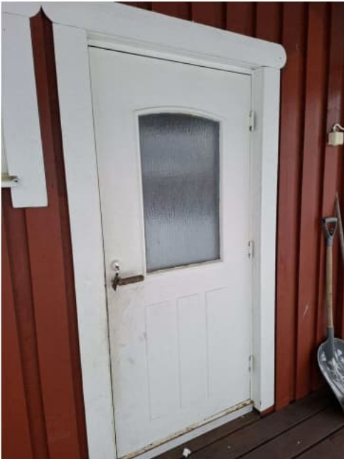
Kuva 32. Pääovi on mahdollisesti joskus uusittu.
