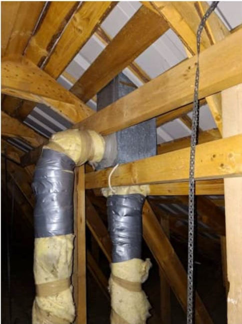
Kuva 9. Eristettyjä poistokanavia.
