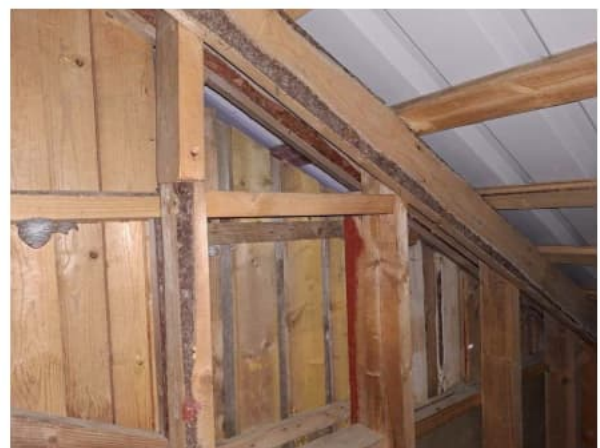
Kuva 14. Harjan osuus tuulettuu päätyräystäiden kautta.
