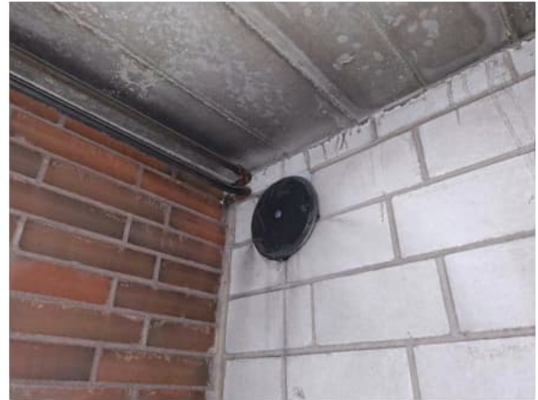
Kuva 47. Korvausilmaventtiili kattilahuoneessa.
