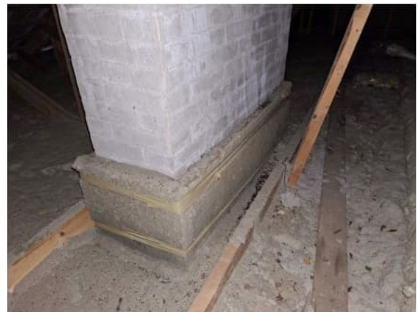
Kuva 12. Savuhormi on erotettu palovillakaistalla selluvillaeristeestä.
