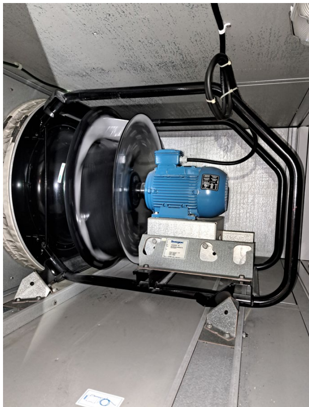
Kuva 12. TK01 Puhallinkammio ja puhallin. Ei huomattavaa irtopölyä tai likaa.
