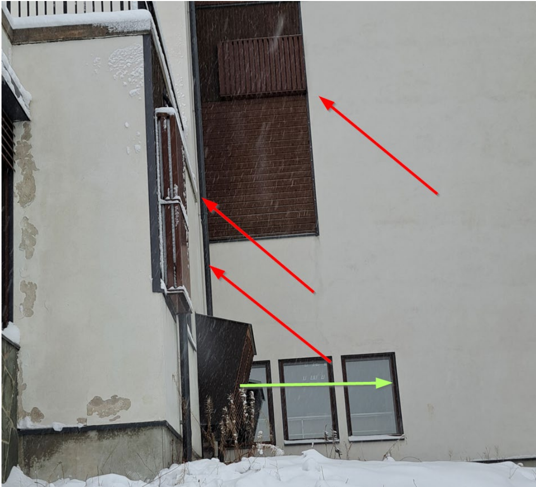
Kuva 18. Poistoilmasäleikön (vihreä) sijainti raitisilmalaitteisiin (punainen) nähden.
