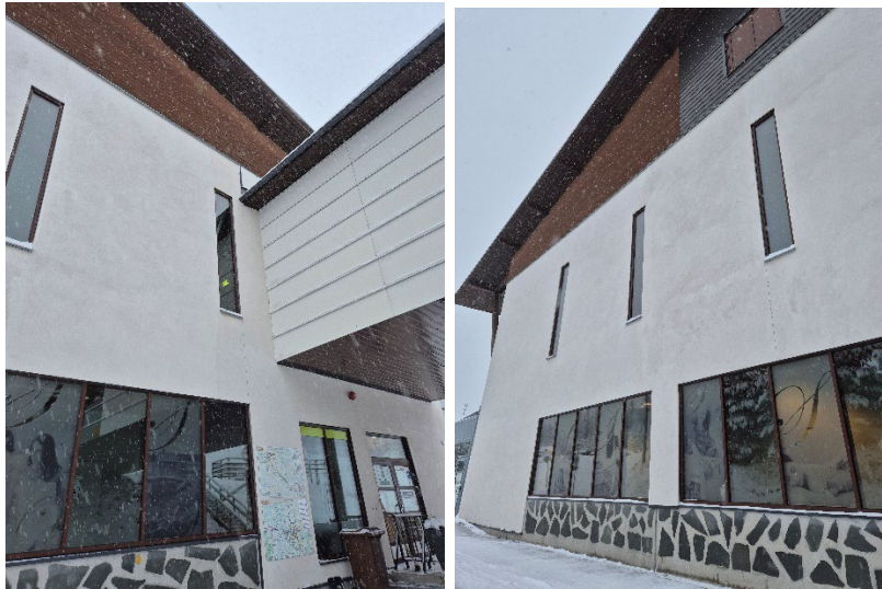
Kunnossa olevia julkisivupintoja
