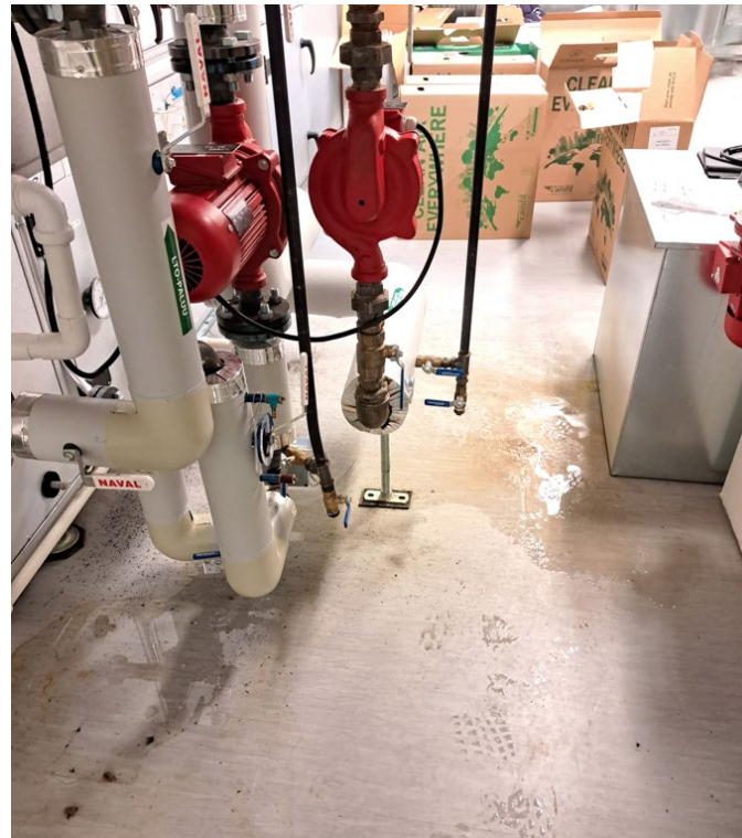
Kuva 6. Vettä lattialla TK04:n edessä
