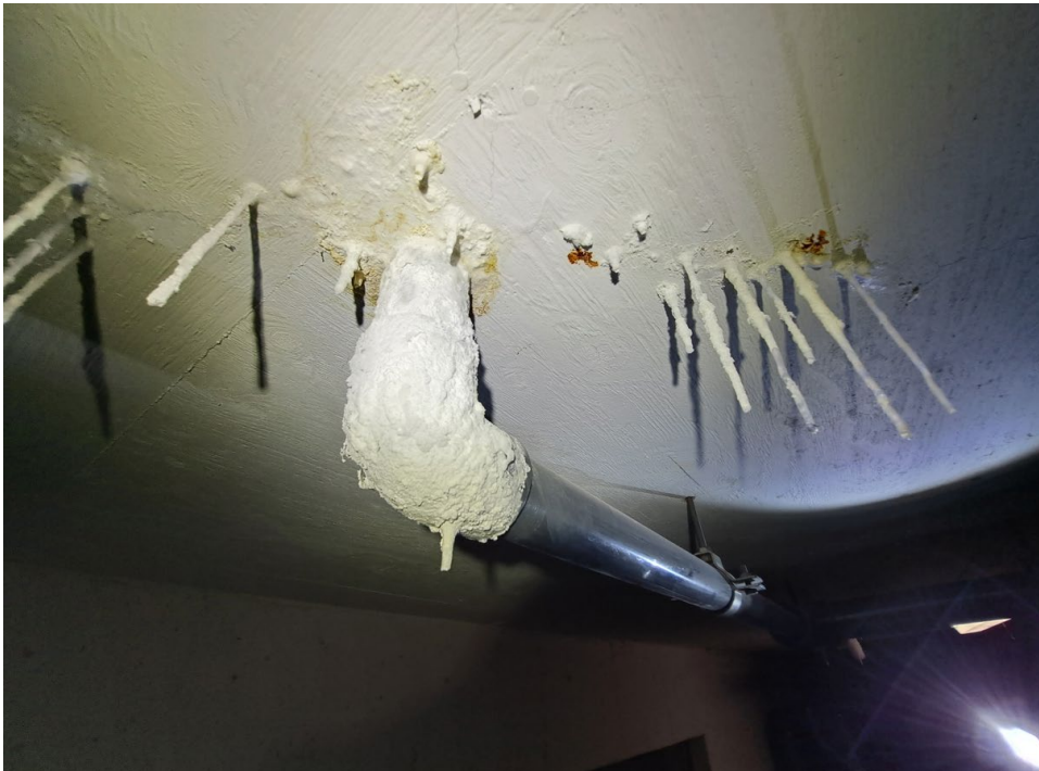
Kuva 20. Altaan pohjan läpivienti
