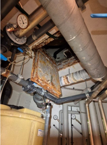
Porealtaan pohjan suuttimen vuodon aiheuttama vesivahinko ja kemikaalihuoneen vieressä putkien vuotoa
