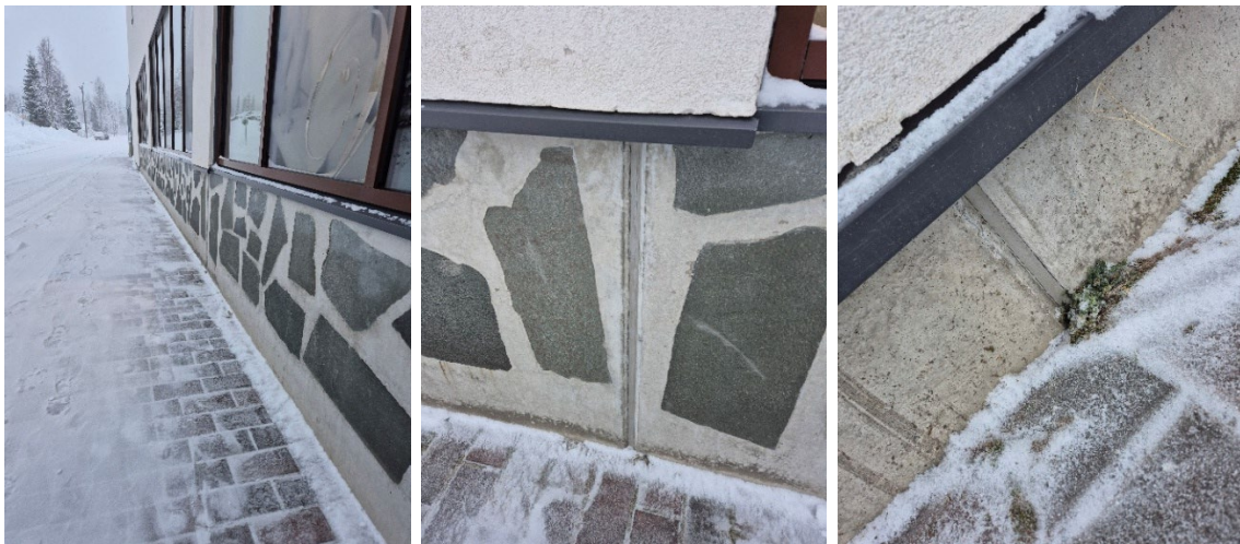
Sokkelin pintaa ja elementtisaumauksia
