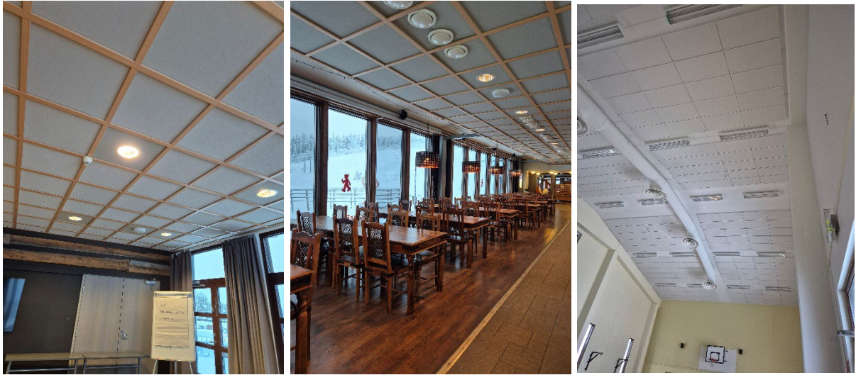
Toisen kerroksen yläpohjarakennetta alapuolisesti tarkasteltuna
