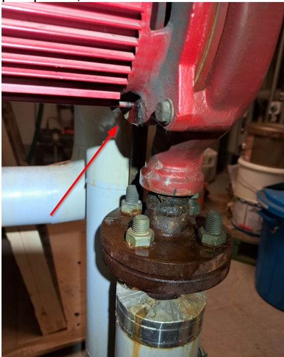
Kuva 4. TK01 PU50, pieni vuoto
