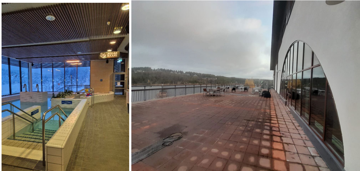
Käännetty kattorakenne sisätiloista päin ja yleiskuva käännetyn kattorakenteen yläpuoleiselta terassilta
