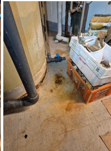
Porealtaan pohjan suuttimen vuodon aiheuttama vesivahinko ja kemikaalihuoneen vieressä putkien vuotoa
