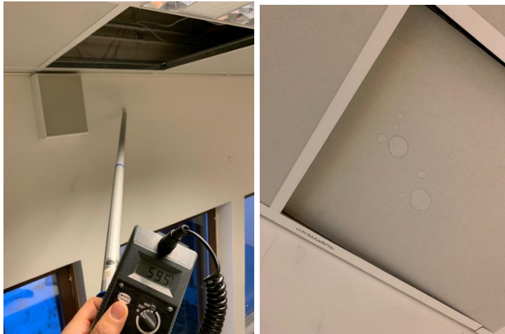
Huone 126 ulkoseinälinja ja sulkuventtiilin kohta
