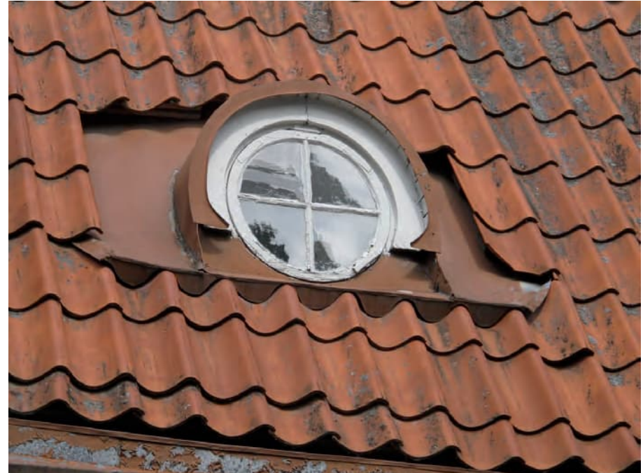
Alkuperäinen kattolapteen ikkuna.
