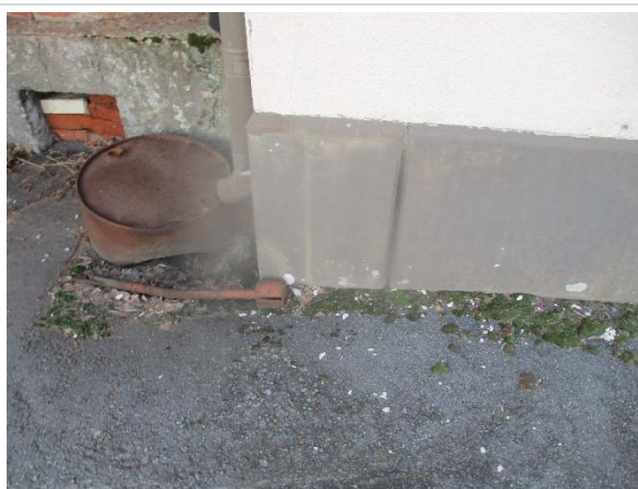
Sockel av betongelement på tillbyggda delen
