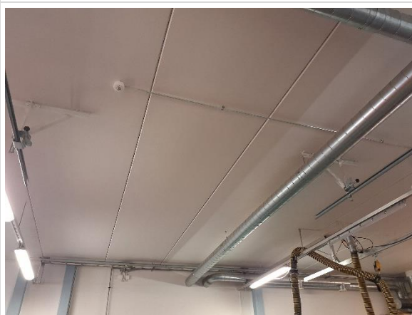
Övre bjälklag av håldäcksplattor
