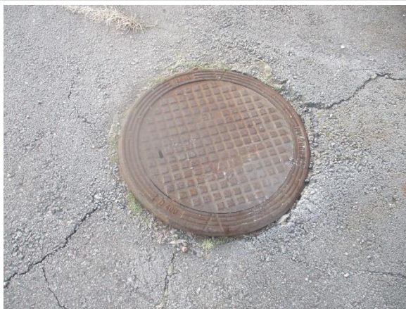
Kontrollbrunn för dränering, fastfrusen
