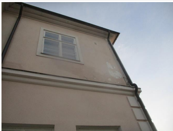
Hängrännor och stuprör förnyade
