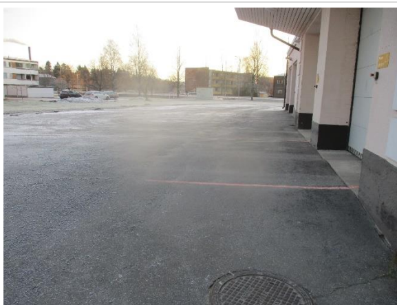
Byggnadens östra sida, ok marklutning
