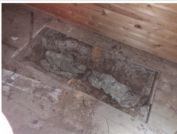
Övre bjälklagets isolering
