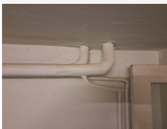
Asbestisolering
