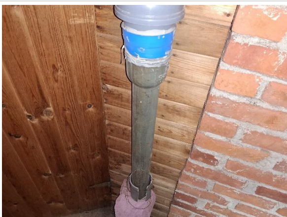
Oisolerat avloppsrör
