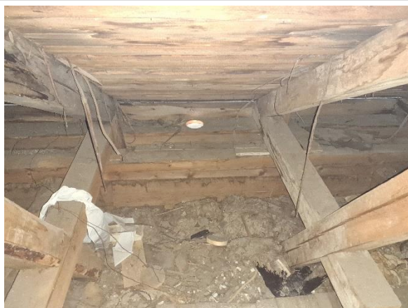
Ventilering via hål i utskift
