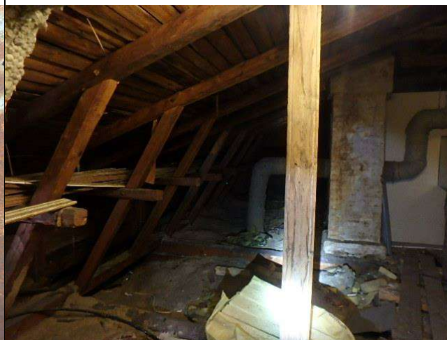
Kuva 27 Kaskenkadun suuntaisen rakennuksen yläpohjatilaa.
