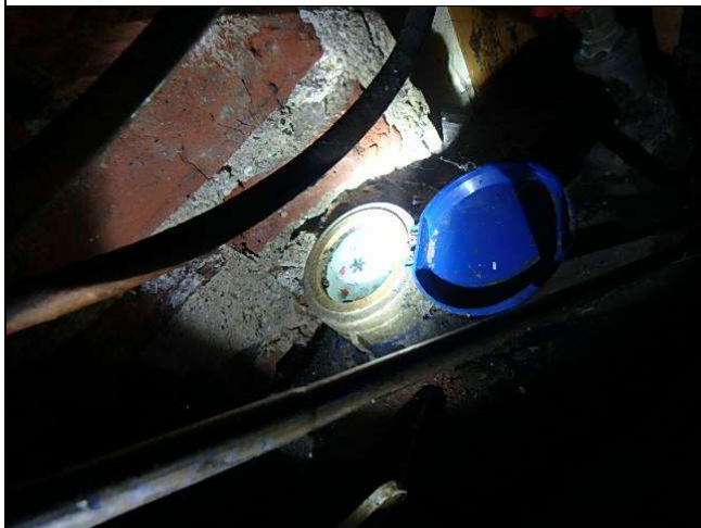
Kuva 60 Vesimittari baaritiskin kaapissa.
