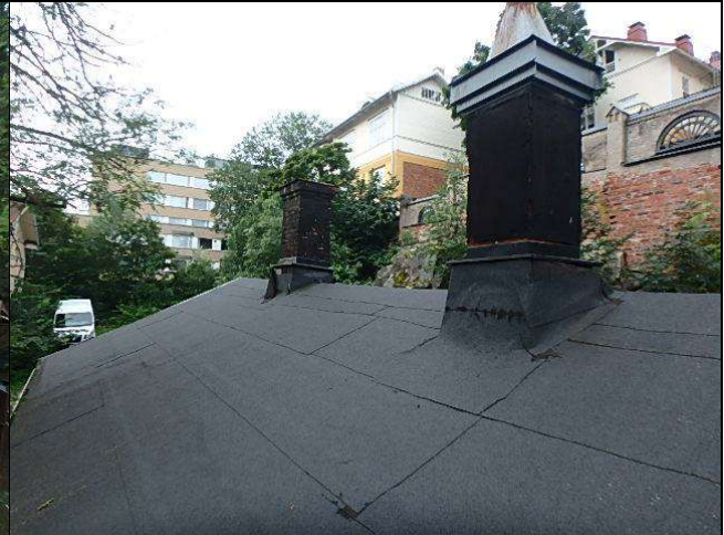
Kuva 19 Asuinkäytössä olevan L-mallisen rakennuksen savupiippujen juurissa ei pellityksiä. Huoppien liitokset piippujen juurissa eivät vaikuttaneet tiiviiltä.
