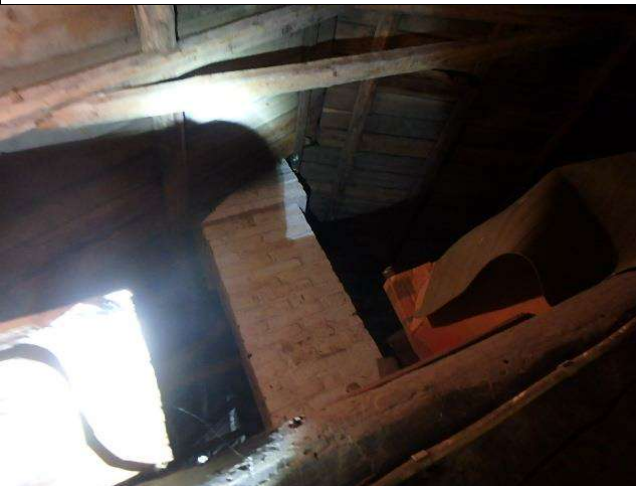
Kuva 20 L-mallisen rakennuksen yläpohjaa luukulta kuvattuna. Asuinosan yläpohjarakenteista ei havaittu vaurioita.
