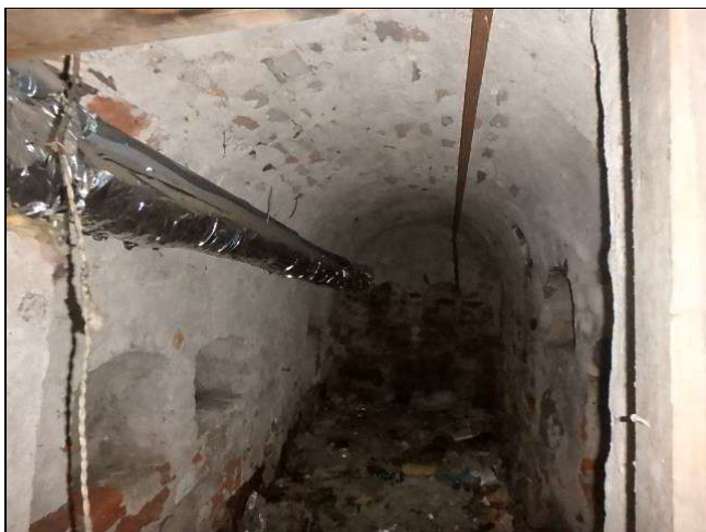
Kuva 56 L-mallisen rakennuksen kellarissa eristettyjä/ uusittuja putkirakenteita
