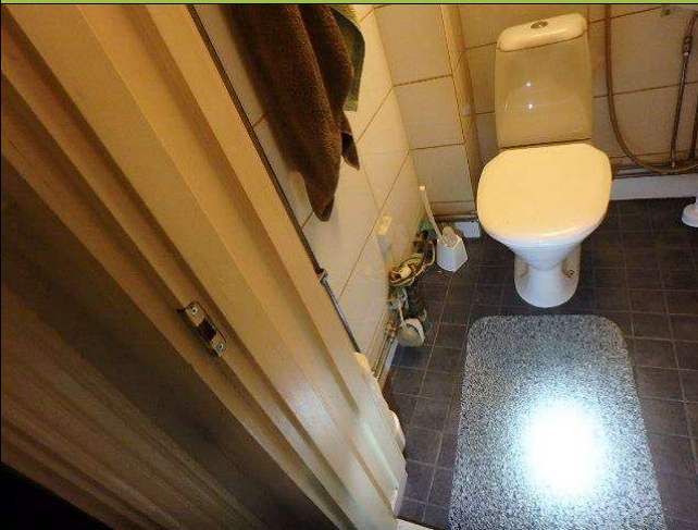
Kuva 30 Wc suihkuhuoneen yhteydessä
