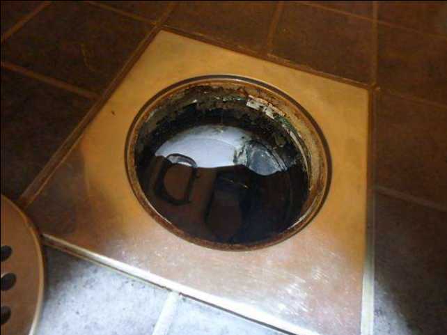
Kuva 32. Suihkun edustan lattiakaivo.
