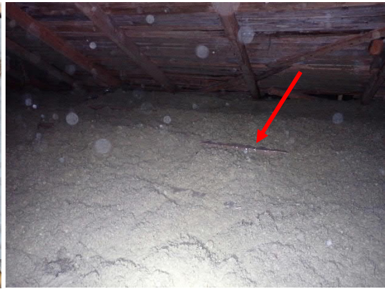
Kuvat 54. ja 55. Yläpohjatilaa. Puhallusvillan alla havaittiin muovi.
