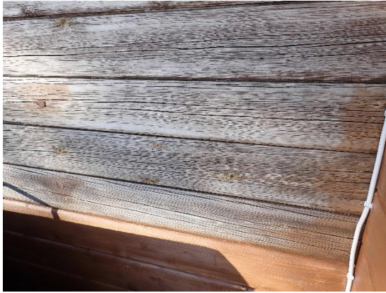
Kuvat 38. Saunarakennuksen hirsipinnassa havaittiin halkeilua, erityisesti takapäädyssä.
