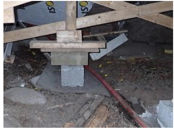
Kuvat 12 ja 13. Ryömintätilaa. Alapohjarakenteen puurakenteet ovat osin kosketuksissa suoraan betonirakenteisiin / maapohjaan.
