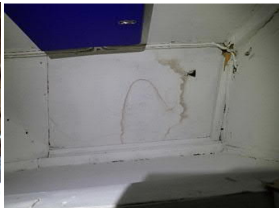
Kuvat 58. ja 59. 2. kerroksen sisäkattopinnoissa havaittiin kosteusjälkiä.
