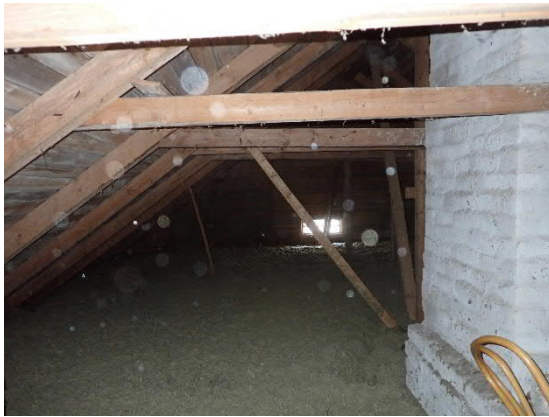
Kuvat 54. ja 55. Yläpohjatilaa. Puhallusvillan alla havaittiin muovi.
