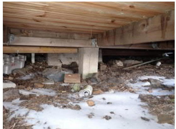
Kuvat 18 ja 19. Saunarakennuksen lattian alapuolinen ryömintätila on avoin reunoilta.
