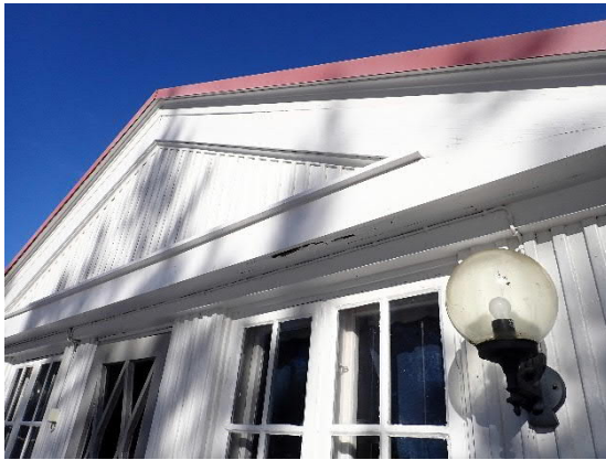
Kuvat 50. ja 51. Parvekkeen kohdalla räystäällä havaittiin puurakenteissa kosteusvaurioita.
