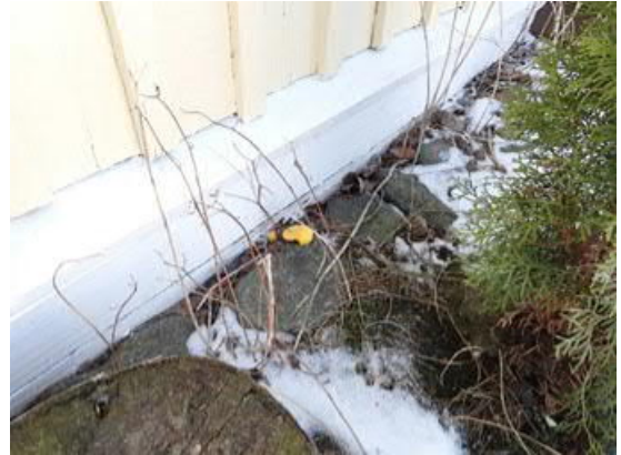
Kuva 26. Ulkoseinän alaosassa oleva vaakalista on tasainen ja siihen kertyy helposti lunta.
