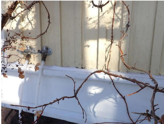
Kuva 28. Vesipisteiden kohdalla ulkoseinän alaosan puurakenteissa havaittiin pehmenemistä.
