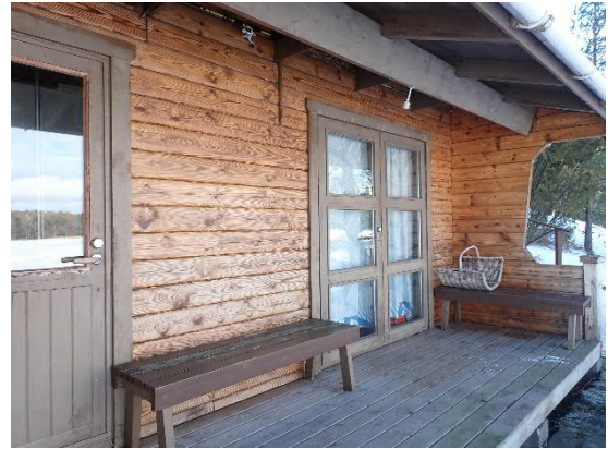
Kuva 40. Ikkunoissa havaittiin kunnostustarvetta (saunarakennus).
