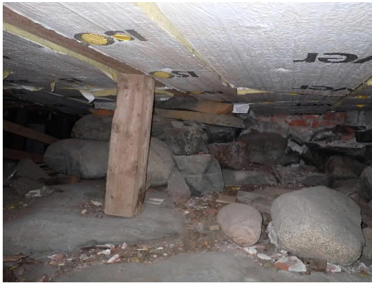
Kuvat 14 ja 15. Alapohjarakenteen tuentoja.
