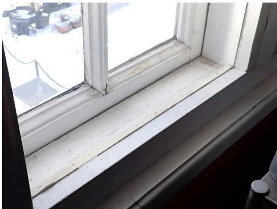
Kuvat 30 ja 31. Sisäpinnoilta ikkunat olivat monin paikoin vielä hyväkuntoisia, muutamasta kohdasta maalipinnoite irtailli.
