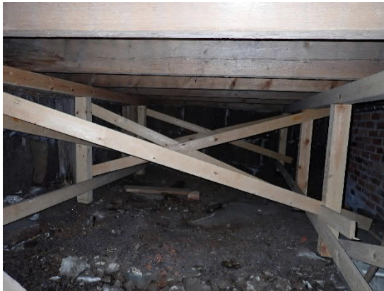
Kuvat 16 ja 17. Ryömintätilaa takasivun kuistin alla, kosteusvaurioita puurakenteissa.
