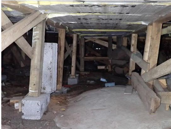
Kuvat 12 ja 13. Ryömintätilaa. Alapohjarakenteen puurakenteet ovat osin kosketuksissa suoraan betonirakenteisiin / maapohjaan.
