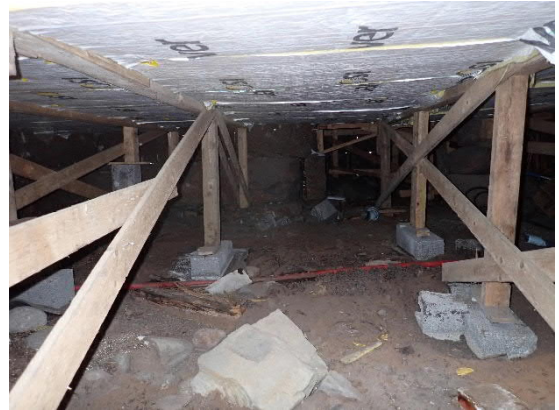
Kuvat 12 ja 13. Ryömintätilaa. Alapohjarakenteen puurakenteet ovat osin kosketuksissa suoraan betonirakenteisiin / maapohjaan.
