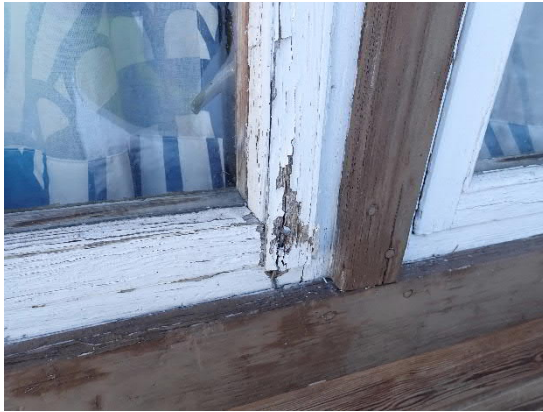
Kuva 40. Ikkunoissa havaittiin kunnostustarvetta (saunarakennus).
