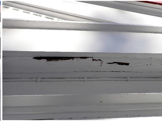
Kuvat 50. ja 51. Parvekkeen kohdalla räystäällä havaittiin puurakenteissa kosteusvaurioita.
