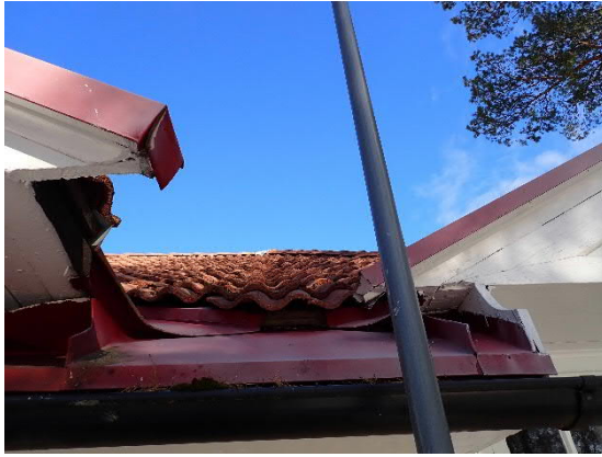
Kuvat 48. ja 49. Päärakennuksen vesikattoa ja kattolyhty, jonka puurakenteissa havaittiin haristumista.
