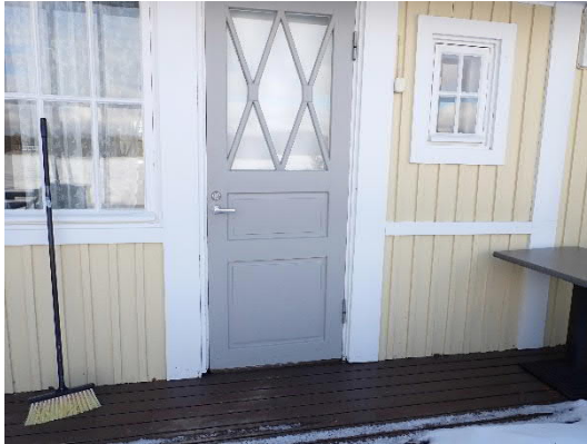
Kuvat 32 ja 33. Ulko-ovet olivat pääsääntöisesti kunnossa. Etupäädyn ulko-oven alaosassa havaittiin haristumista ja pinnoitteissa kulumista.
