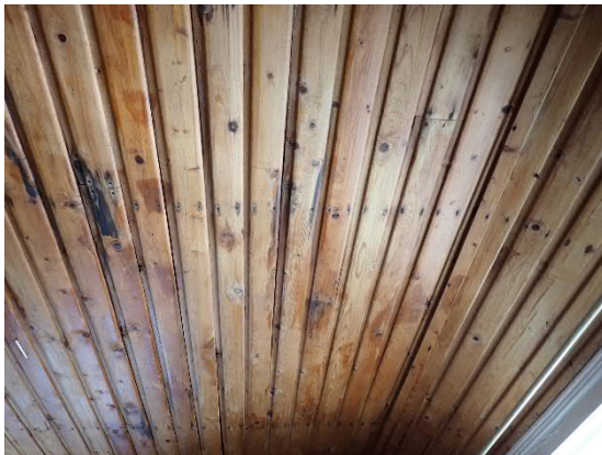
Kuvat 58. ja 59. 2. kerroksen sisäkattopinnoissa havaittiin kosteusjälkiä.
