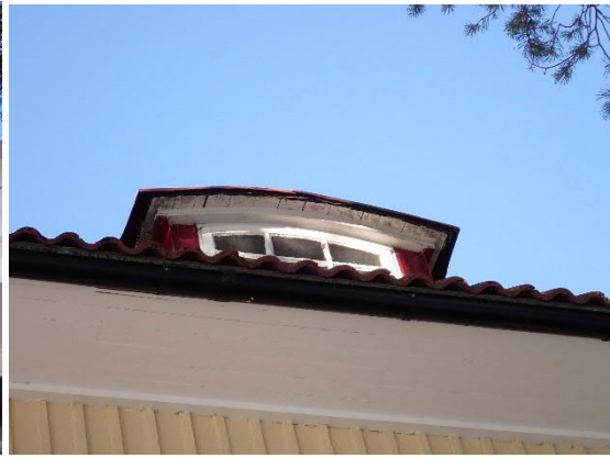
Kuvat 48. ja 49. Päärakennuksen vesikattoa ja kattolyhty, jonka puurakenteissa havaittiin haristumista.
