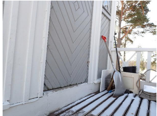
Kuvat 32 ja 33. Ulko-ovet olivat pääsääntöisesti kunnossa. Etupäädyn ulko-oven alaosassa havaittiin haristumista ja pinnoitteissa kulumista.
