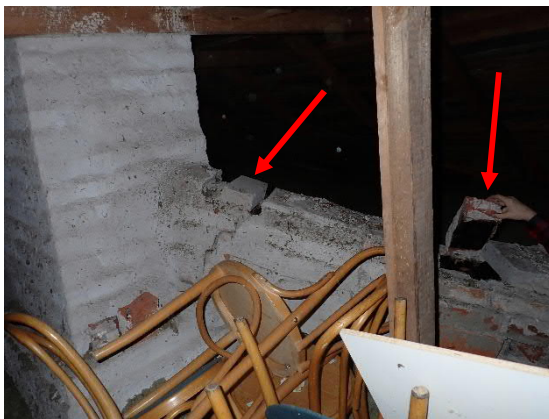
Kuva 56. Hormin sivuhaaran tiilet olivat osin irti.
