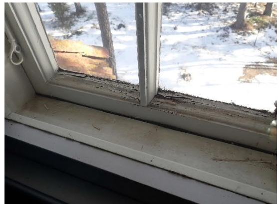
Kuvat 30 ja 31. Sisäpinnoilta ikkunat olivat monin paikoin vielä hyväkuntoisia, muutamasta kohdasta maalipinnoite irtailli.
