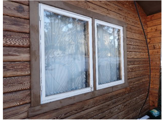
Kuvat 38. Saunarakennuksen hirsipinnassa havaittiin halkeilua, erityisesti takapäädyssä.
