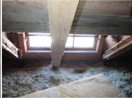
Kuvat 50. ja 51. Parvekkeen kohdalla räystäällä havaittiin puurakenteissa kosteusvaurioita.
