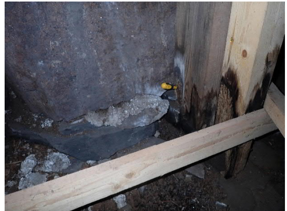
Kuvat 16 ja 17. Ryömintätilaa takasivun kuistin alla, kosteusvaurioita puurakenteissa.
