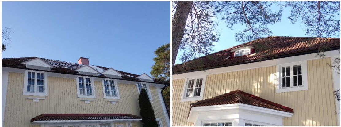
Kuvat 44 ja 45. Päärakennuksen vesikattoa.
