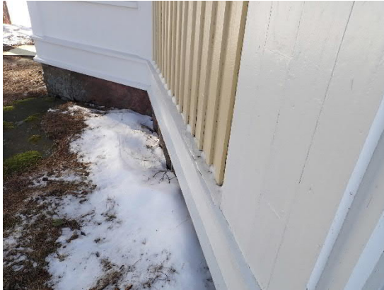
Kuva 26. Ulkoseinän alaosassa oleva vaakalista on tasainen ja siihen kertyy helposti lunta.
