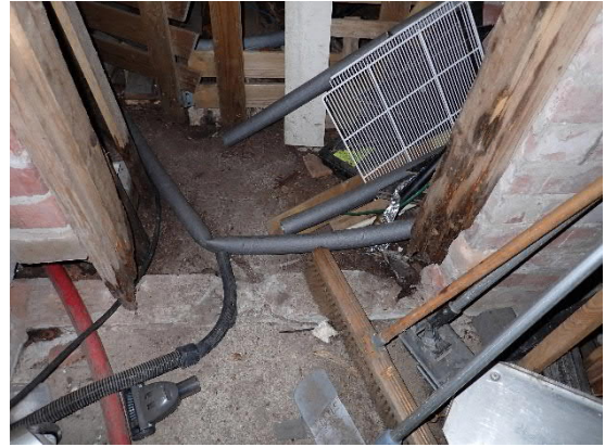
Kuva 9. Kellaritilojen lattia on betonirakenteinen. Seinät ovat tiiltä. Puurakenteissa havaittiin vaurioviitteitä.
