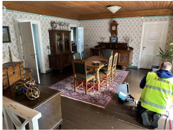
Kuva 10 ja 11. 2.kerroksen ruskea lattiamaali sisältää raskasmalleja.
