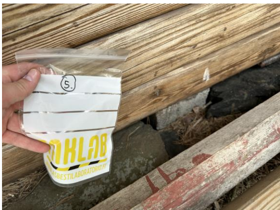
Kuva 5 ja 6. Saunarakennuksen perustuspilariharkkojen sekä alajuoksun välinen huopa sisältää asbestia.
