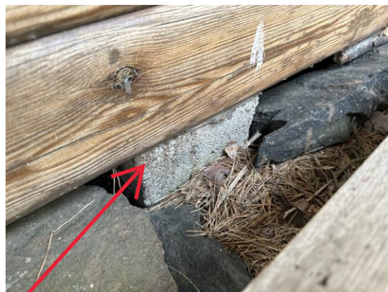
Kuva 5 ja 6. Saunarakennuksen perustuspilariharkkojen sekä alajuoksun välinen huopa sisältää asbestia.
