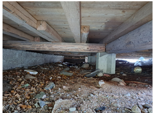
10. Tallituvan alapohjarakenteita.
