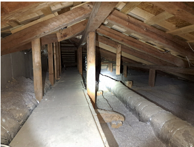
71. Yläpohjatilaa ison ravintolasalin kohdalla
