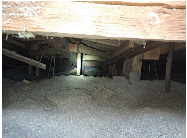
70. Yläpohjatilaa keittiön kohdalla
