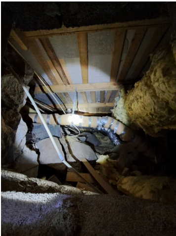
15. Ryömintätilaa keittiön kohdalla
