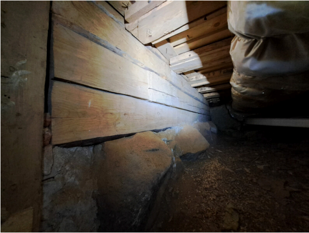
21. Hirsirakennetta väliseinän kohdalla
