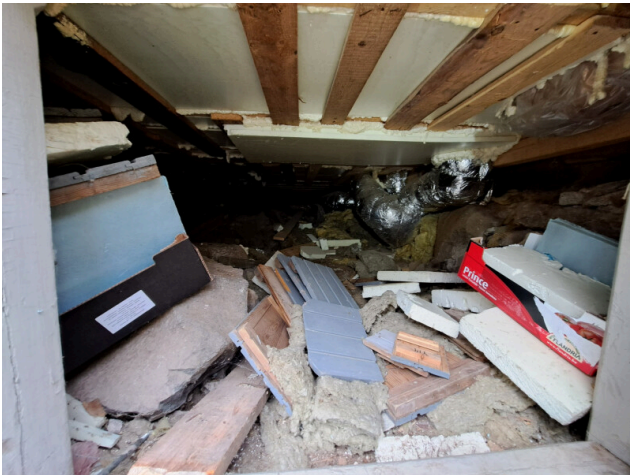
9. Ryömintätilaa kaakkoispäädyssä olevan verannan kohdalla
