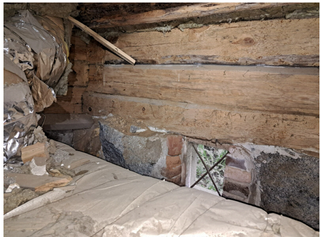
20. Ulkoseinän alimpia hirsikertoja
