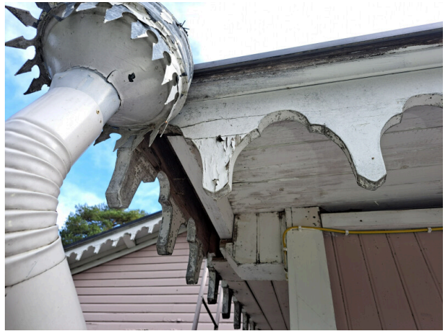
45. Lahovauriota räystään koristelaudoituksissa
