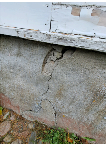
1. Sokkelin betonirappausta
