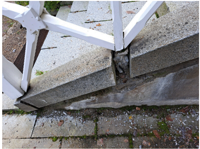
4. Portaan reunuskivet liikkuneet pois paikaltaan ja portaan kaiteen alaosissa lahoa
