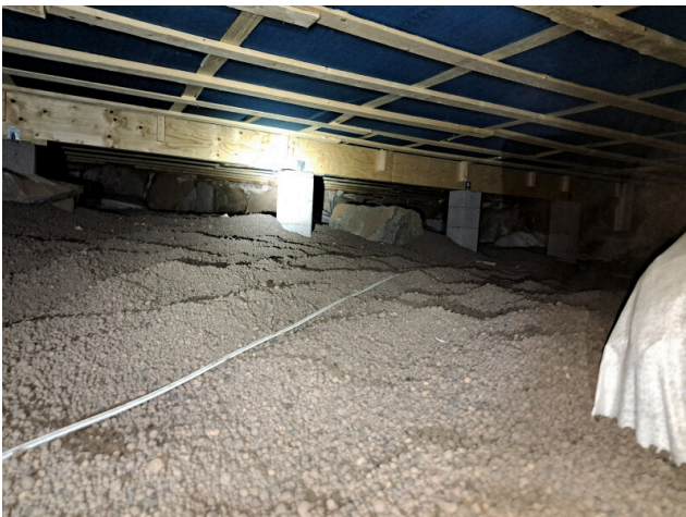
13. Ryömintätilaa pienen ravintolasalin kohdalla
