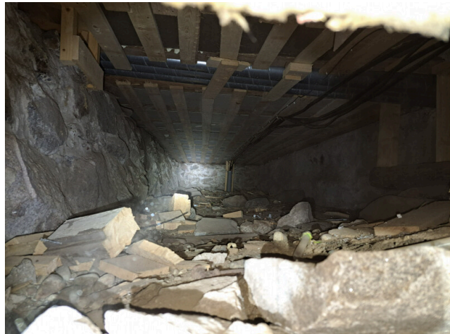
10. Ryömintätilaa kaakkoispäädyssä olevan verannan kohdalla
