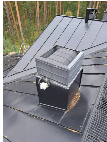
169. Keittiön poistoilmapuhallin
