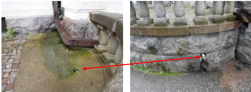
Kuvat 1 ja 2. Terassilta (kuva 1) vedet johdetaan viemäriputkella ulos (kuva 2).
