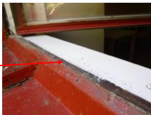
Kuvat 27 ja 28. Kuvassa näkyy ikkunan ja vesikaton liitos yläkerrassa. Liitos näyttää epätiiviiltä.
