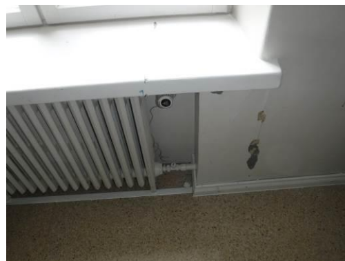
Kuvat 71 ja 72. Lisäeristys havaittiin, koska eristetyissä huoneissa ikkunapenkki jää seinälinjan sisäpuolelle.
