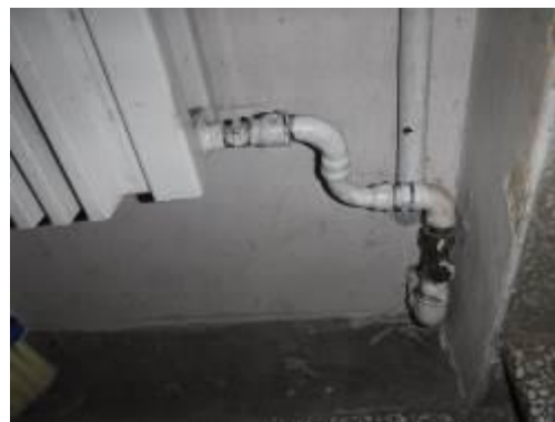
Kuvat 83 ja 84. Vesipatterit ja lämmitysputket ovat valurautaa.
