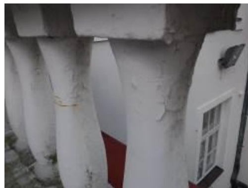
Kuva 14 ja 15. Yläterassilla rappauksen maalipinta on huonossa kunnossa.
