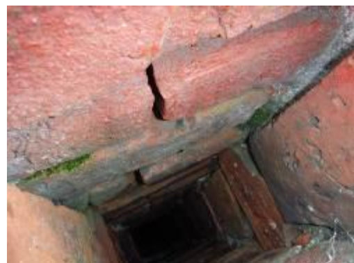
Kuvat 93 ja 94. Sadehattu puuttuu ja hormi on yläpäästään rapautunut.
