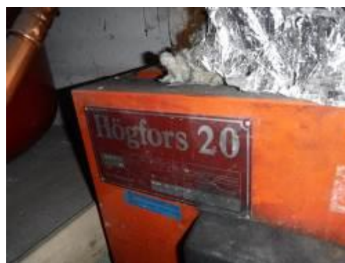
Kuvat 80 ja 81. Lämmönjakohuoneessa on kaksi öljykattilaa, joista toinen oli tarkastushetkellä käytössä.
