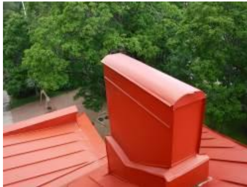
Kuva 90. Hormisto on yläpäästään pellitetty umpeen.
