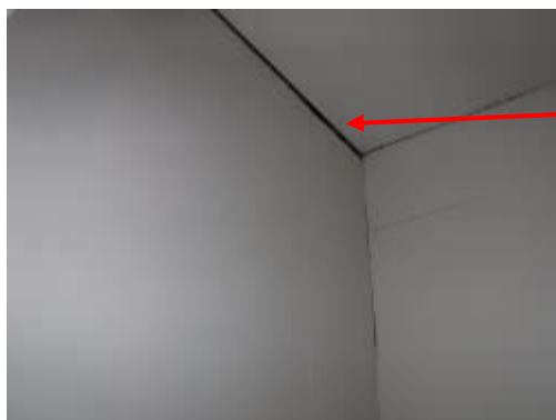
Kuvat 73, 74 ja 75. Ilmavuotoja rakenteiden liittymäkohdista
