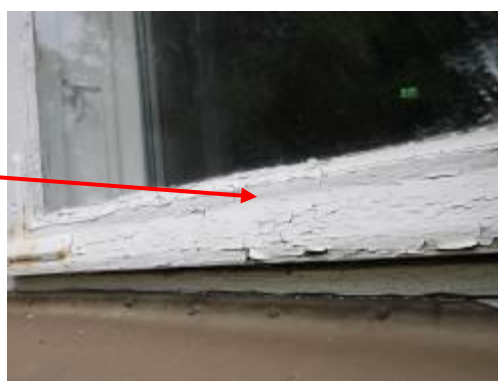
Kuva 25 ja 26. Ikkunapokien ja -karmien maalipinta on huonossa kunnossa
