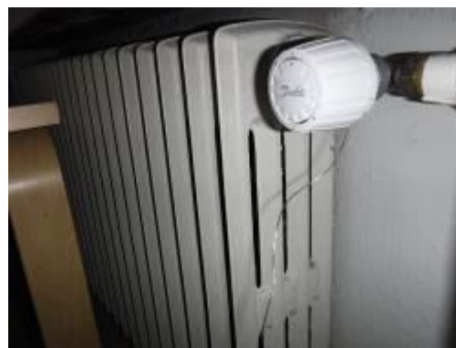
Kuvat 85 ja 86. Termostaattien lämpötila-anturit ovat lattialla kiinnittämättä.
