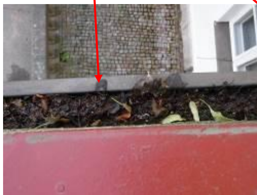
Kuvat 42, 43 ja 44. Sadevesikouruun on lammikoitunut vettä.
