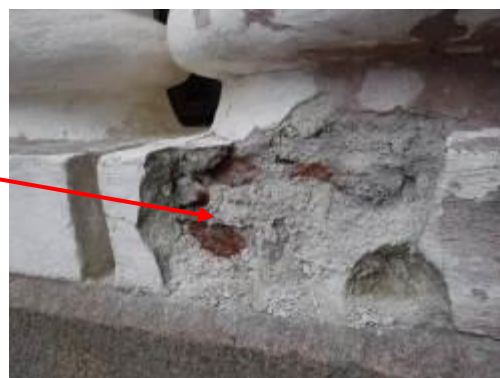
Kuvat 19 ja 20. Pylvään alapään rappaus on lohjennut pääoven vieressä.
