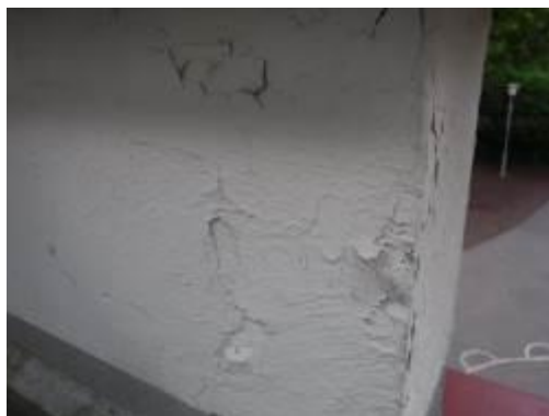
Kuva 14 ja 15. Yläterassilla rappauksen maalipinta on huonossa kunnossa.
