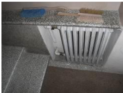
Kuvat 83 ja 84. Vesipatterit ja lämmitysputket ovat valurautaa.
