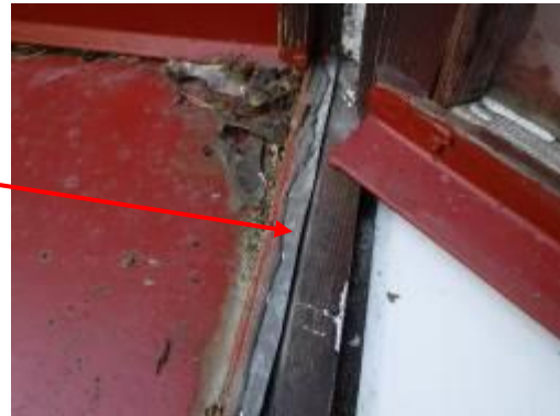
Kuvat 29 ja 30. Kuvassa näkyy ikkunan ja vesikaton liitos yläkerrassa. Liitos vaikuttaa epätiiviiltä.
