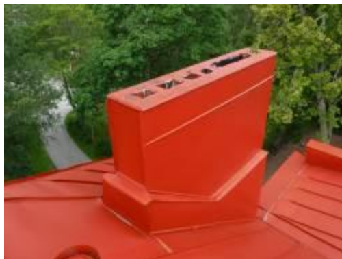
Kuvat 91 ja 92. Sadehattu puuttuu
