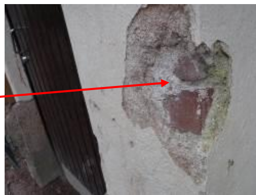
Kuva 16 ja 17. Rappaus on lohjennut pohjoispäädyn sisäänkäynnin kohdalla.
