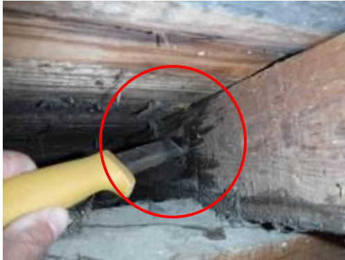
Kuvat 46 ja 47. Vanhoja kosteusjälkiä vesikaton kantavissa puurakenteissa.
