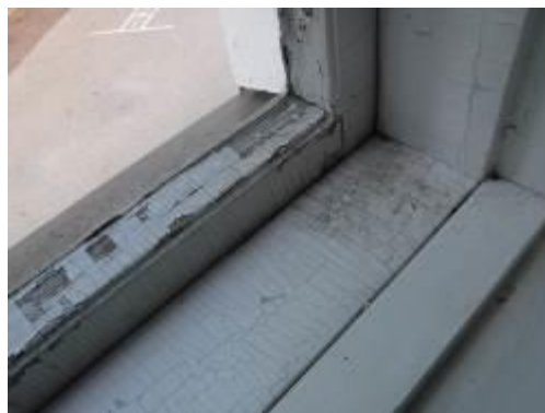
Kuva 23 ja 24. Ikkunapokien ja -karmien maalipinta hilseilee.
