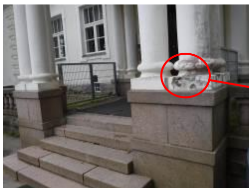
Kuvat 19 ja 20. Pylvään alapään rappaus on lohjennut pääoven vieressä.
