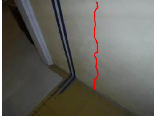
Kuvat 56 ja 57. Halkeamia kellarikerroksen seinissä
