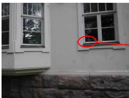
Kuva 25 ja 26. Ikkunapokien ja -karmien maalipinta on huonossa kunnossa
