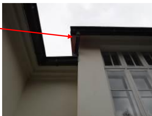
Kuva 40 ja 41. Syöksytorvi on ruostunut puhki ja tiputtaa vettä.
