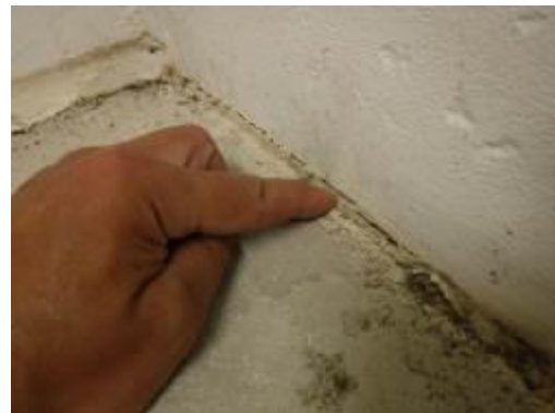
Kuvat 58 ja 59. Ilmavuotokohta alapohjan ja ulkoseinän liittymästä.
