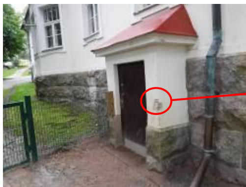
Kuva 16 ja 17. Rappaus on lohjennut pohjoispäädyn sisäänkäynnin kohdalla.
