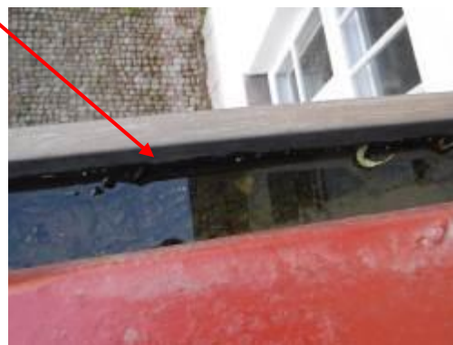
Kuvat 42, 43 ja 44. Sadevesikouruun on lammikoitunut vettä.
