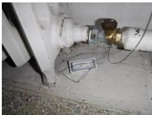
Kuvat 85 ja 86. Termostaattien lämpötila-anturit ovat lattialla kiinnittämättä.
