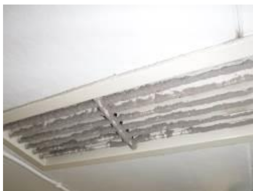
Kuvat 76 ja 77. Yläkerrassa ilmanvaihtoventtiilit ovat likaisia.
