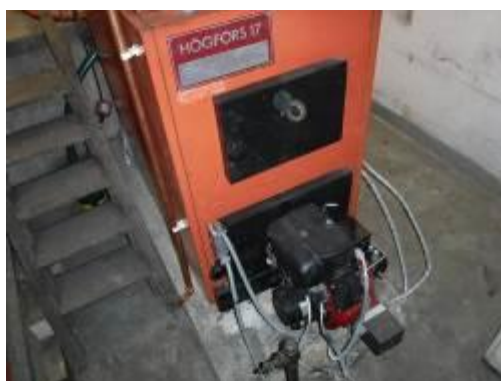
Kuvat 80 ja 81. Lämmönjakohuoneessa on kaksi öljykattilaa, joista toinen oli tarkastushetkellä käytössä.
