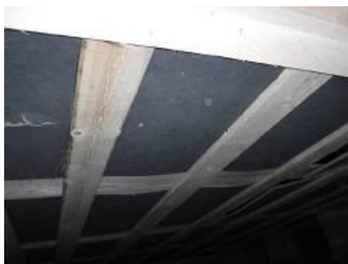
Kuvat 6 ja 7. Alapohjan rakenteita on paikoitellen uusittu vesivahinkojen vuoksi.
