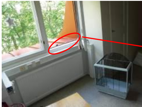
Kuvat 29 ja 30. Kuvassa näkyy ikkunan ja vesikaton liitos yläkerrassa. Liitos vaikuttaa epätiiviiltä.
