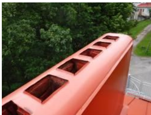
Kuvat 93 ja 94. Sadehattu puuttuu ja hormi on yläpäästään rapautunut.
