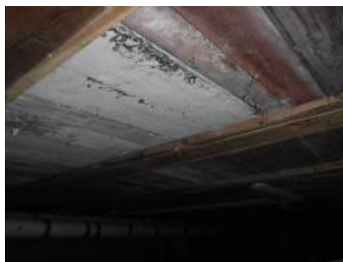
Kuvat 6 ja 7. Alapohjan rakenteita on paikoitellen uusittu vesivahinkojen vuoksi.
