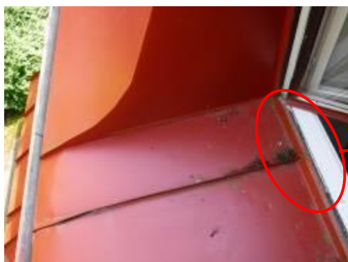
Kuvat 27 ja 28. Kuvassa näkyy ikkunan ja vesikaton liitos yläkerrassa. Liitos näyttää epätiiviiltä.
