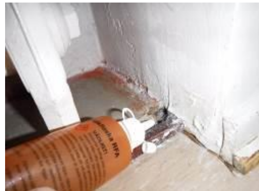
Kuvat 63 ja 64 . Unikkojen nurkkahuoneessa on ilmavuoto ulkoseinän ja välipohjan liittymässä.
