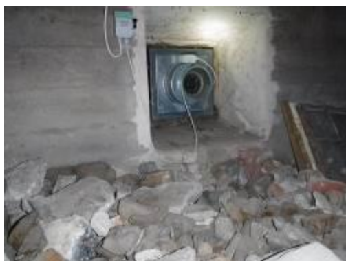
Kuva 9. Ryömintätilan alipainetuuletin.
