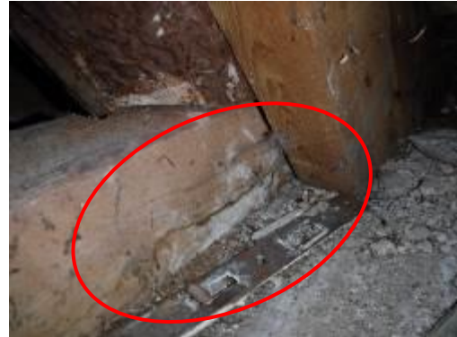
Kuvat 46 ja 47. Vanhoja kosteusjälkiä vesikaton kantavissa puurakenteissa.
