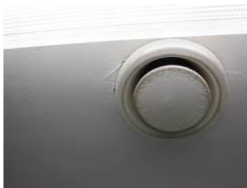
Kuvat 76 ja 77. Yläkerrassa ilmanvaihtoventtiilit ovat likaisia.
