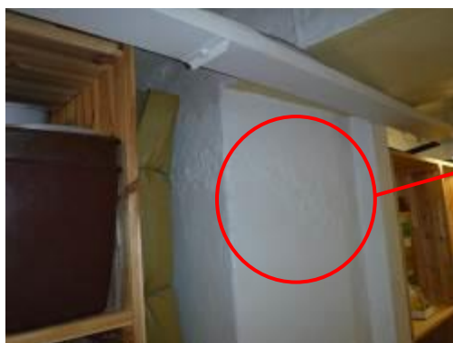
Kuvat 53 ja 54. Kantava pilarin yläosasta todettiin korkeita kosteuslukemia.
