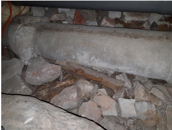
Kuva 1. Organista jätettä ryömintätilan pohjalla.
