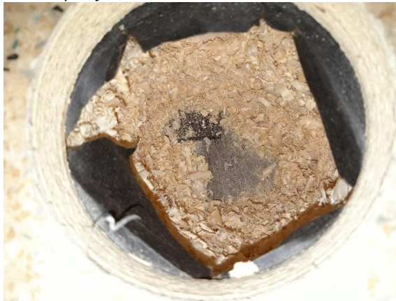
Kuva 37. Välipohjan rakenneavaus RA.05-VP1
