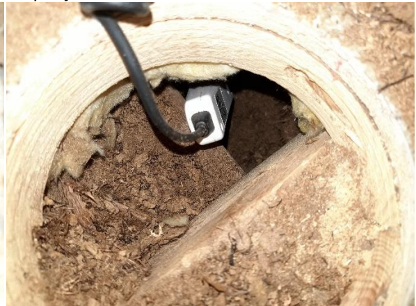
Kuva 38. Välipohjan rakenneavaus RA.06-VP2
