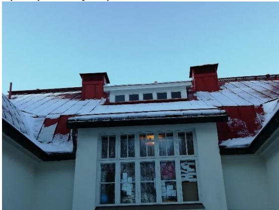
Kuva 33. Peltikatteen maalipinta näytti siistiltä
