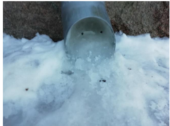
Kuva 32. Syöksytorvet jäätyneet
