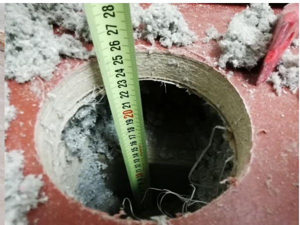
Kuva 36. Alapohjan rakenneavaus RA.04-AP4
