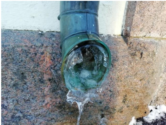
Kuva 31. Syöksytorvet jäätyneet
