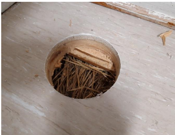
Kuva 35. Alapohjan rakenneavaus RA.03-AP3
