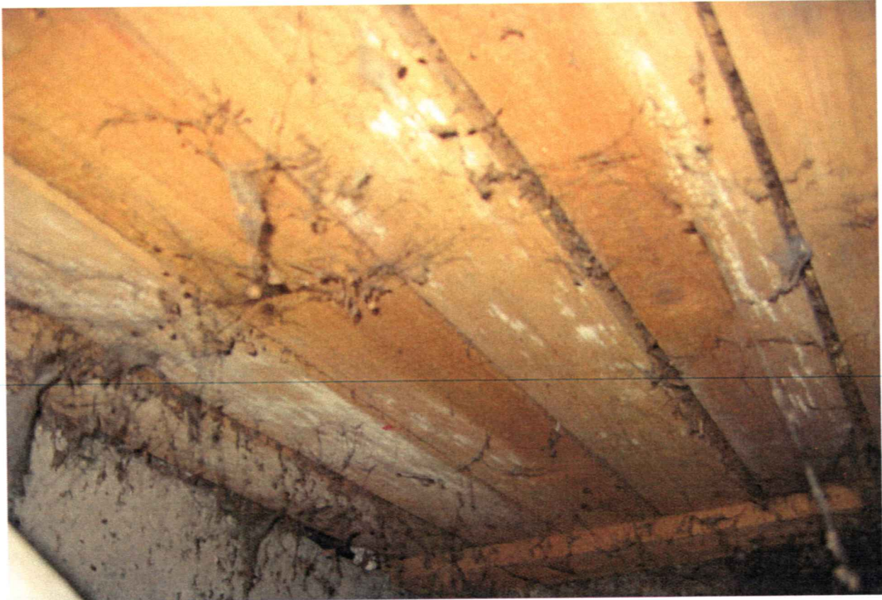
Kuva 17 Alapohjatila 3. Lattian aluslaudoitusta.
