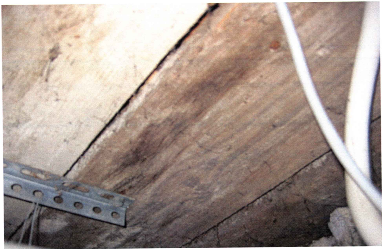
Kuva 17A Alapohjatila 3. Lattian aluslaudoitusta
