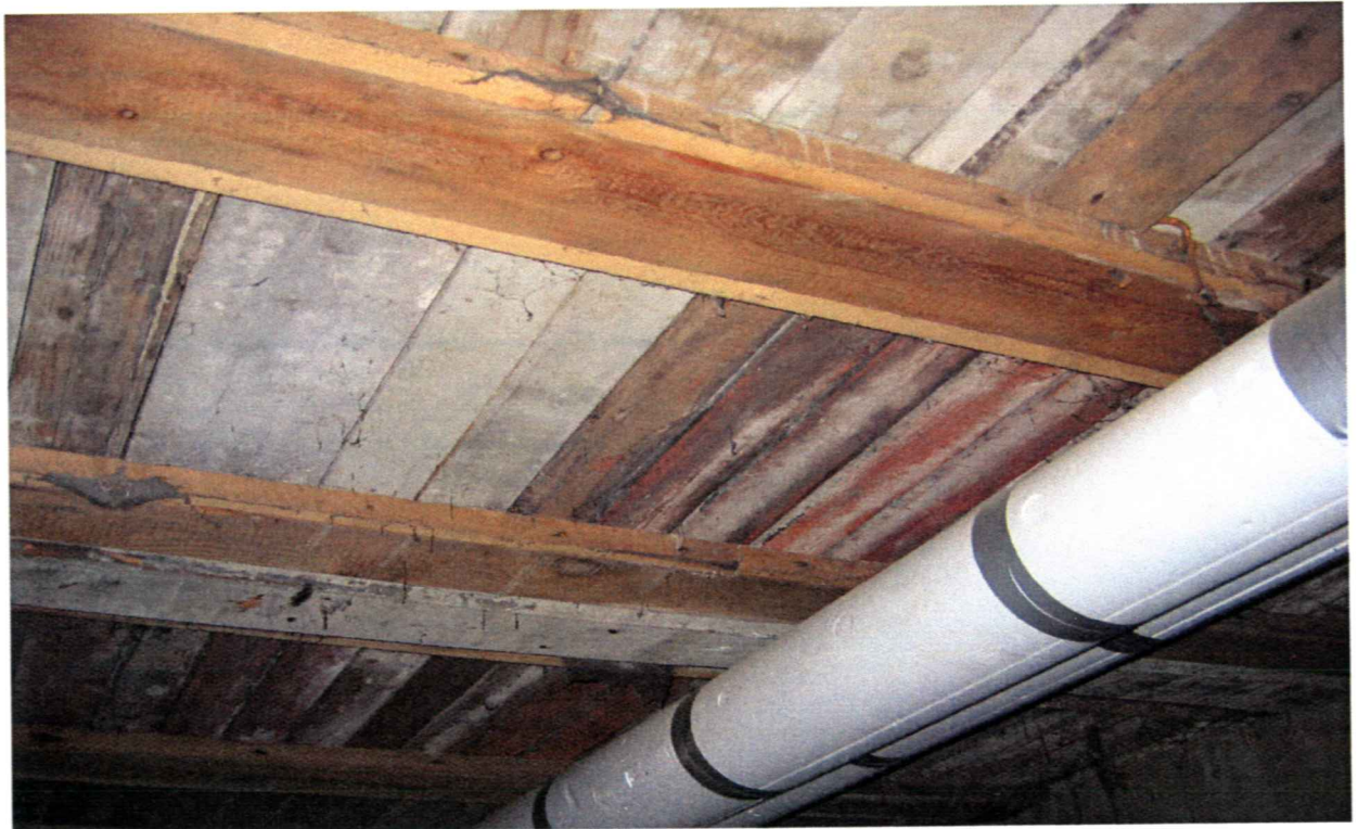
Kuva 10 Alapohjatila 2. Tilan puurakenteita. Näkyvät rakenteet vähintään tyydyttävässä kunnossa.
