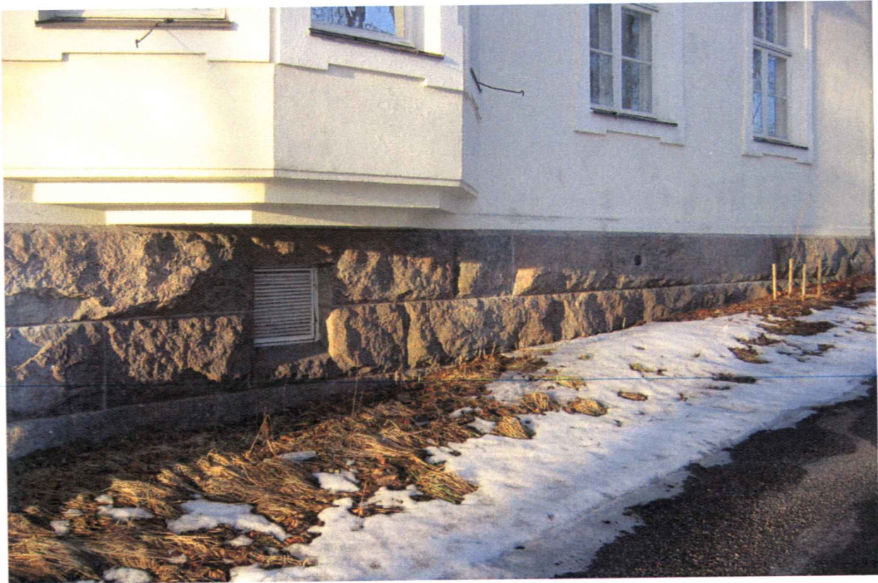
Kuva 26 Alapohjatilan 2 käyntiluukku on erkkerin alla.
