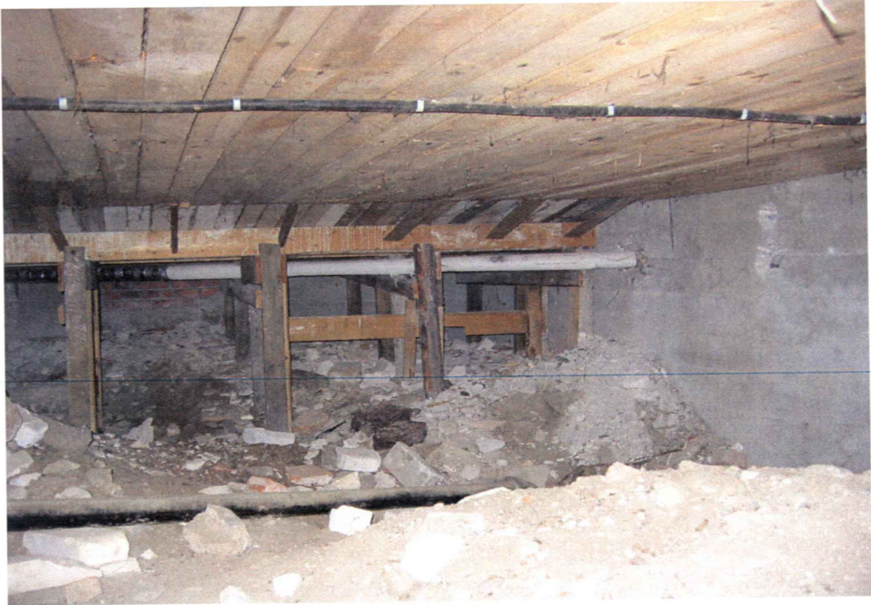
Kuva 20 Alapohjatila 6. Puurakenteet pääosin kunnossa.
