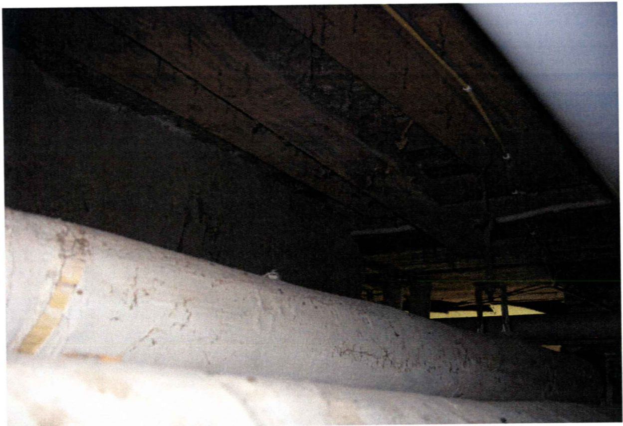
Kuva 16 Alapohjatila 3. Irronnut aluslaudoitus kiinnitetään.
