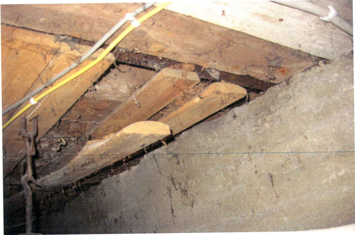
Kuva 13 Alapohjatila 3. Aluslaudoitus irronnut.
