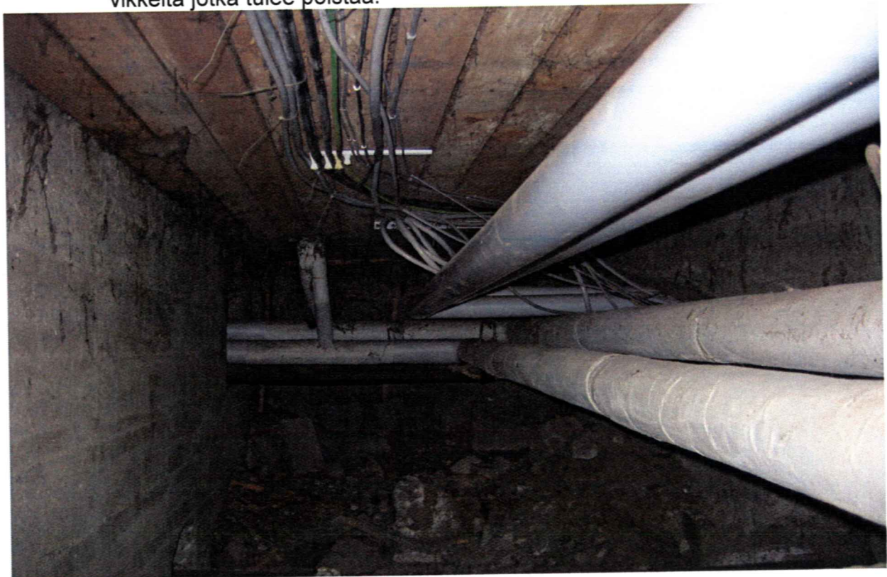
Kuva 12 Alapohjatila 3. Putkia ja kaapelointia tilan yläosassa.
