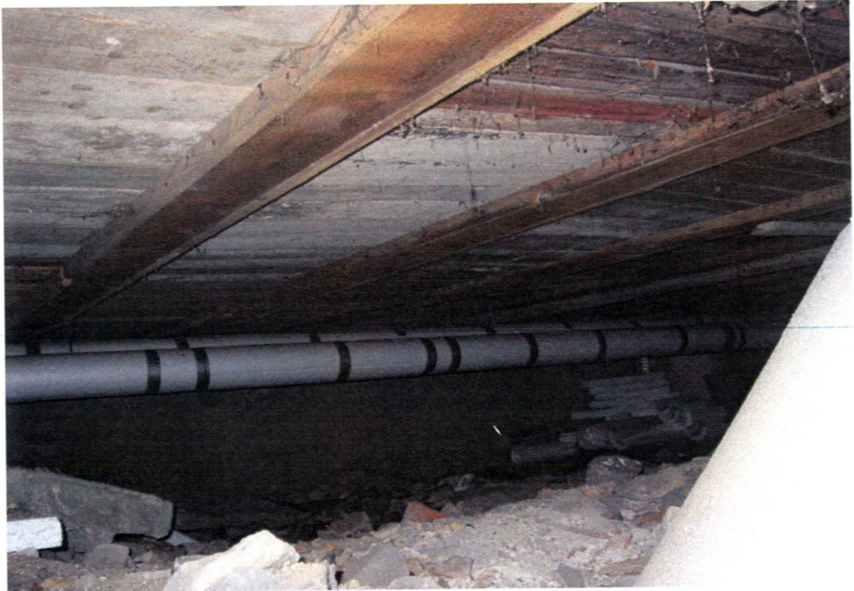
Kuva 9 Alapohjatila 2. Tilan alaosan rakenteita kuvattuna kulkuaukosta kohti käyntiluukkua. Näkyvät rakenteet vähintään tyydyttävässä kunnossa.
