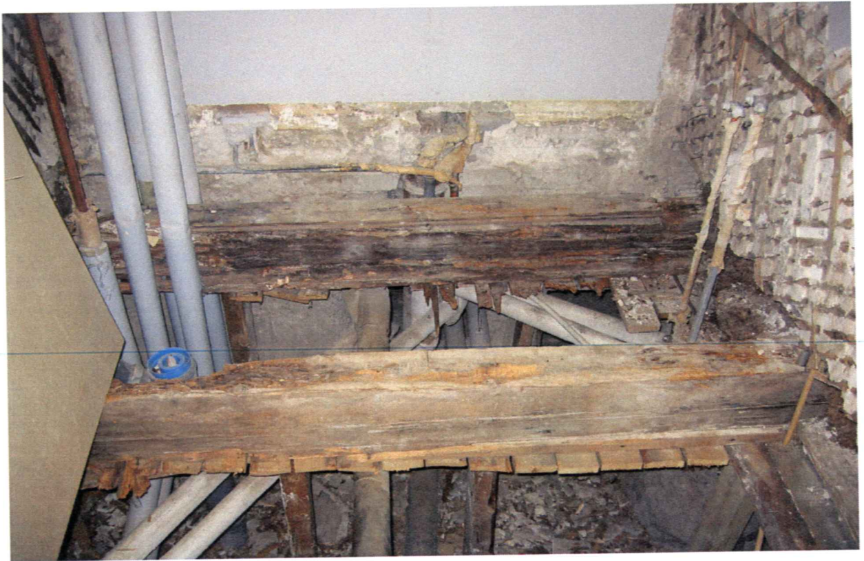
Kuva 3 Alapohjatila 1. Aiemmin avattu lattiarakenne pesuhuoneen kohdalla.
