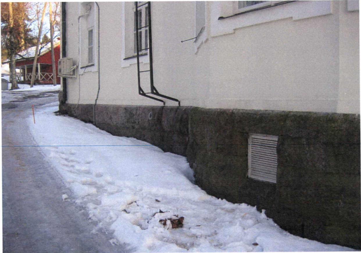
Kuva 28 Alapohjajalan 6 käyntiluukku ja 1 kpl tilan 5 tuuletusventtileitä.
