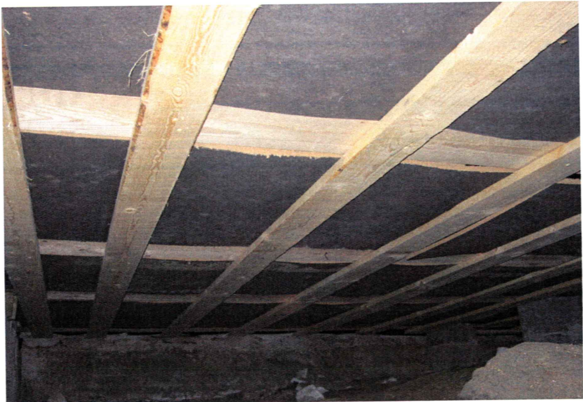
Kuva 8 Alapohjatila 2. Tilan yläosan lattiarakenne on uusittu.
