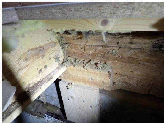
Kuvat 2 ja 3. Rakenneavaus 2 tehtiin ryömintätalaiseen alapohjarakenteeseen. Alapohjan eristetilassa oli pieneläinten jätöksiä, mineraalivillassa tummentumia ja kantavissa puurakenteissa kosteusjälkiä.
