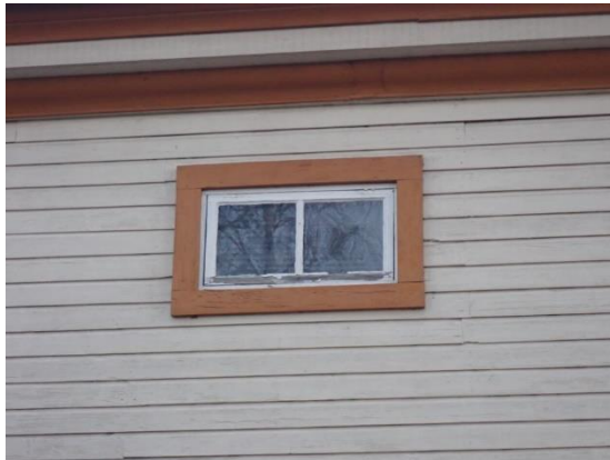
Kuvat 36 ja 37. Rakennuksen ullakkokerroksen ikkunat ovat huonokuntoisia; ulompien ikkunapuitteiden alaosissa on kosteus- ja lahovaurioita.
