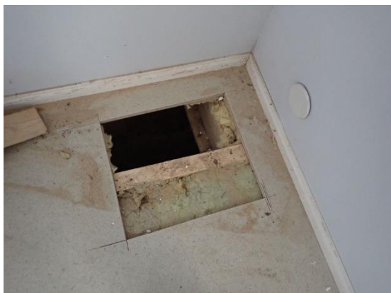
Kuvat 2 ja 3. Rakenneavaus 2 tehtiin ryömintätalaiseen alapohjarakenteeseen. Alapohjan eristetilassa oli pieneläinten jätöksiä, mineraalivillassa tummentumia ja kantavissa puurakenteissa kosteusjälkiä.
