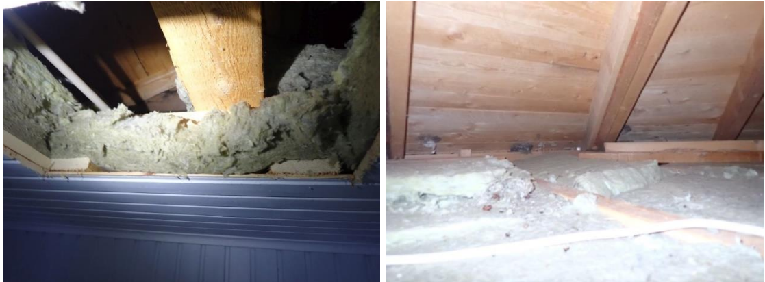
Kuvat 49 ja 50. Pääsisäänkäynnin kuistin yläpohjanaan tehtiin rakenneavaus 17.
