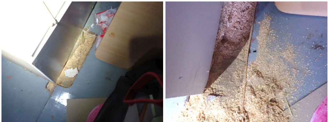
Kuvat 41 ja 42. Ullakkokerroksen etelän puoleisessa päädyssä sijaitsevan huoneen lattiaan tehdyn rakenneavauksen 16 kohdalla ei ollut aistinvaraisesti todettavissa viitteitä vaurioista.
