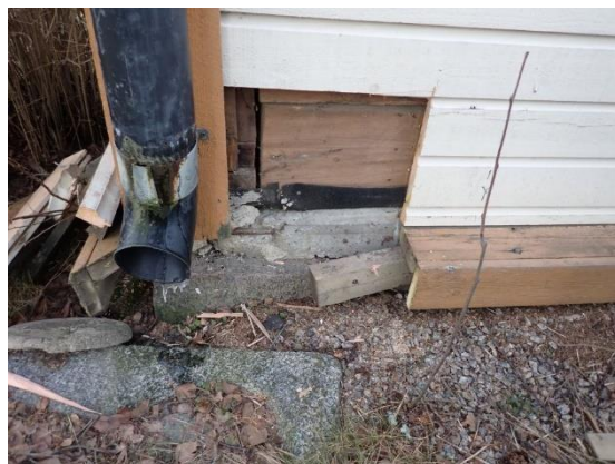
Kuvat 28 ja 29. Rakenneavausten 10 ja 11 kohdilla on ryömintätilan tuuletusaukot, jotka eivät ole riittäviä tuulettamaan ryömintätilaa. Rakenneavausten 11 ja 12 kohdilla ei havaittu viitteitä hirsien lahovaurioista.
