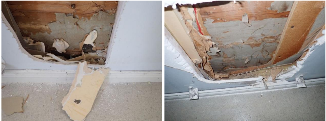
Kuvat 22 ja 23. Rakenneavaukset 8 ja 9 tehtiin ensimmäisen kerroksen ulkoseiniin sisäkautta.
