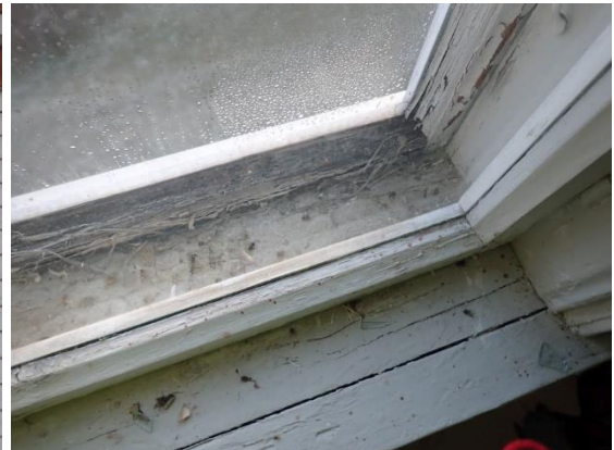
Kuvat 36 ja 37. Rakennuksen ullakkokerroksen ikkunat ovat huonokuntoisia; ulompien ikkunapuitteiden alaosissa on kosteus- ja lahovaurioita.
