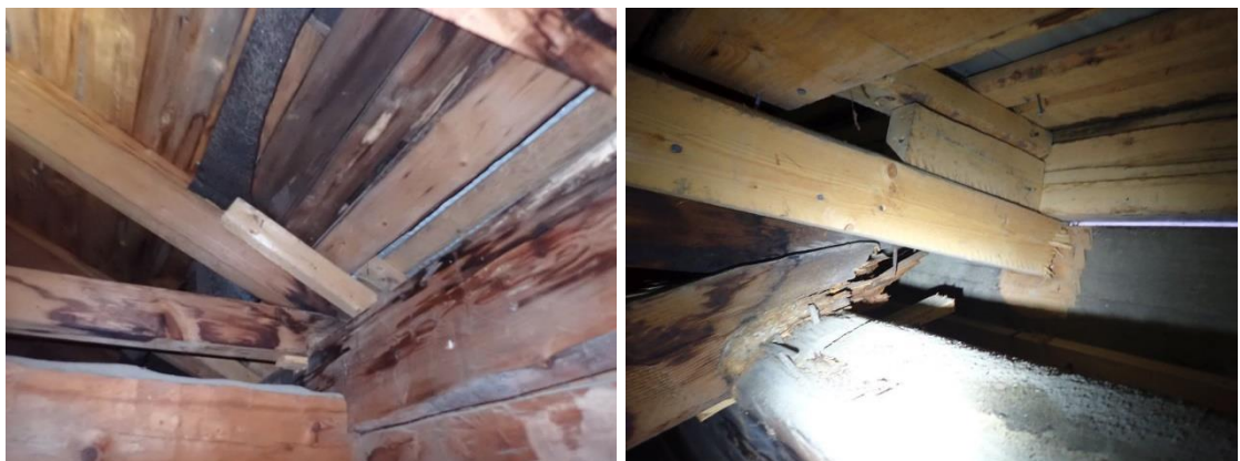
Kuvat 55 ja 56. Vesikaton kantavat rakenteet ovat pääosin hyvässä kunnossa. Vaurioita havait- tiin lähinnä räystäiden läheisyydessä, jossa on tehty myös vauriokorjauksia.
