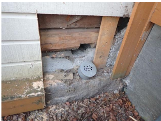
Kuvat 28 ja 29. Rakenneavausten 10 ja 11 kohdilla on ryömintätilan tuuletusaukot, jotka eivät ole riittäviä tuulettamaan ryömintätilaa. Rakenneavausten 11 ja 12 kohdilla ei havaittu viitteitä hirsien lahovaurioista.
