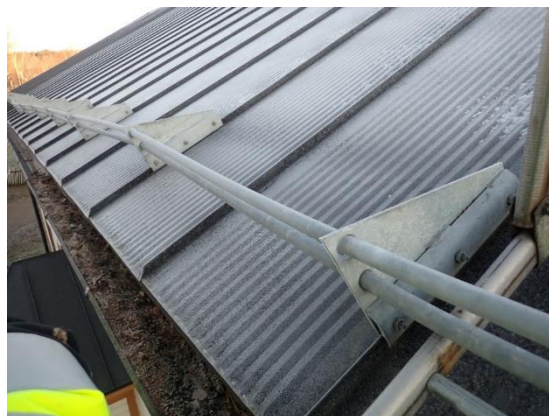
Kuvat 61 ja 62. Yleiskuva talotikkaista ja vesikatteelta, sekä lumiesteistä.
