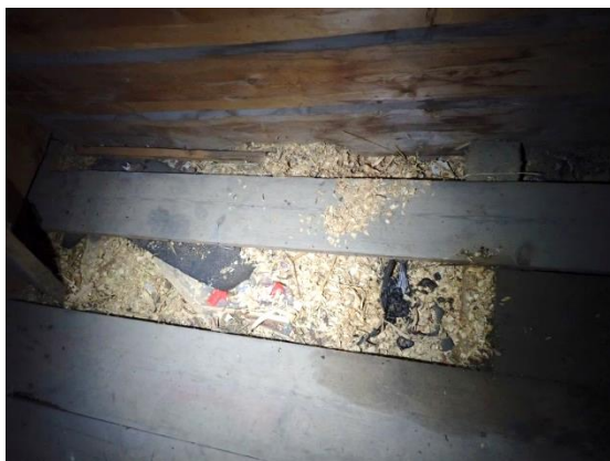
Kuvat 59 ja 60. Ullakkokerroksen eristetilassa on kuollut lintu lankkulattian alla. Kreosoottiöljy on mahdollinen "kosteusjälkien" aiheuttaja.
