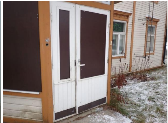
Kuvat 38 ja 39. Havaintojen perusteella rakennuksen ensimmäisen kerroksen ikkunat ja ovet on uusittu rakennuksen peruskorjauksessa vuonna 1987. Ikkunat ovat sisälle päin aukeavia kaksipuitteisia kolmilasisia ikkunoita (MSE-ikkuna), joiden sisemmässä puitteessa on kaksilasin umpiolasielementti.
