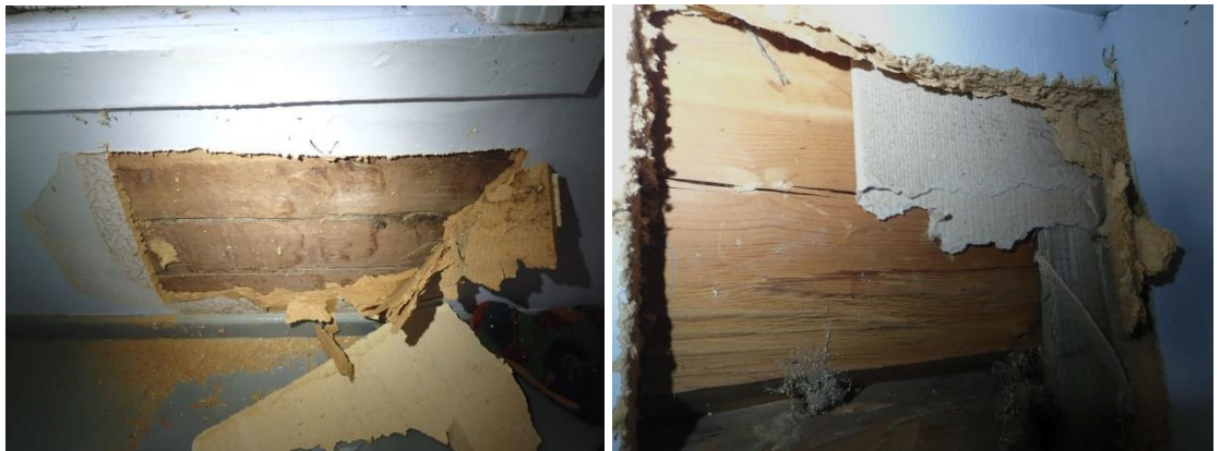
Kuvat 24 ja 25. Rakenneavaus 13 tehtiin ullakkokerroksen ulkoseinään rakennuksen etelän puoleisessa päädyssä sijaitsevan huoneen kohdalle.
