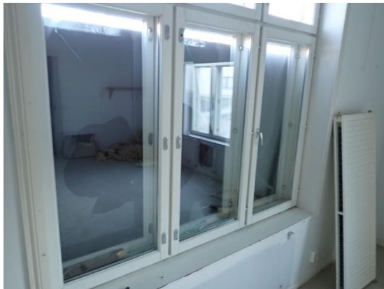
Kuvat 38 ja 39. Havaintojen perusteella rakennuksen ensimmäisen kerroksen ikkunat ja ovet on uusittu rakennuksen peruskorjauksessa vuonna 1987. Ikkunat ovat sisälle päin aukeavia kaksipuitteisia kolmilasisia ikkunoita (MSE-ikkuna), joiden sisemmässä puitteessa on kaksilasin umpiolasielementti.
