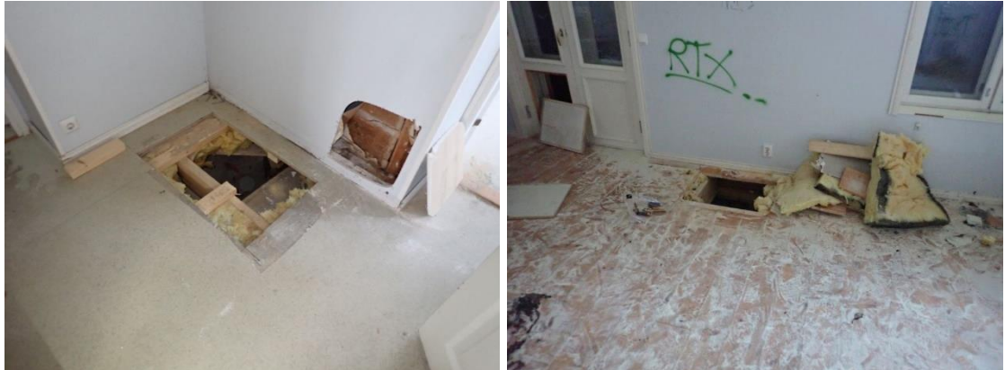
Kuvat 4 ja 5. Rakenneavausten 3 ja 4 kohdilta otettiin alapohjan mineraalivillaeristeestä materiaalinäytteet (MN 3 ja MN 4) mikrobianalyysiin (ks. kohta 6.5.1) tuulensuojalevyn päältä.
